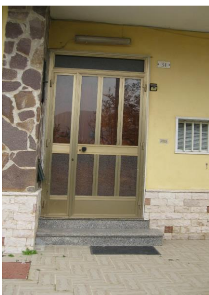
- Accesso all'unità' abitativa -
