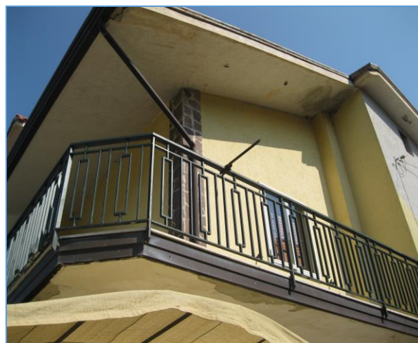
- Particolare cornicioni e sottobalconi -
