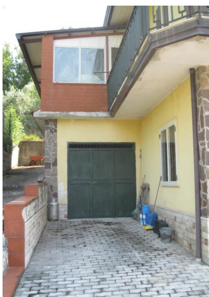
- Accesso al garage -
