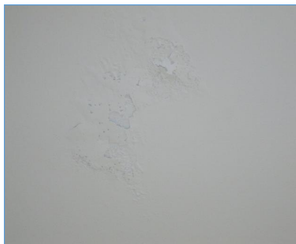
- Piano Primo: Particolare soffitto vano scala -
