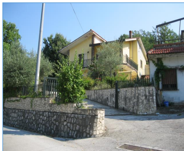
- Vista fabbricato con annessa corte -
