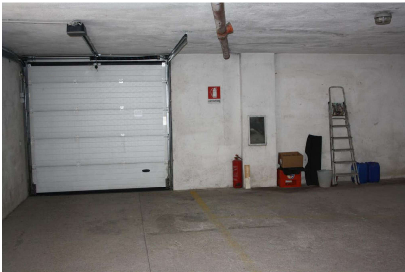
Porta carrabile di accesso al parcheggio coperto.
