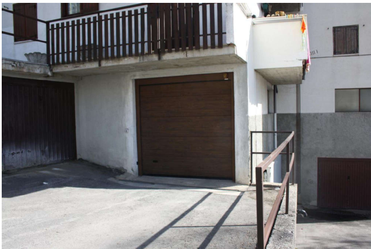
Porta carrabile d'ingresso parcheggio coperto.
