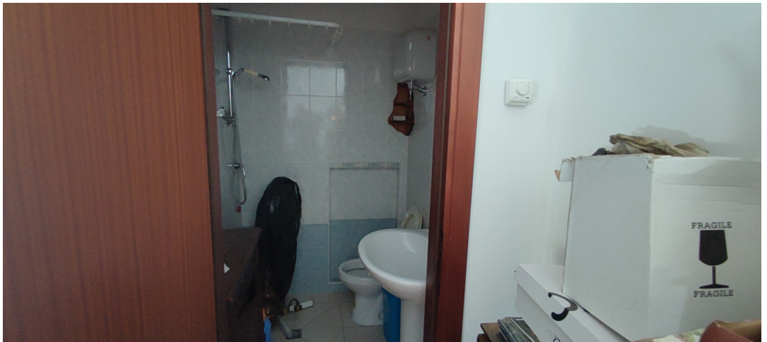
Foto 12 bagno piano terra
