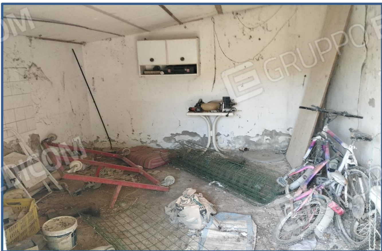
Foto 18 – proservizio al centro della corte comune
