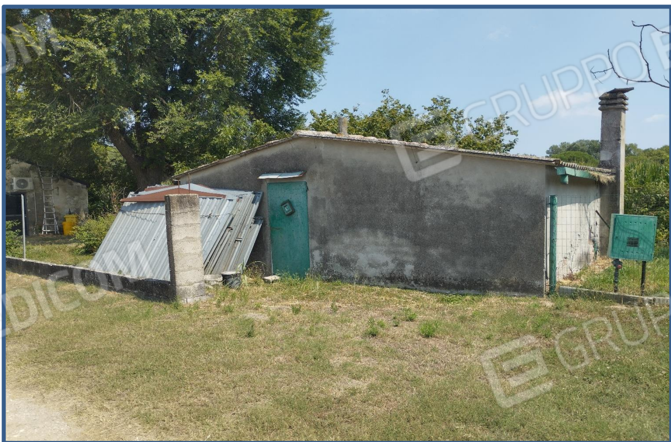
Foto 16 – proservizio al centro della corte comune
