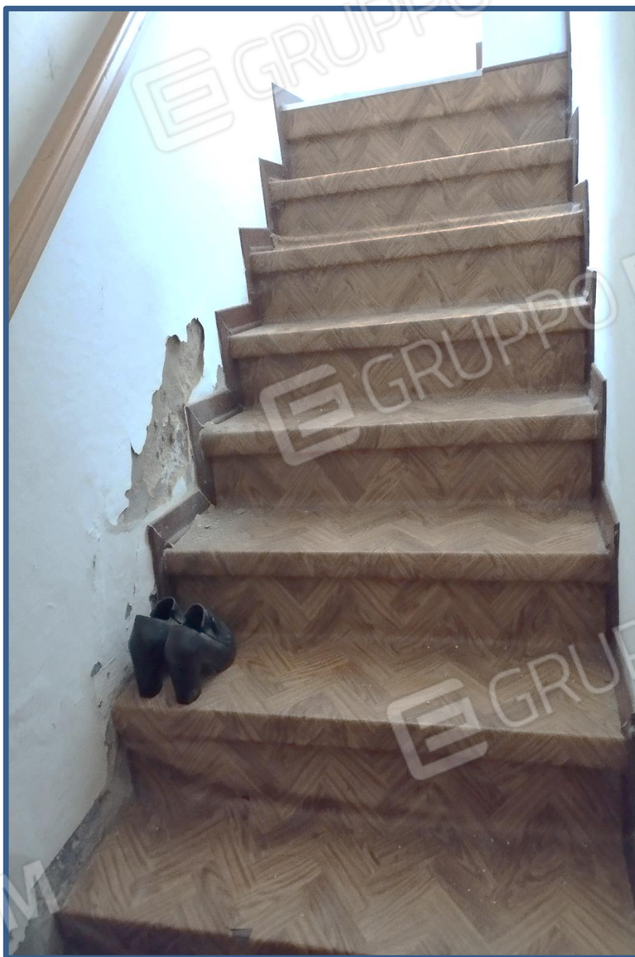
Foto 9 – scala accesso piano primo
