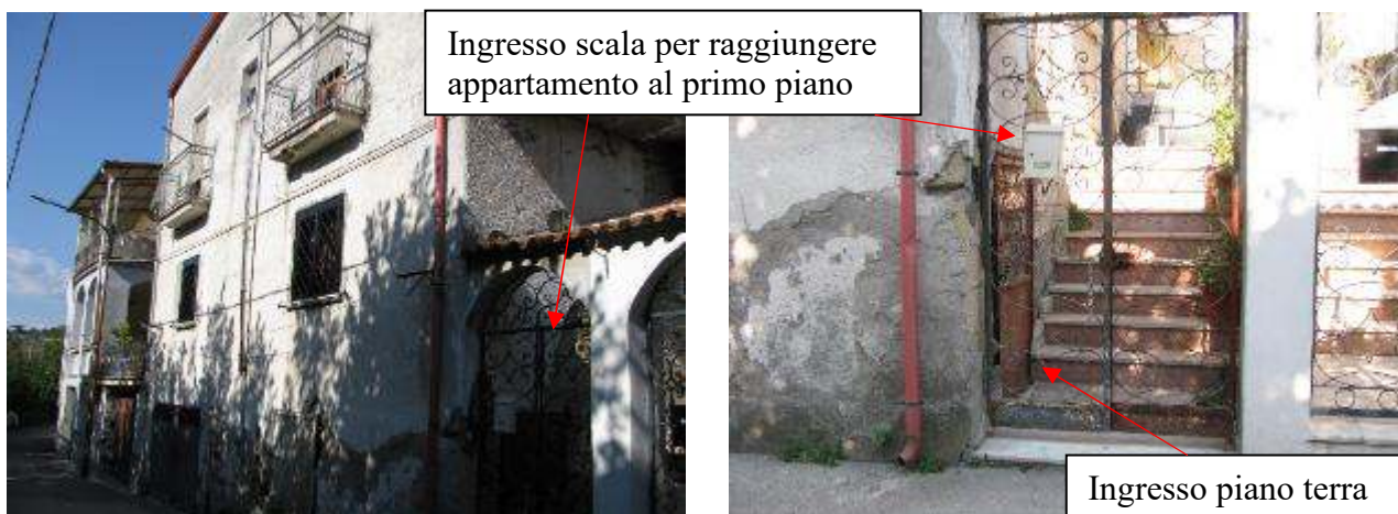
Viste esterne dell'unità abitativa da via Carità
