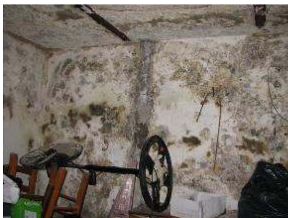
Viste dei locali a piano terra
