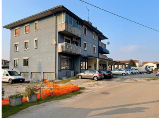
Esterno: vista Sud/Est
