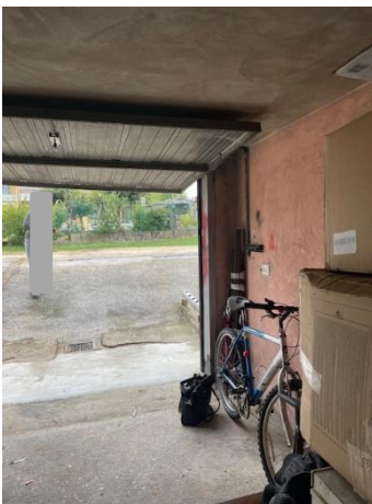
autorimessa vista su accesso Sud
