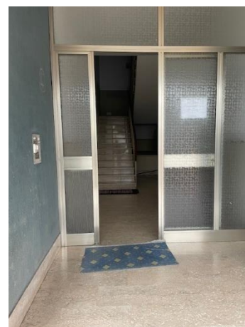
Esterno: atrio ingresso pianterreno (Lato Est)
