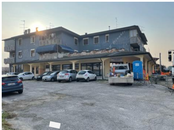
Esterno: vista Nord
