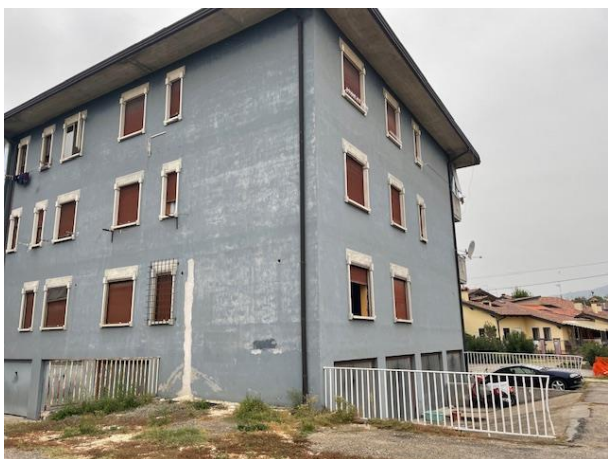
Esterno: vista Sud/Ovest
