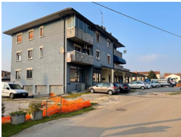
Esterno: vista Sud/Est
