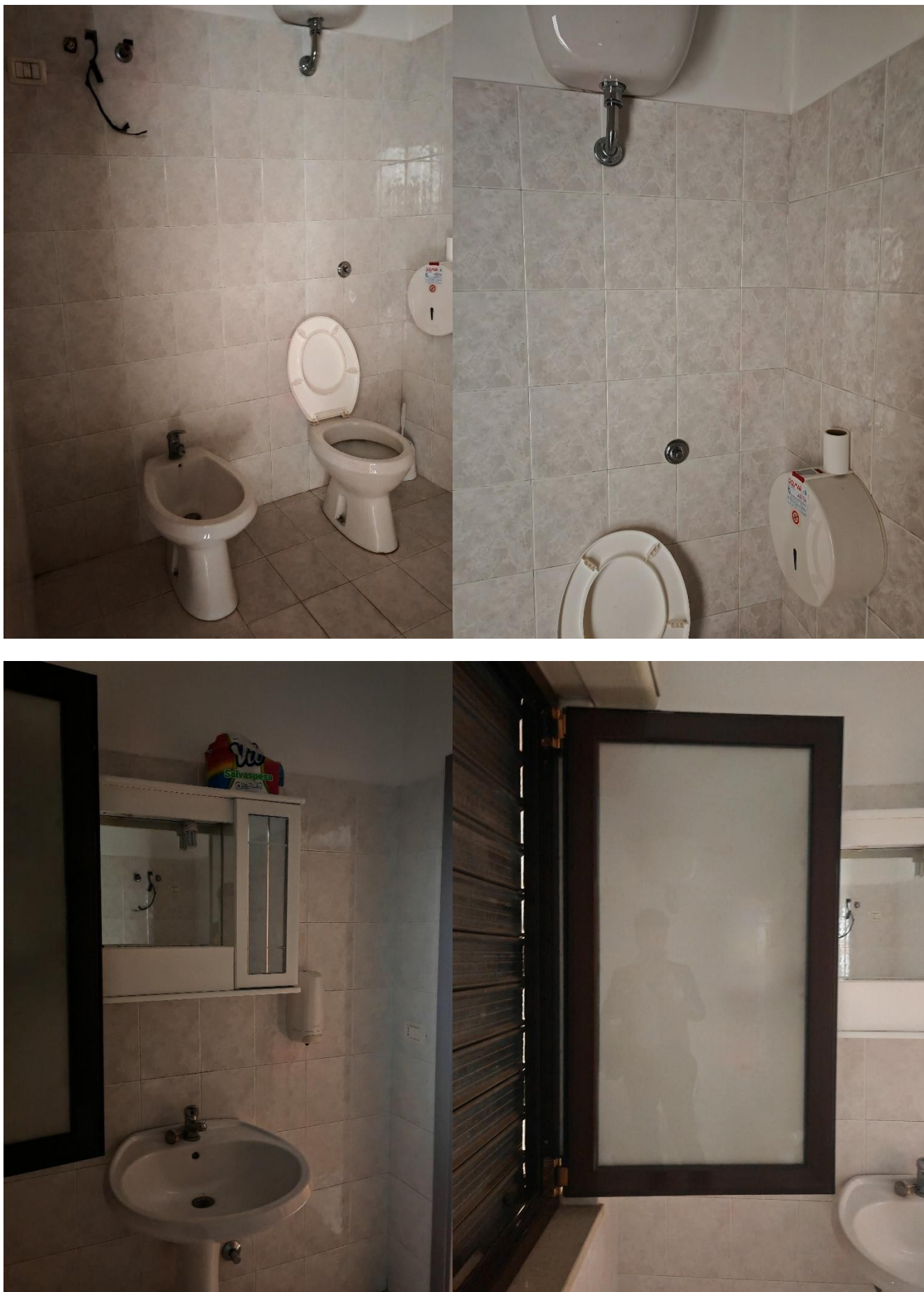
Figura 9: interno Locale Commerciale – retro negozio (wc)
