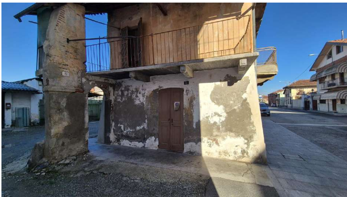
Piano Terreno ingresso al locale abitativo
