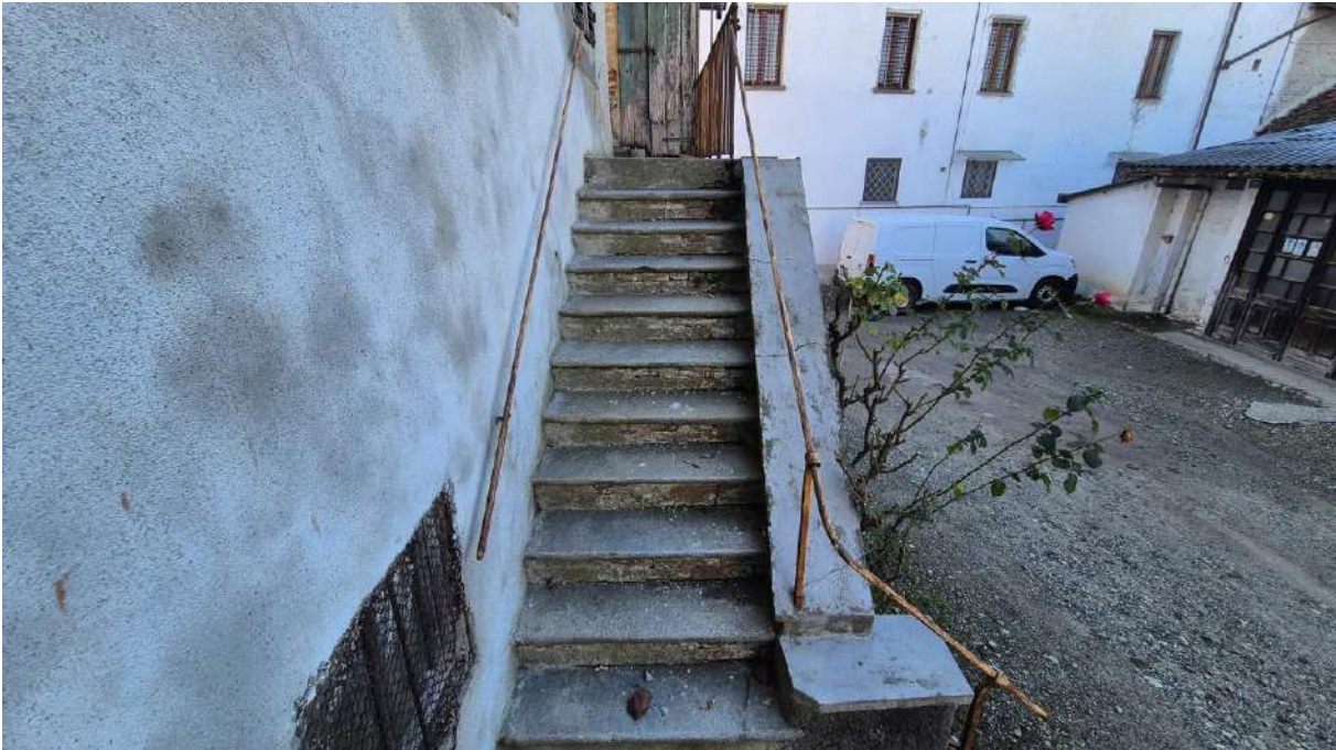
Vista esterna su scala per l'accesso alla proprietà
