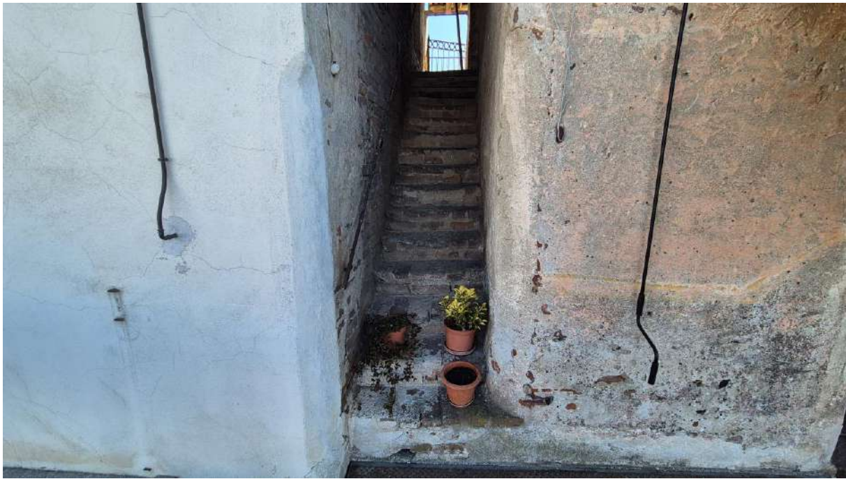
Piano Primo scala per l'arrivo al piano secondo
