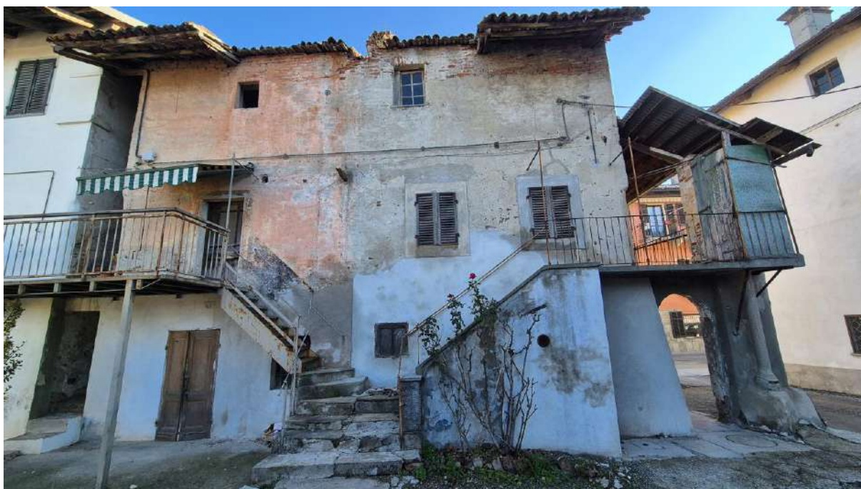
vista esterna del fabbricato da interno cortile
