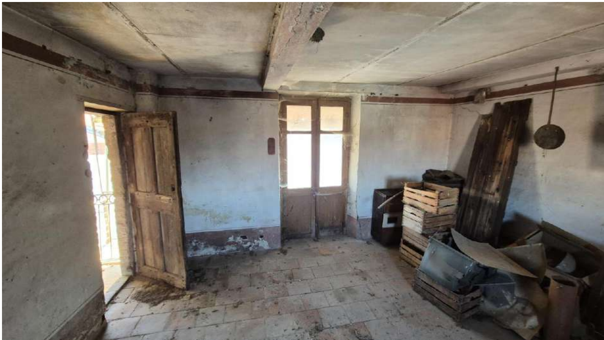
Piano Secondo locale unico
