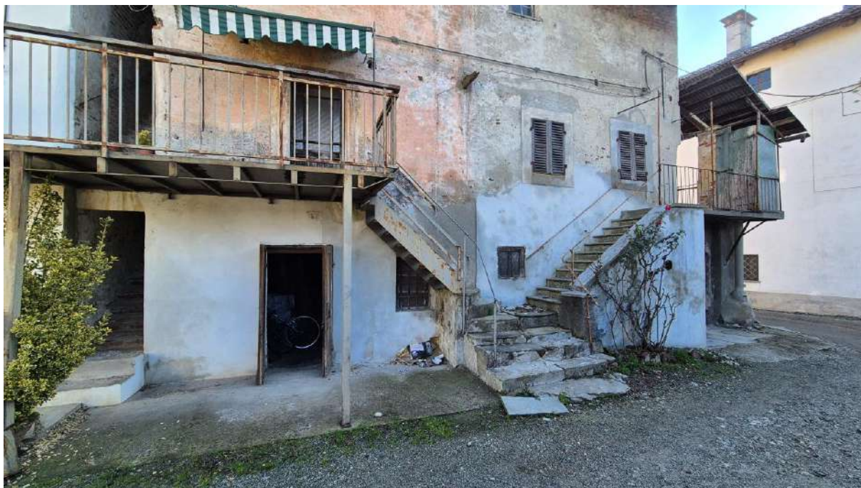
Vista esterna del fabbricato da interno cortile
