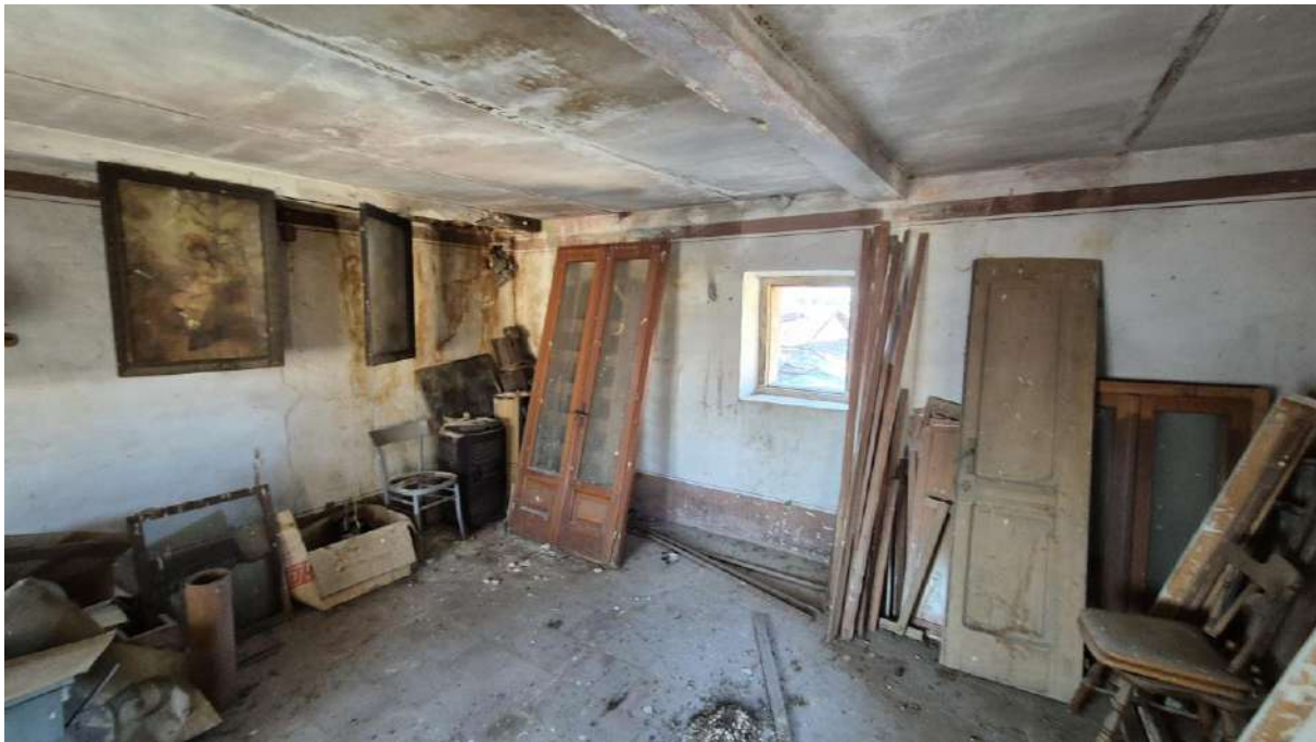
Piano Secondo locale unico
