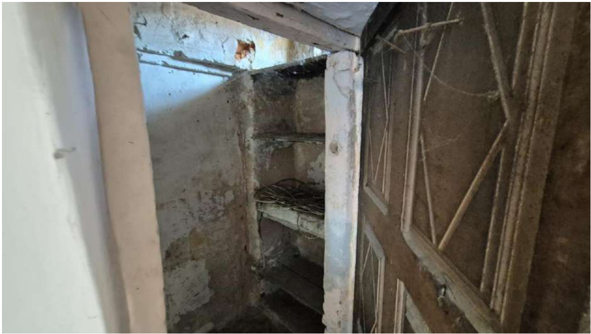
Piano Primo ripostiglio sottoscala
