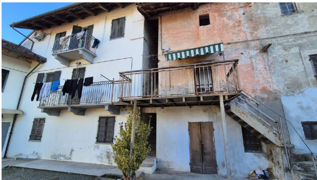
vista esterna del fabbricato da interno cortile
