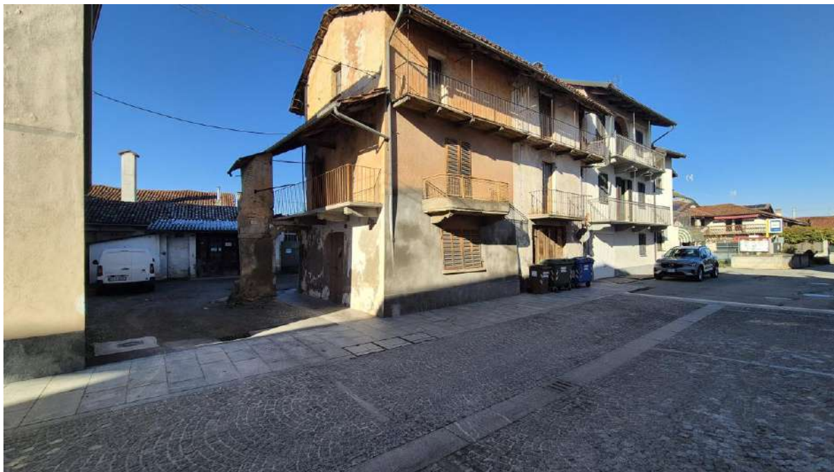
vista esterna del fabbricato
