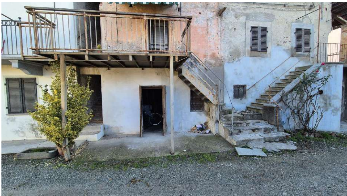
vista esterna del fabbricato da interno cortile
