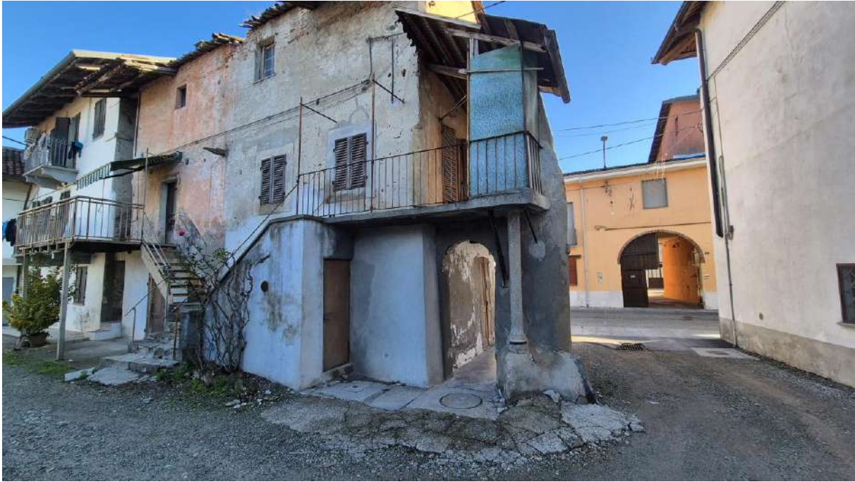
Vista esterna del fabbricato da interno cortile
