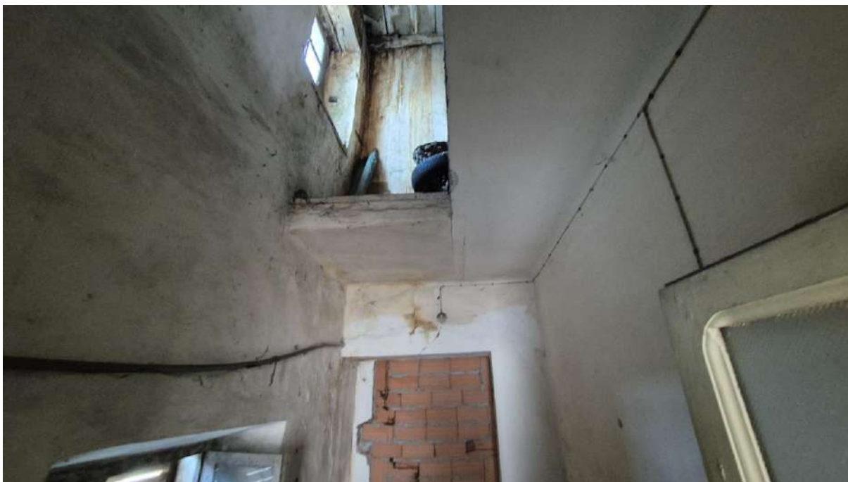
Piano Primo varco per l'accesso al piano secondo
