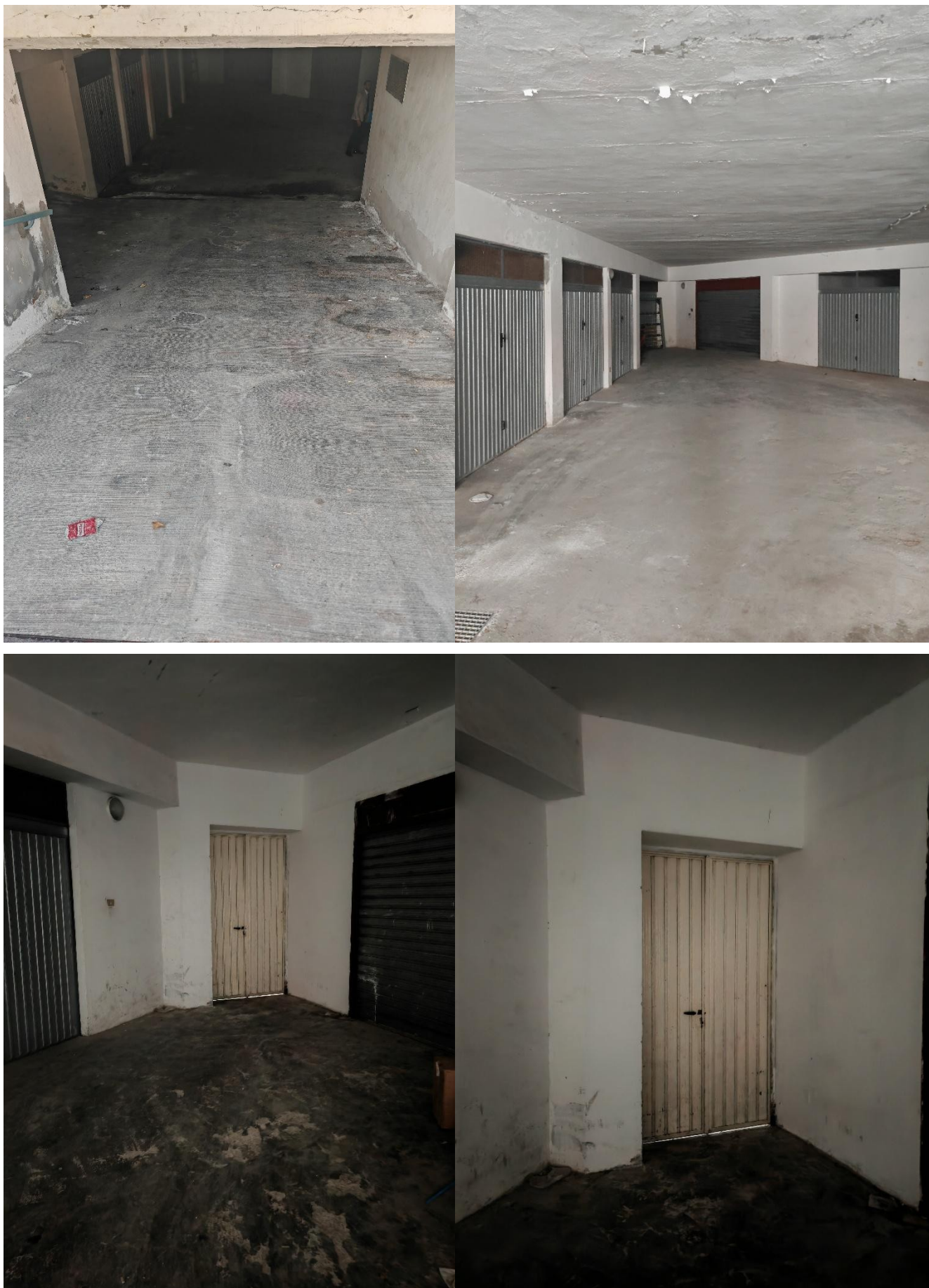
Figura 5: interno Locale Commerciale accesso dalla corsia box
