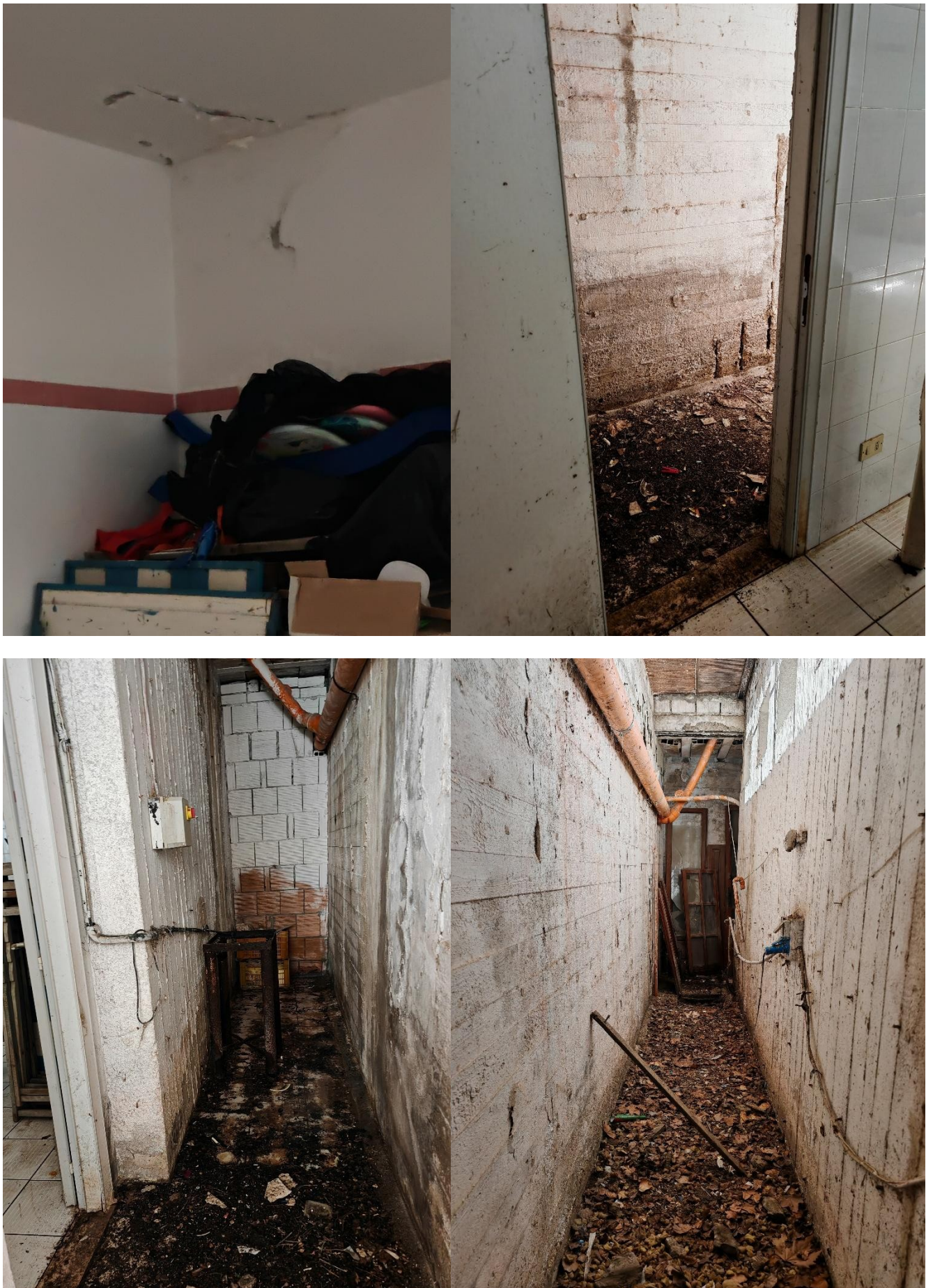
Figura 9: interno Locale Commerciale (cavedio)
