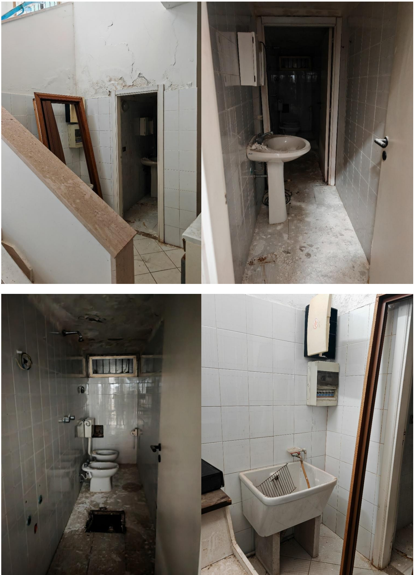
Figura 8: interno Locale Commerciale (zona wc)
