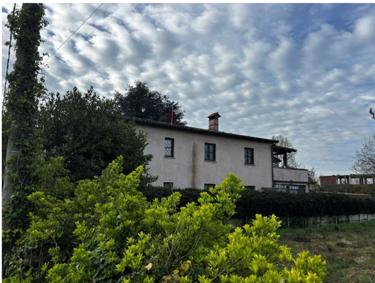
Vista esterna da nord-est
