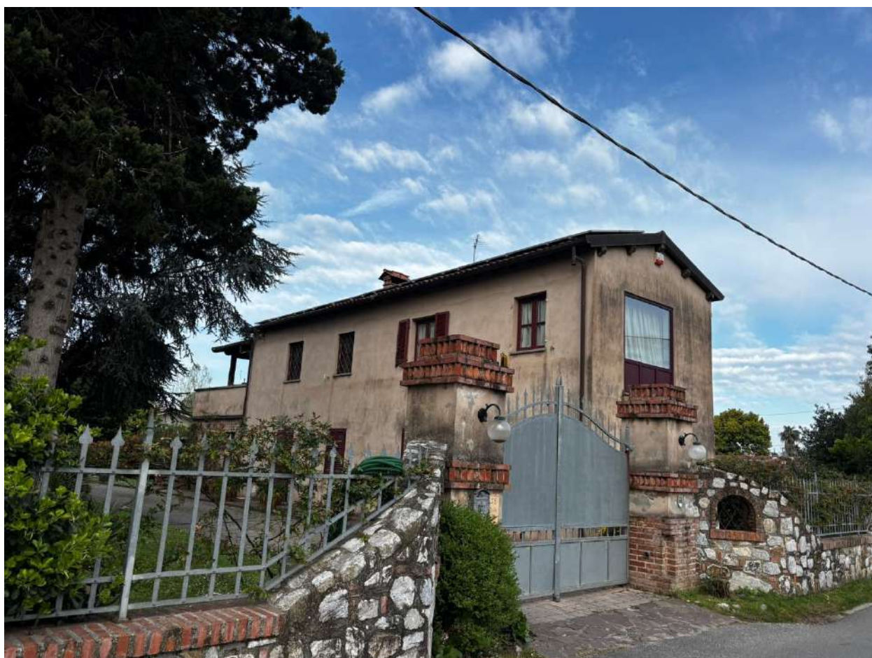
Vista esterna da est
