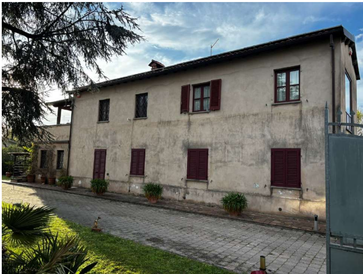
Vista prospetto sud
