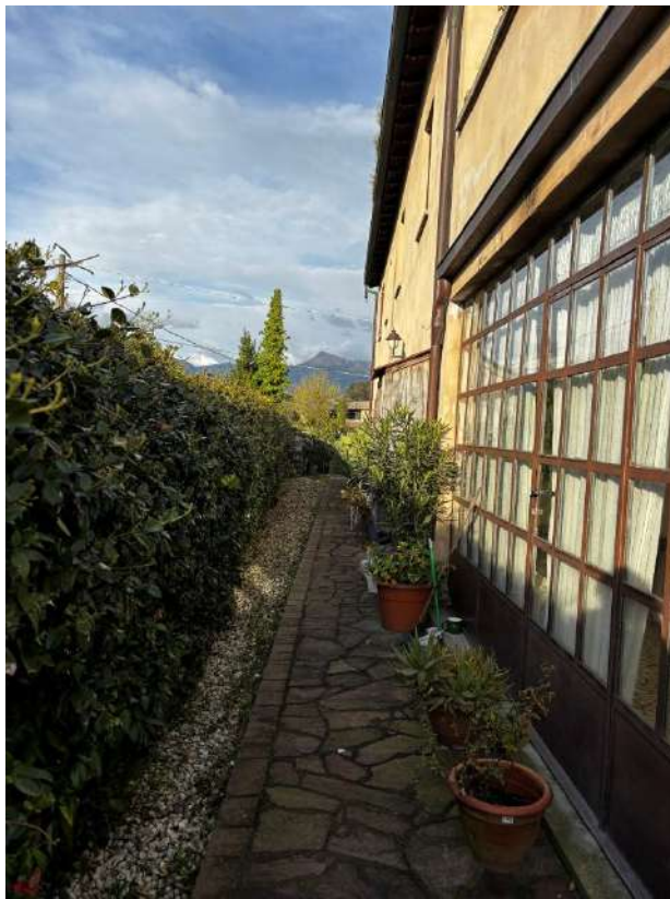
Vista esterna prospetto lato nord
