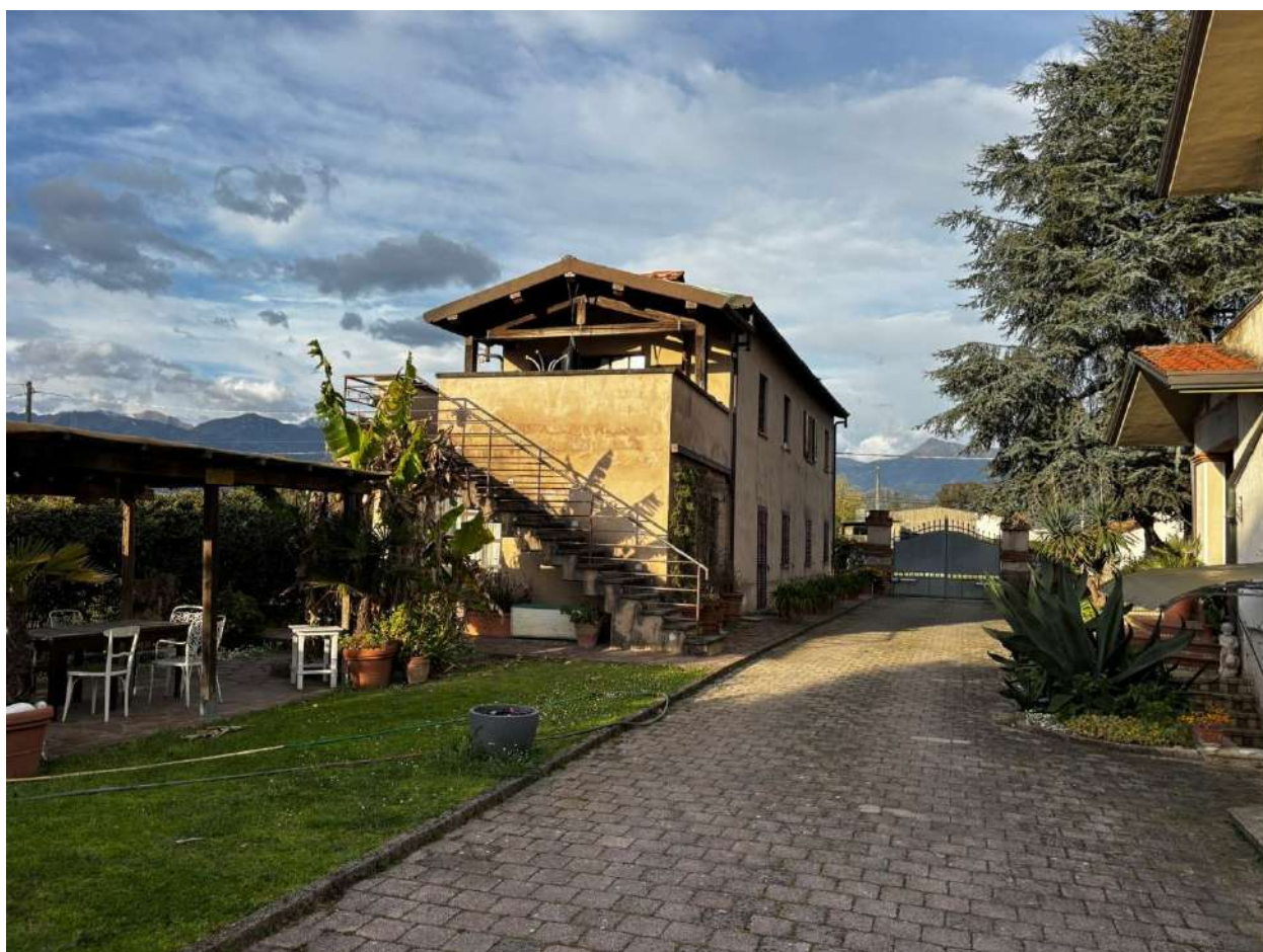
Vista prospetto ovest
