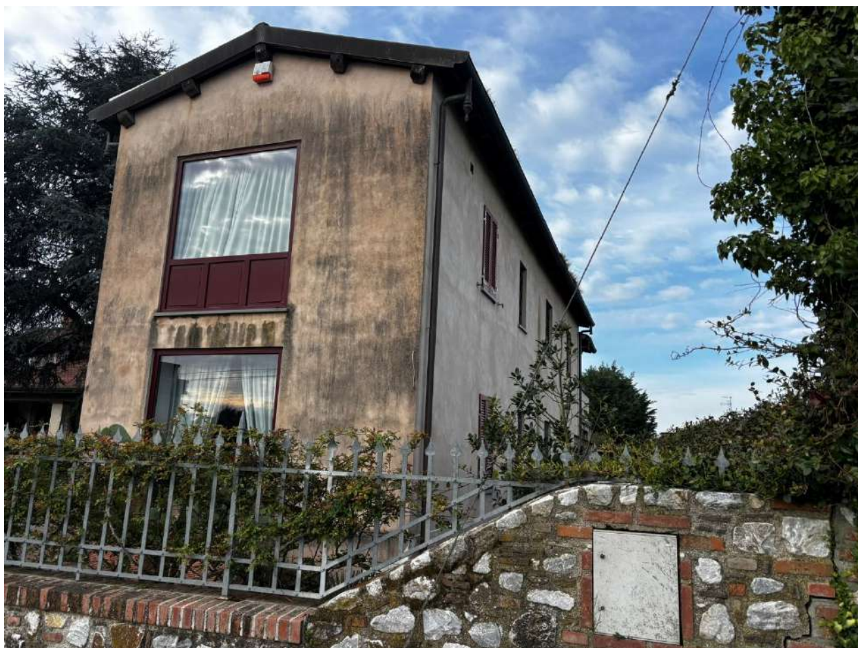
Vista esterna da est
