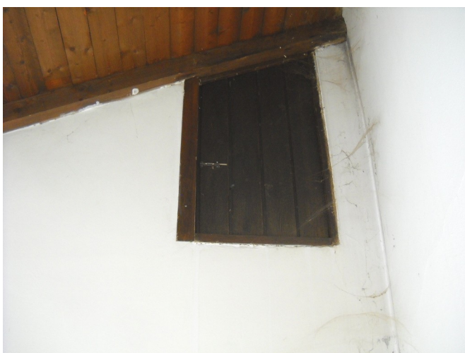
Accesso al sottotetto fabbricato adiacente c.n.36 via Tripoli
