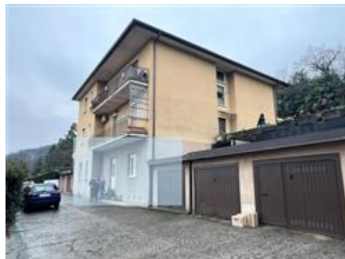
vista porzione di edificio interessata
