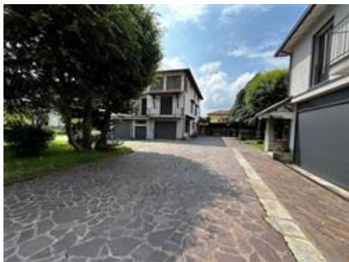
Il fabbricato visto dal mappale confinante n. 591
