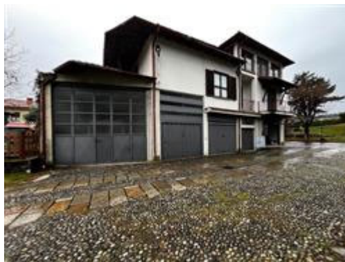
Il fabbricato visto dal mappale confinante n. 496
