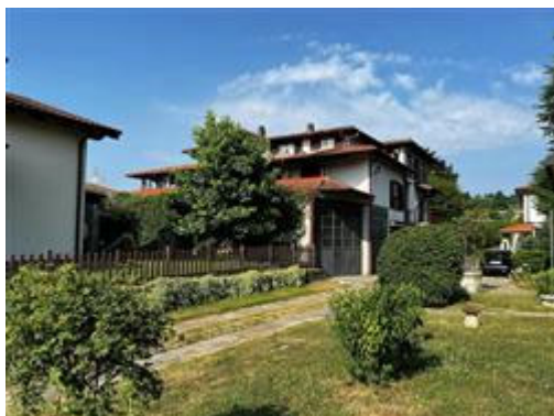
Il fabbricato visto dal mappale confinante n. 496
