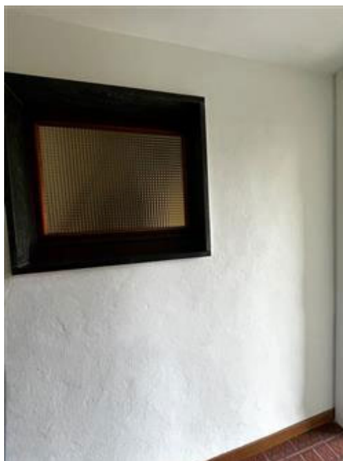
Il serramento di aerazione del vano scala , interno all'unità immobiliare
