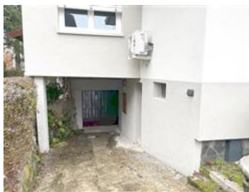
L'accesso carraio al piano interrato
