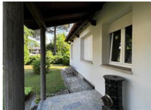
Il portico d'ingresso
