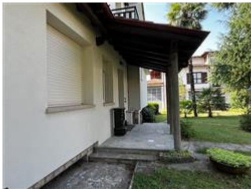
Il portico d'ingresso
