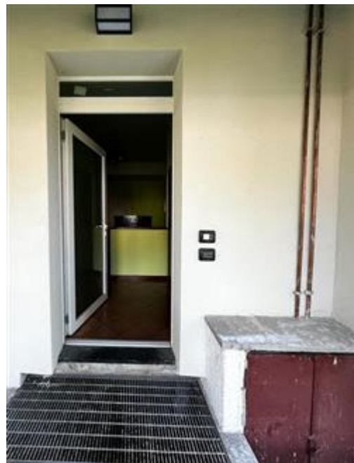
L'ingresso all'unità immobiliare
