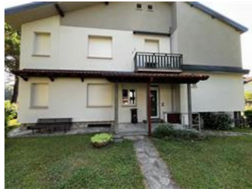
L'ingresso esclusivo dal porticato nel fronte ovest
