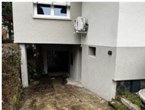
L'accesso carraio al piano interrato
