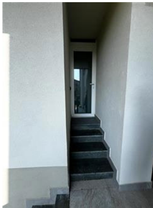
La scala di accesso all'unità immobiliare
