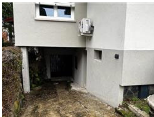
L'accesso carraio al piano interrato
