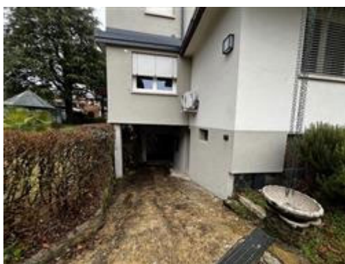
L'accesso carraio al piano interrato
