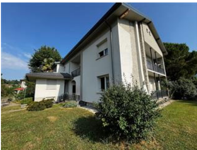
Il fabbricato con il corpo basso (a sinistra) ad uso studio
