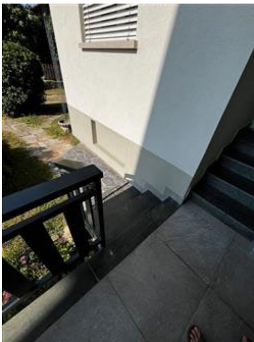
La scala di accesso alla quota d'ingresso condominiale.
