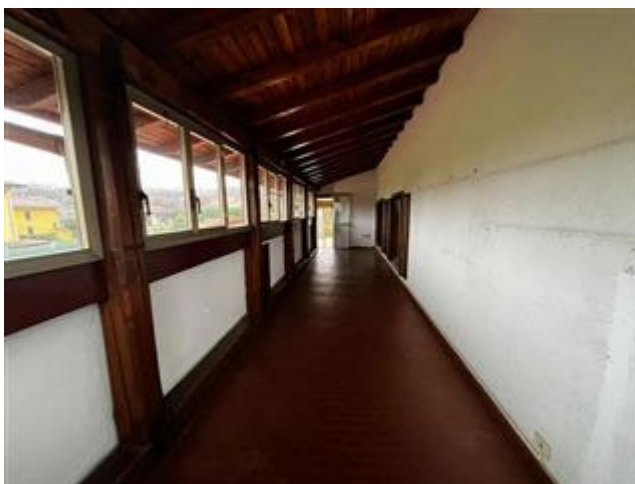
Il balcone perimetrale coperto e chiuso con serramenti
