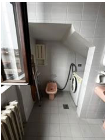
Porzione di bagno sottostante la scala condominiale
