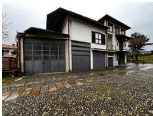
Il fronte lato nord
