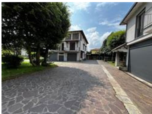
Il fabbricato visto dal confinante mappale 591
