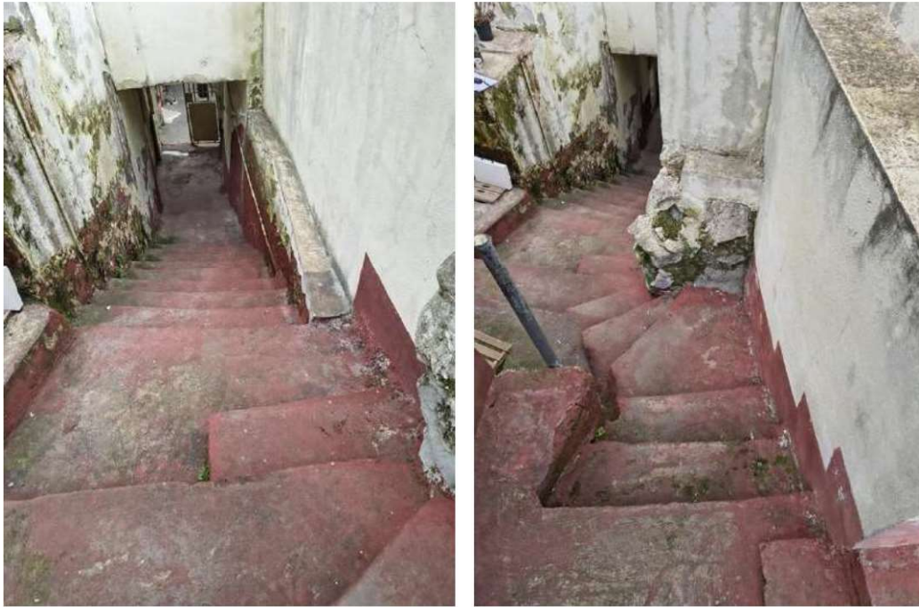
PASSAGGIO COMUNE A NORD DELL'EDIFICIO PRINCIPALE
