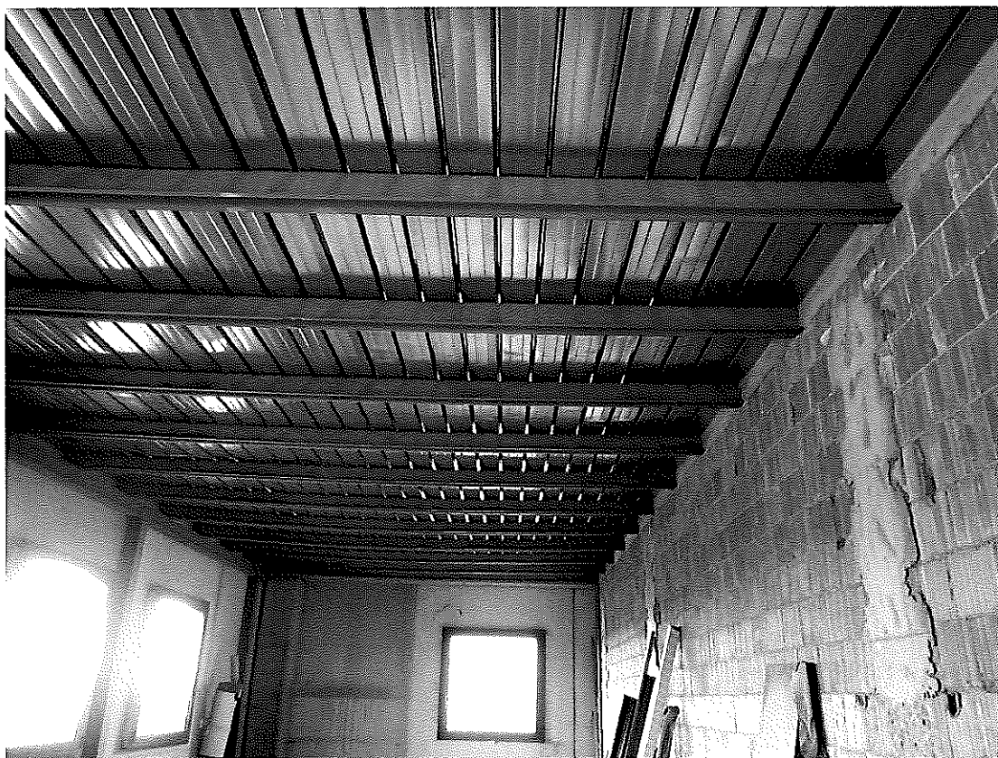
Foto n° 6 : Vista interna del vano al primo piano del corpo uffici.
