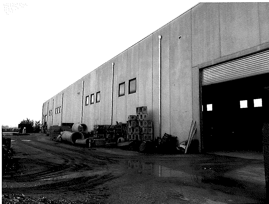
Foto n° 12 : Vista esterna – fronte Est.
