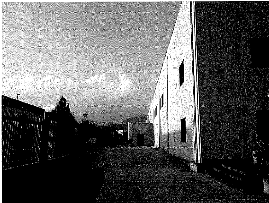
Foto n° 13 : Vista esterna fronte Ovest con vani tecnici.
