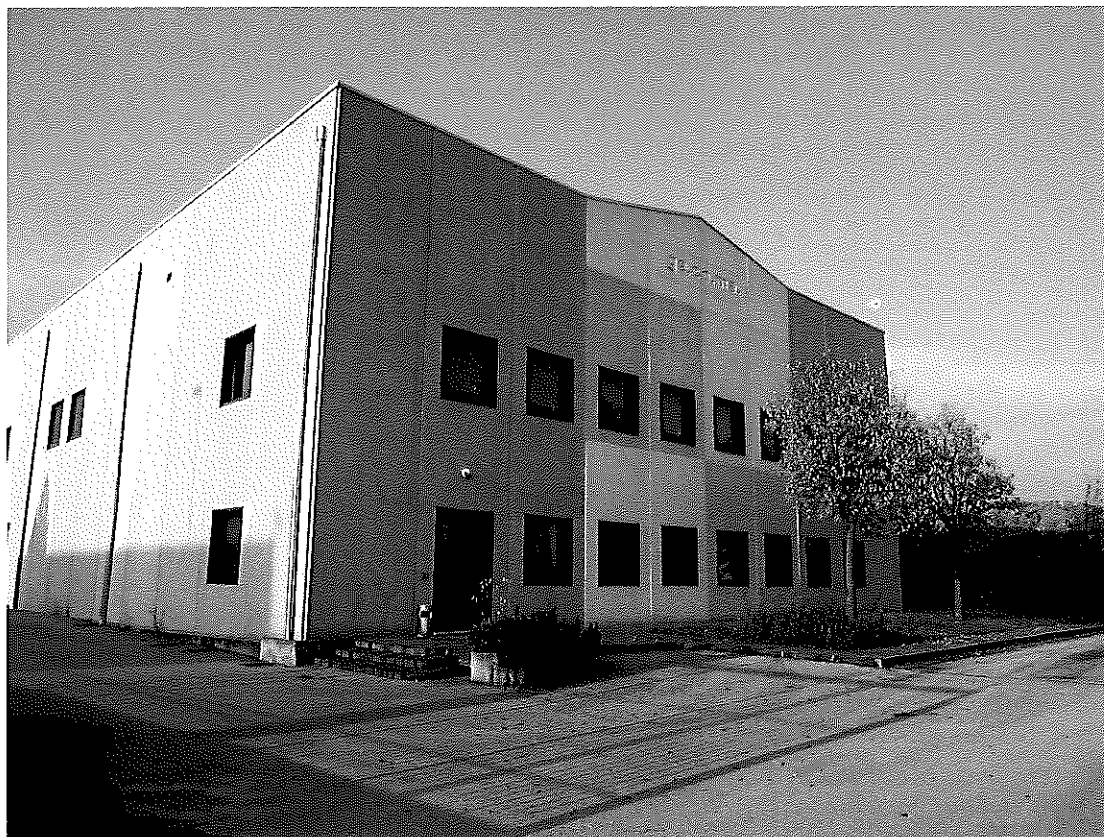
Foto n° 5 : Vista esterna del corpo uffici.
