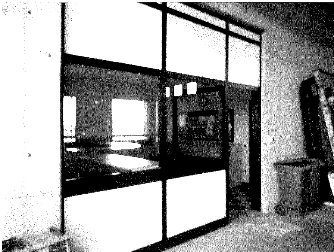
Foto n° 8 : Vista interna immobile del corpo uffici – parete di separazione con zona produttiva.
