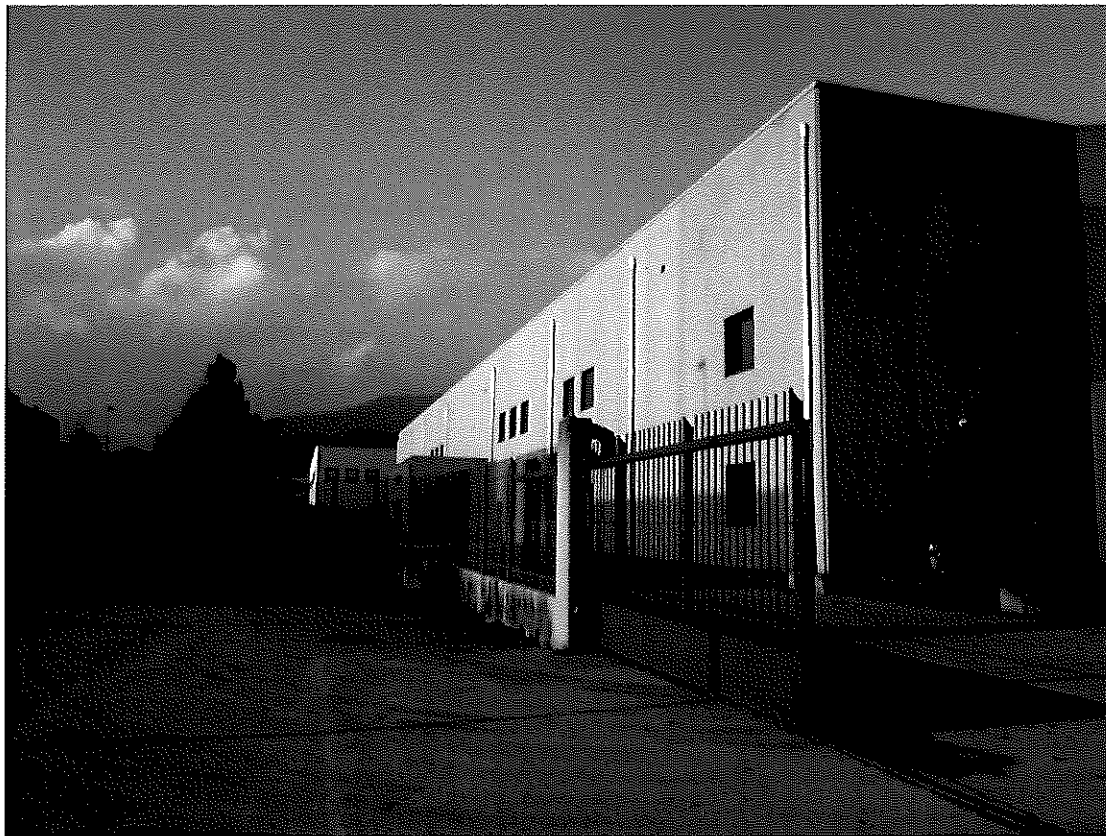
Foto n° 1 : Acceso carrato al compendio immobiliare.
