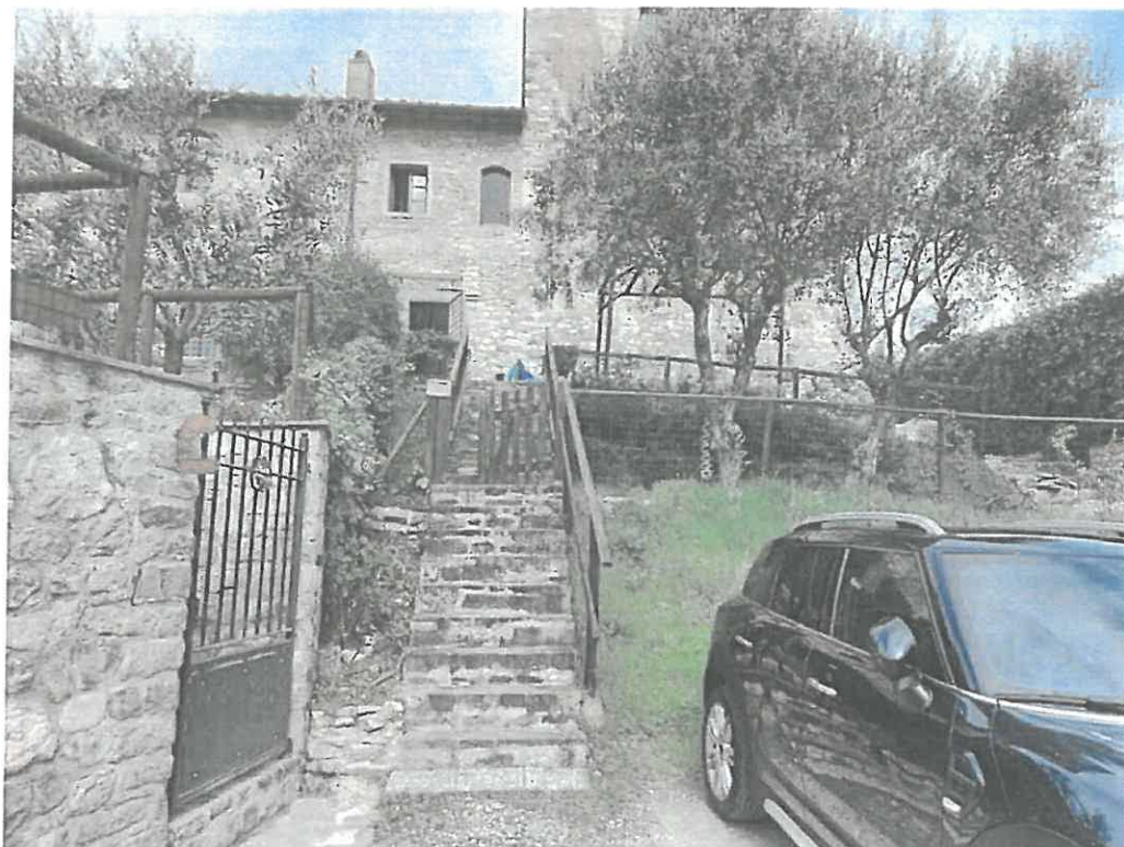
Foto 21: accesso pedonale al resede di pertinenza
