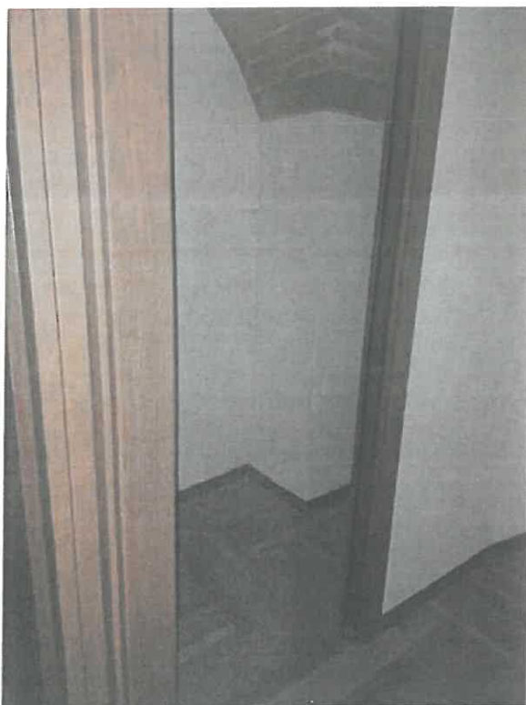
Foto 41: abitazione – disimpegno 1 – ripostiglio 1
