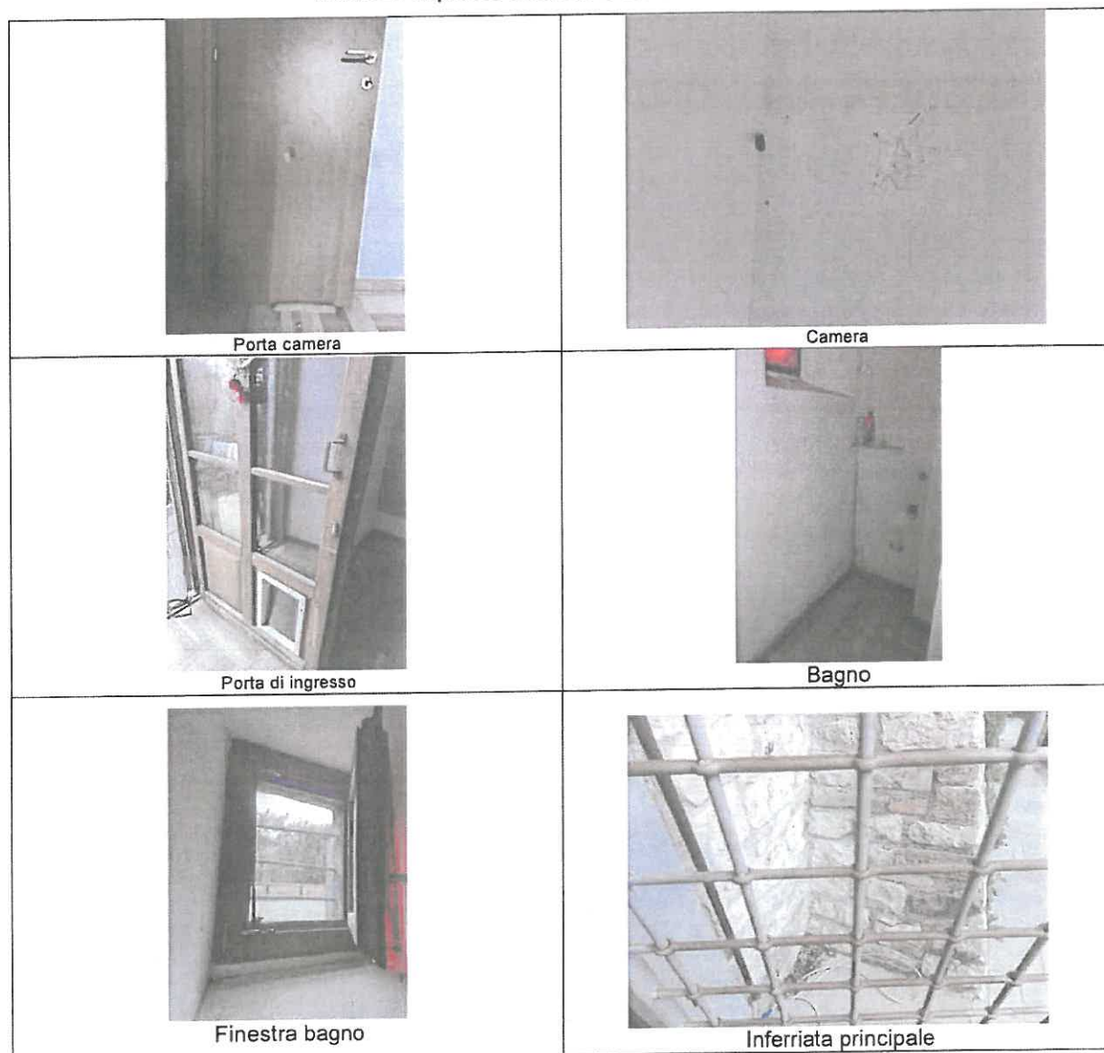
Foto 55: Stato di conservazione
