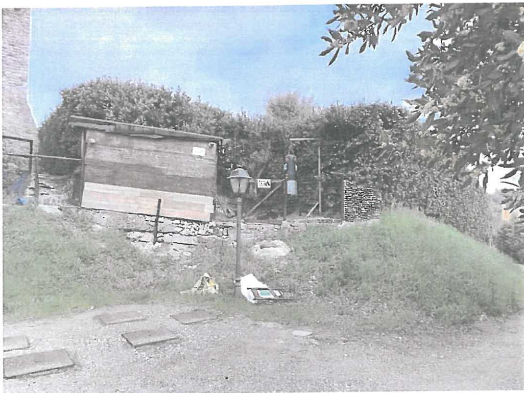
Foto 16: resede oltre la capanna di legno abusiva – cancellino da parcheggi
