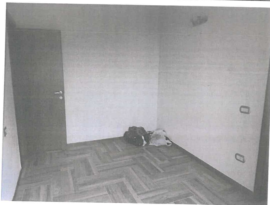
Foto 47: abitazione – camera – accesso da disimpegno 2
