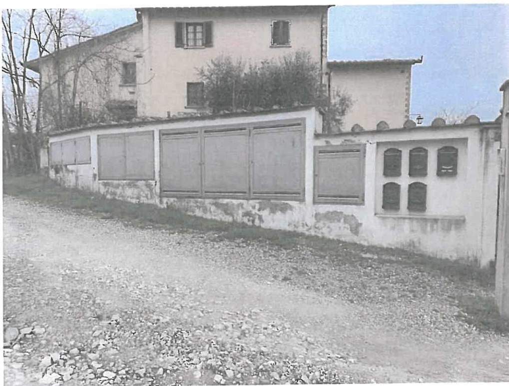
Foto 4: Accesso da Via Mortelle n.7 – contatori e cassette posta
