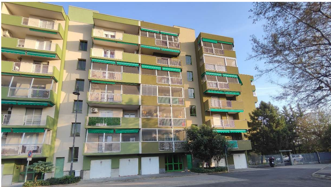
Foto n. 1 – Prospetto del fabbricato
