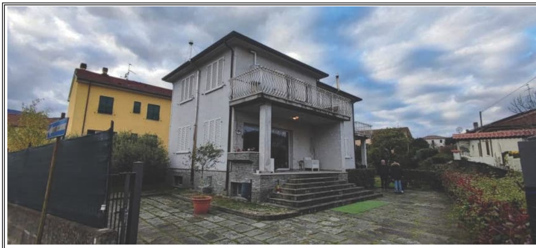
Foto n. 1 – Vista del fabbricato - angolo EST
