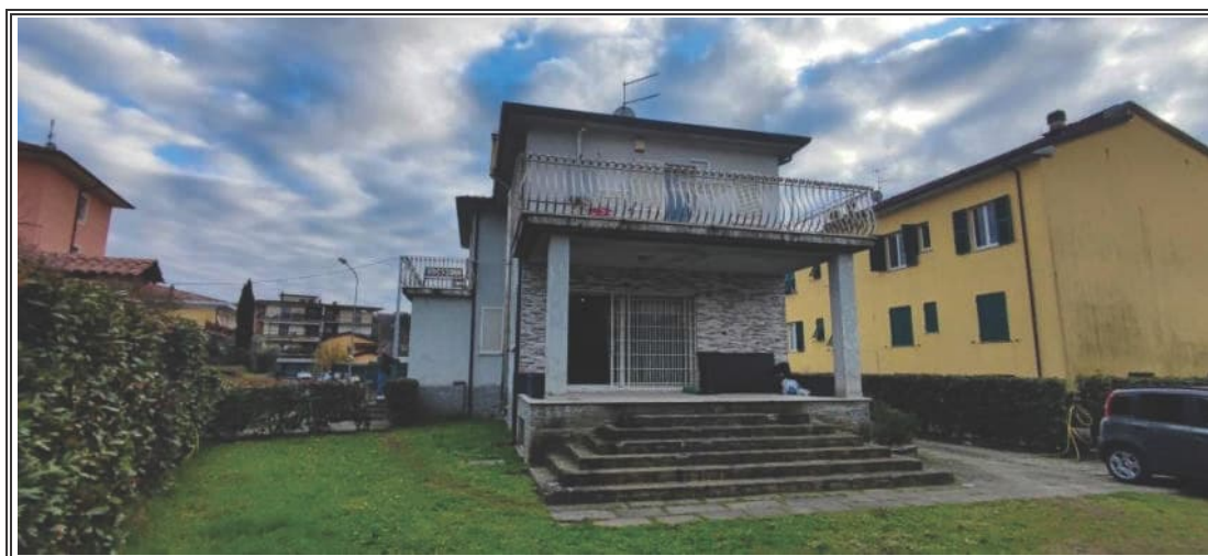
Foto n. 3 – Vista fabbricato – angolo NORD
