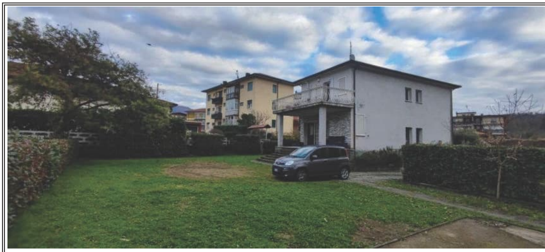
Foto n. 4 – Vista del fabbricato - Angolo OVEST
