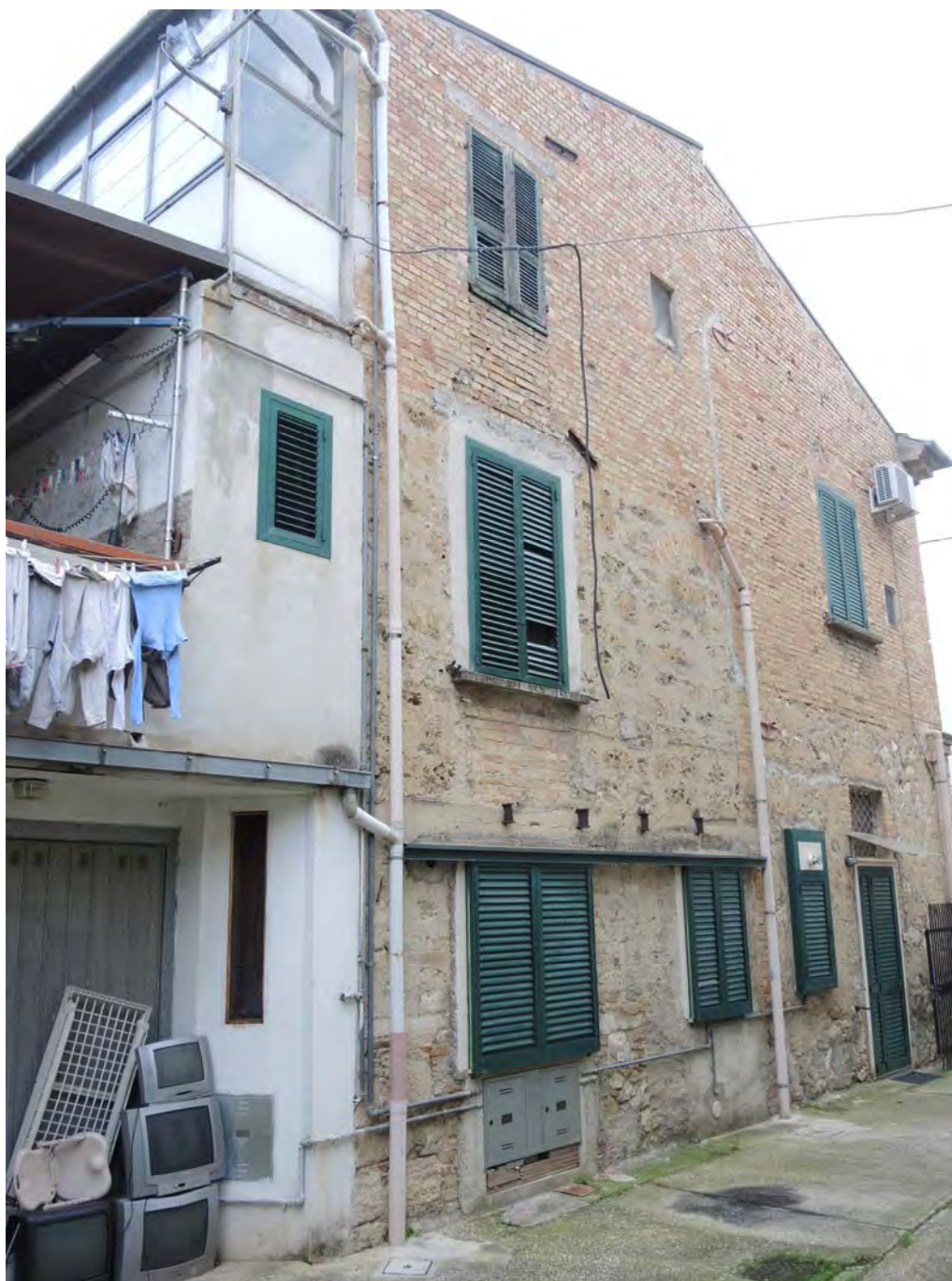
Foto 5: Vista laterale del fabbricato e della corte comune da cui è possibile accedere, da via San Rocco, al locale di sgombero/garage al piano terra facente parte dell'unità immobiliare censita al foglio 5 part. 327 sub. 8.
