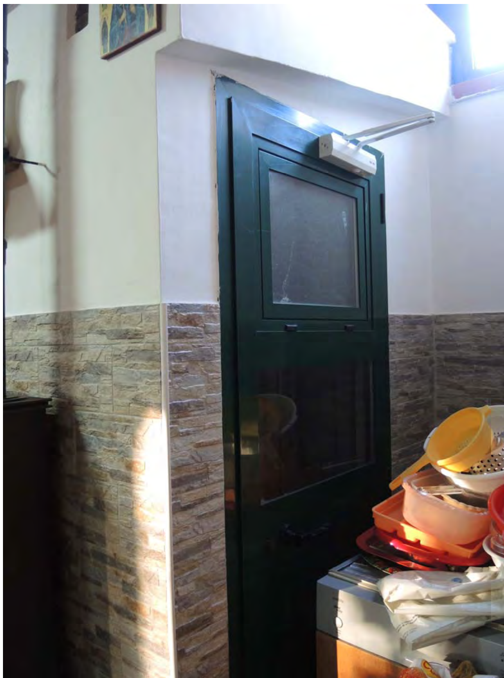
Foto 29: Vista interna della cucina in prossimità della porta del vano scala di collegamento (non presente nella planimetria catastale e realizzato in epoca successiva al 1994) con il sottostante locale di sgombero/garage.
