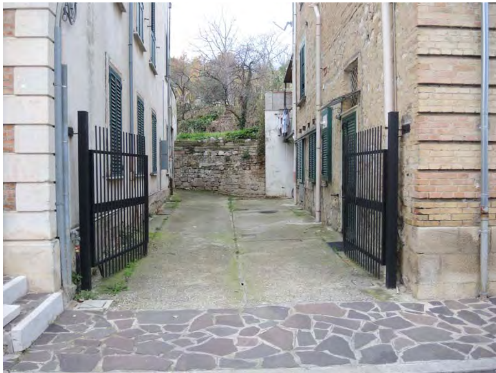
Foto 4: Vista del fabbricato e della corte comune da cui si accede al locale di sgombero/garage al piano terra. L'area scoperta comune al fabbricato risulta delimitata da un cancello dalla via San Rocco che comprende anche la porzione di area scoperta, la cui dividente di confine non è materializzata in sito, facente parte di altro fabbricato.
