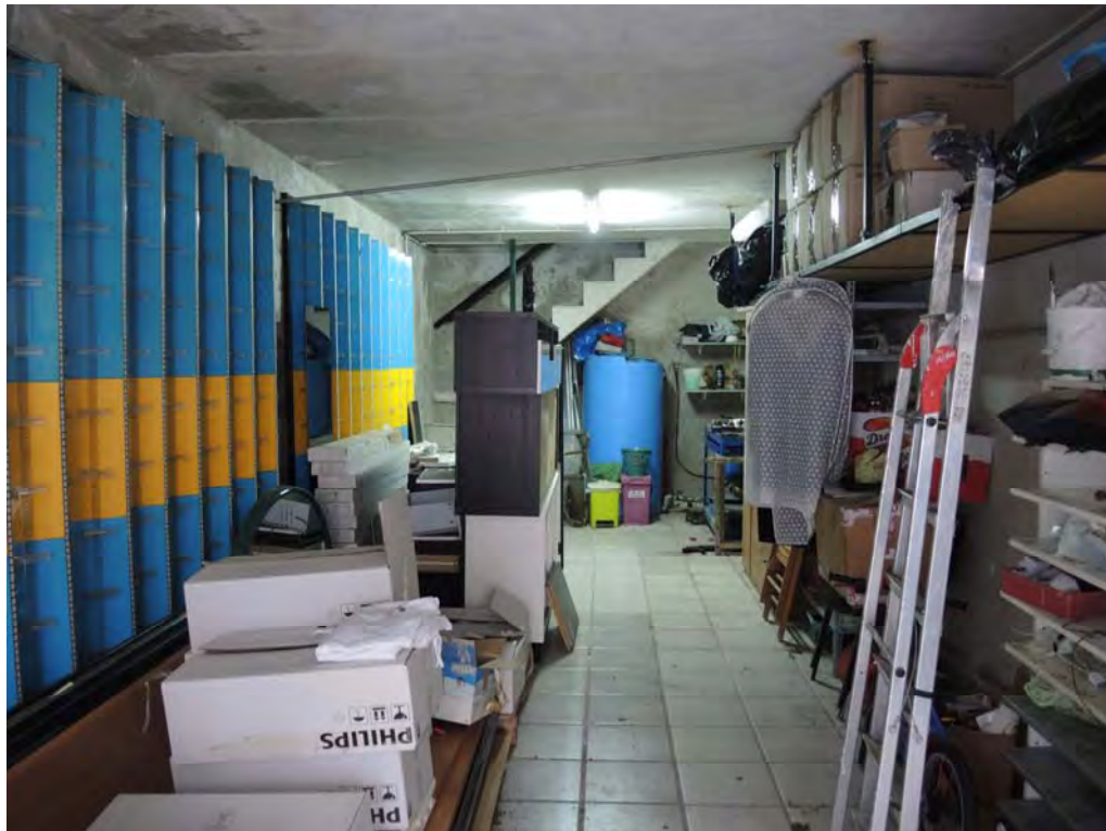
Foto 44: Vista interna del locale di sgombero/garage nonché della scala di collegamento (sullo sfondo) con la sovrastante abitazione.
