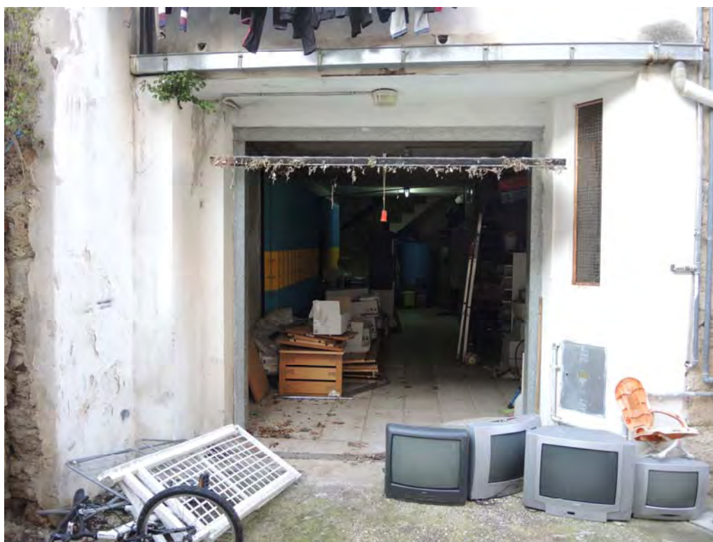
Foto 43: Vista dell'ingresso al locale di sgombero/garage, facente parte dell'unità censita al foglio 5 part. 327 sub.8
