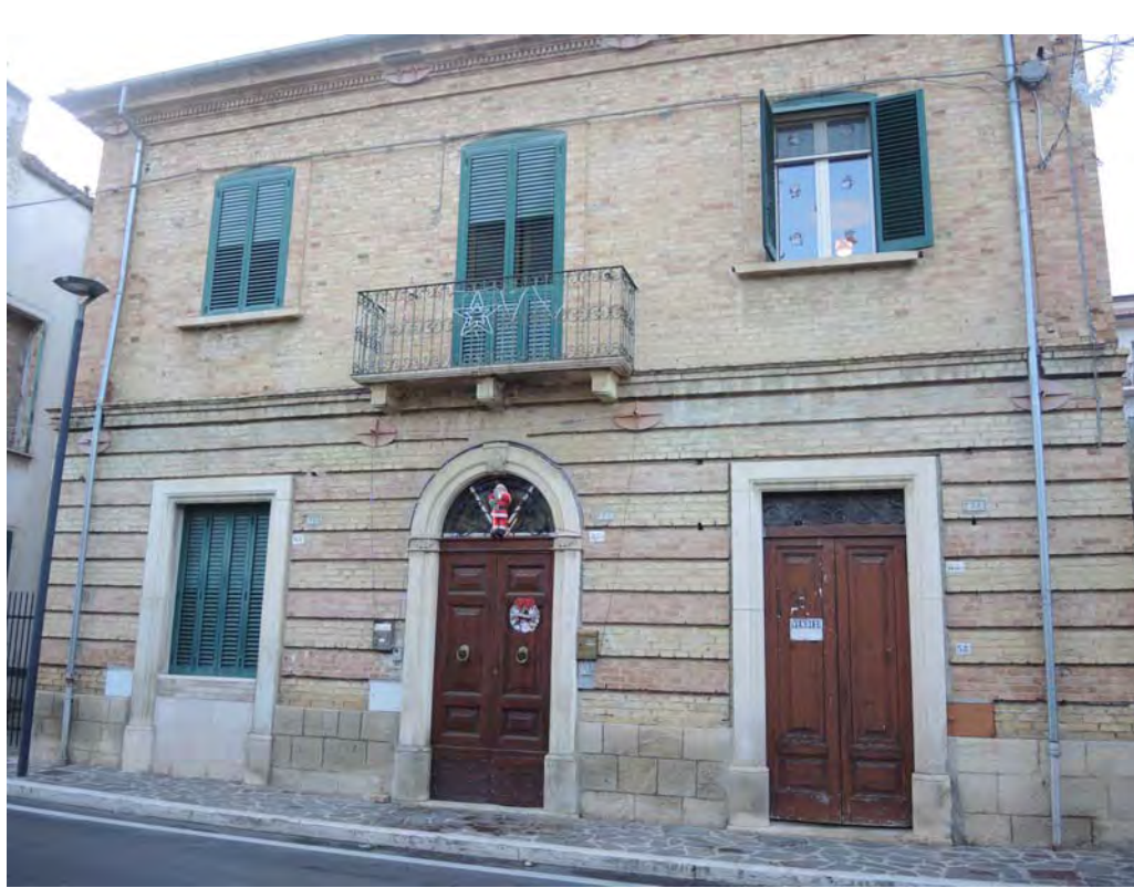
Foto 3: Vista del fabbricato, in prossimità dell'ingresso da via San Rocco, in cui sono inserite le unità immobiliari oggetto di perizia.
