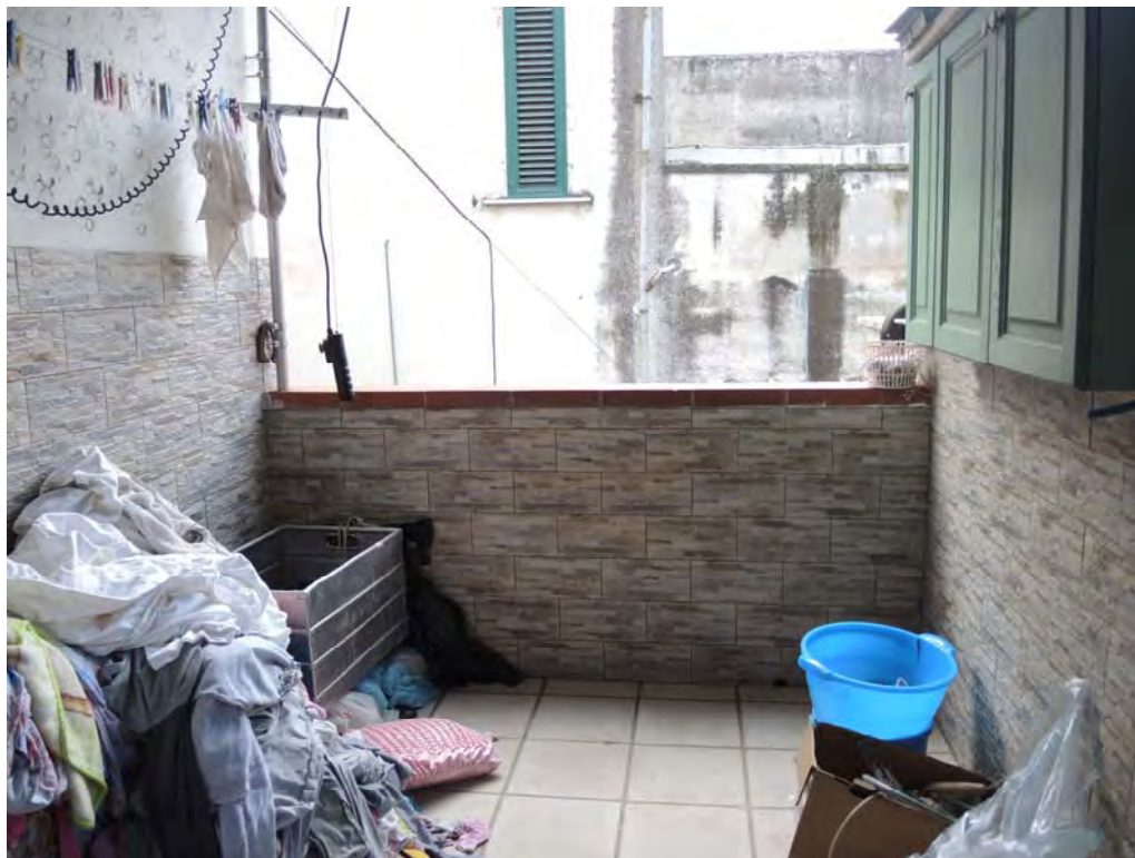
Foto 30: Vista interna del terrazzo adiacente alla cucina da cui si accede. Terrazzo non presente nella planimetria catastale e realizzato in epoca successiva al 1994 nonché facente parte della porzione ampliata.
