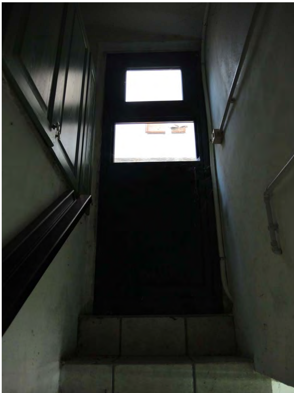
Foto 47: Particolare della scala di collegamento del locale di sgombero/garage alla sovrastante abitazione nonché della porta di accesso alla cucina.
