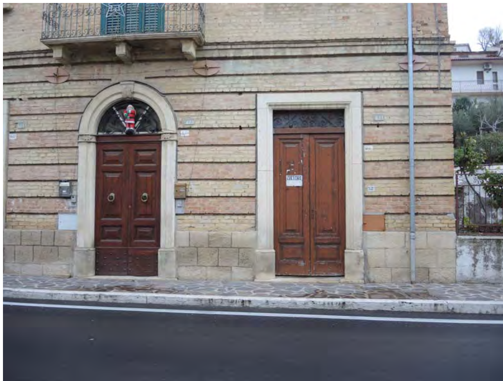
Foto 7: Vista del fabbricato in prossimità dei portoni di ingresso rispettivamente dell'abitazione al piano primo mediante vano scala (via San Rocco n. 60) e del locale di deposito al piano terra (via san Rocco n. 58) di cui all'unità immobiliare censita al foglio 5 part. 327 sub. 8 oggetto di perizia.
