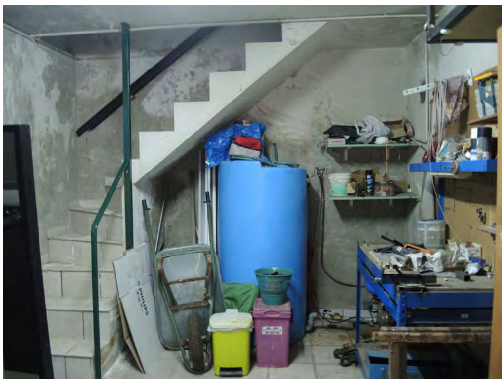
Foto 45: Particolare della scala di collegamento del locale di sgombero/garage con la sovrastante abitazione nonché del serbatoio autoclave.
