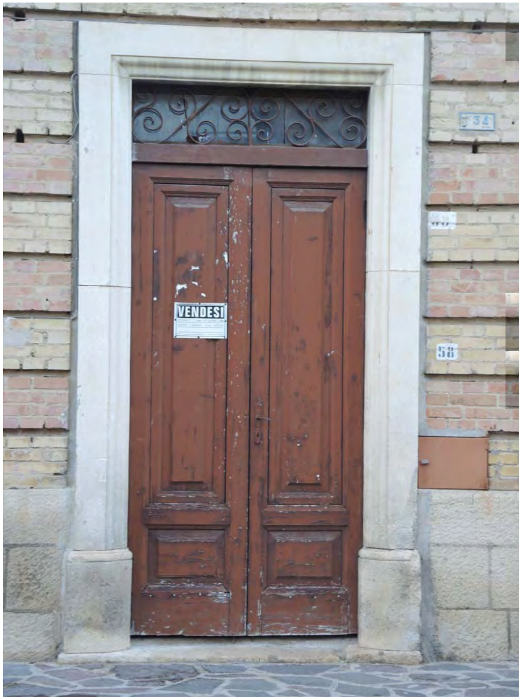
Foto 9: Portone di ingresso del locale di deposito al piano terra (via san Rocco n. 58) di cui all'unità immobiliare censita al foglio 5 part. 327 sub. 8 oggetto di perizia.
