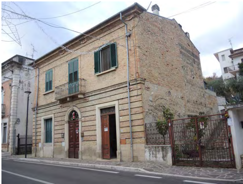
Foto 1: Vista del fabbricato, in prossimità dell'ingresso da via San Rocco, in cui sono inserite le unità immobiliari oggetto di perizia.
