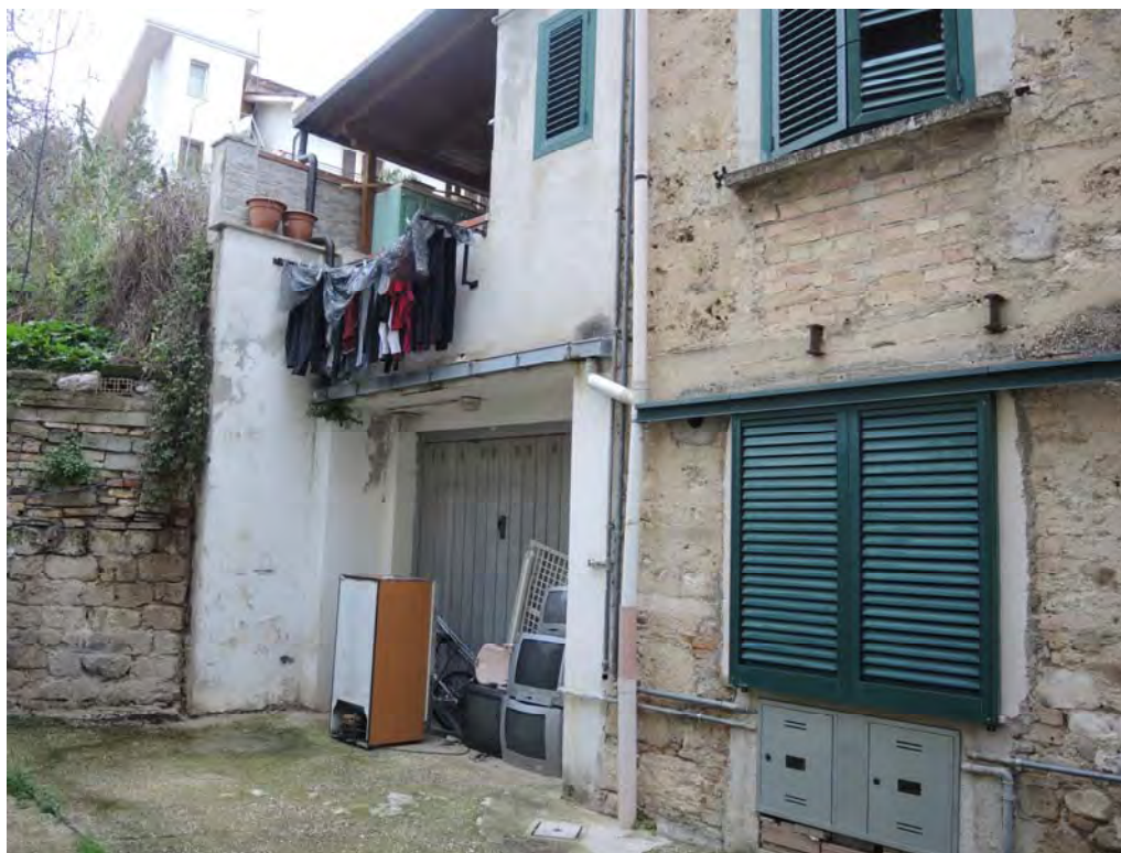
Foto 6: Vista dell'ingresso al locale di sgombero/garage al piano terra facente parte dell'unità immobiliare oggetto di perizia censita al foglio 5 part. 327 sub. 8.
