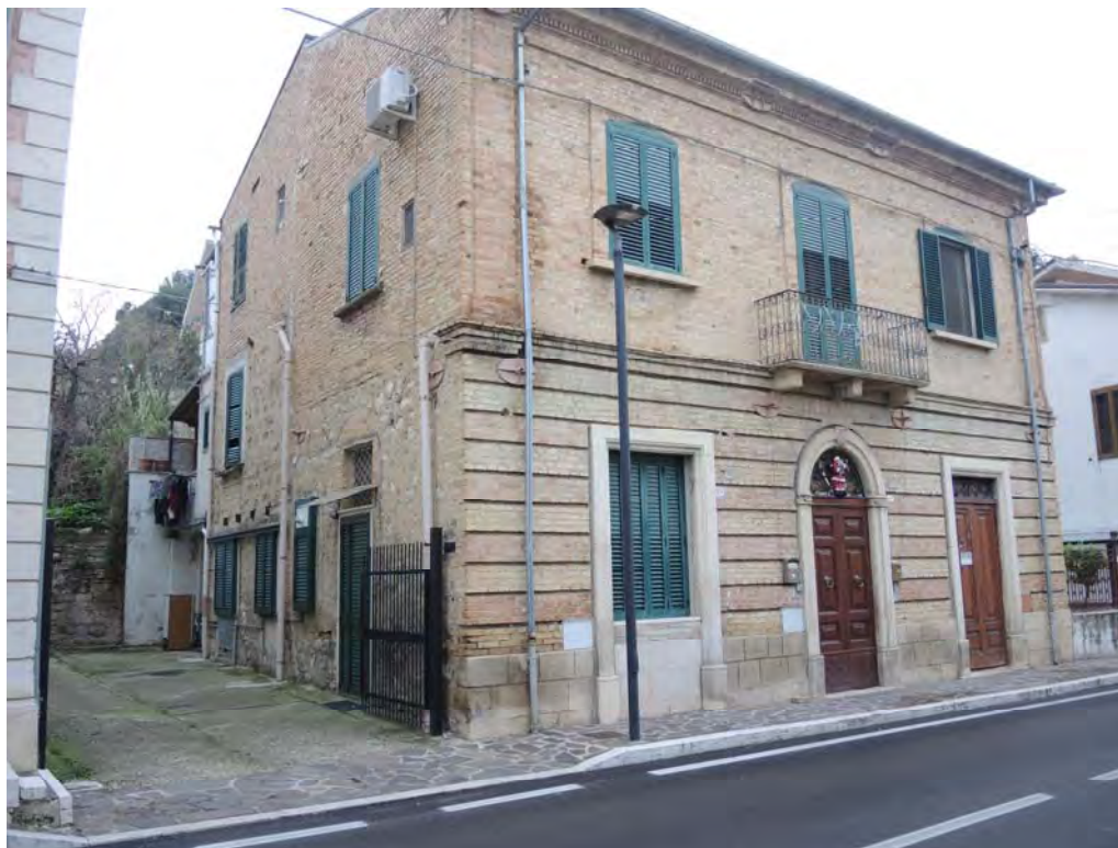
Foto 2: Vista del fabbricato, da altra angolazione, in prossimità dell'ingresso da via San Rocco, in cui sono inserite le unità immobiliari oggetto di perizia.
