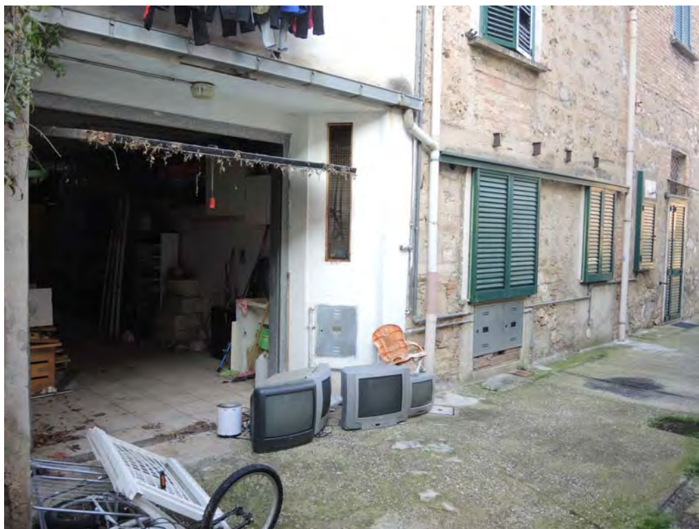
Foto 42: Vista del locale di sgombero/garage, facente parte dell'unità censita al foglio 5 part. 327 sub.8, con accesso da via San Rocco e dalla corte comune al fabbricato.
