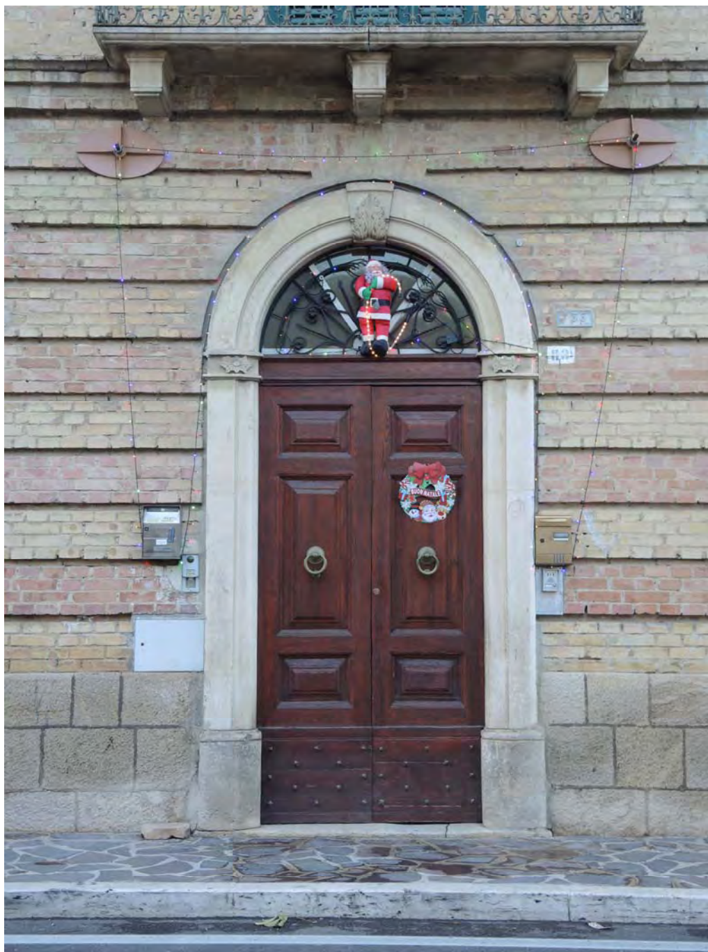
Foto 8: Portone di ingresso dell'abitazione al piano primo mediante vano scala comune ad altri immobili (via San Rocco n. 60) di cui all'unità immobiliare censita al foglio 5 part. 327 sub. 8 oggetto di perizia.
