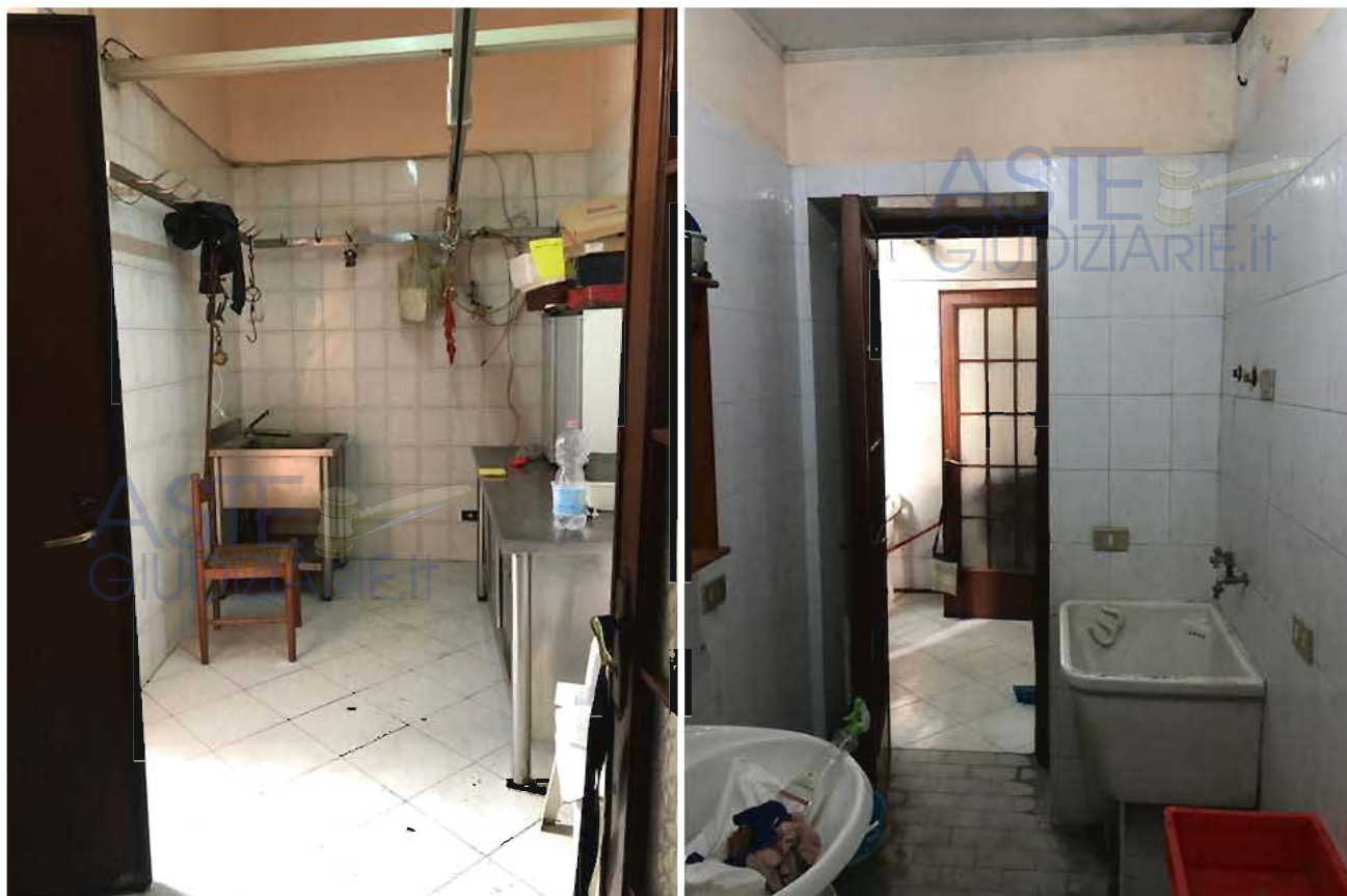
Foto 11. Zona deposito - Foto 12. Bagno
