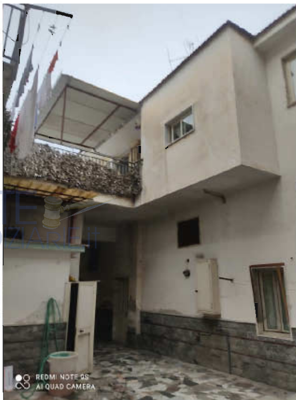
Foto 2. Ingresso e finestra bagno su corte
