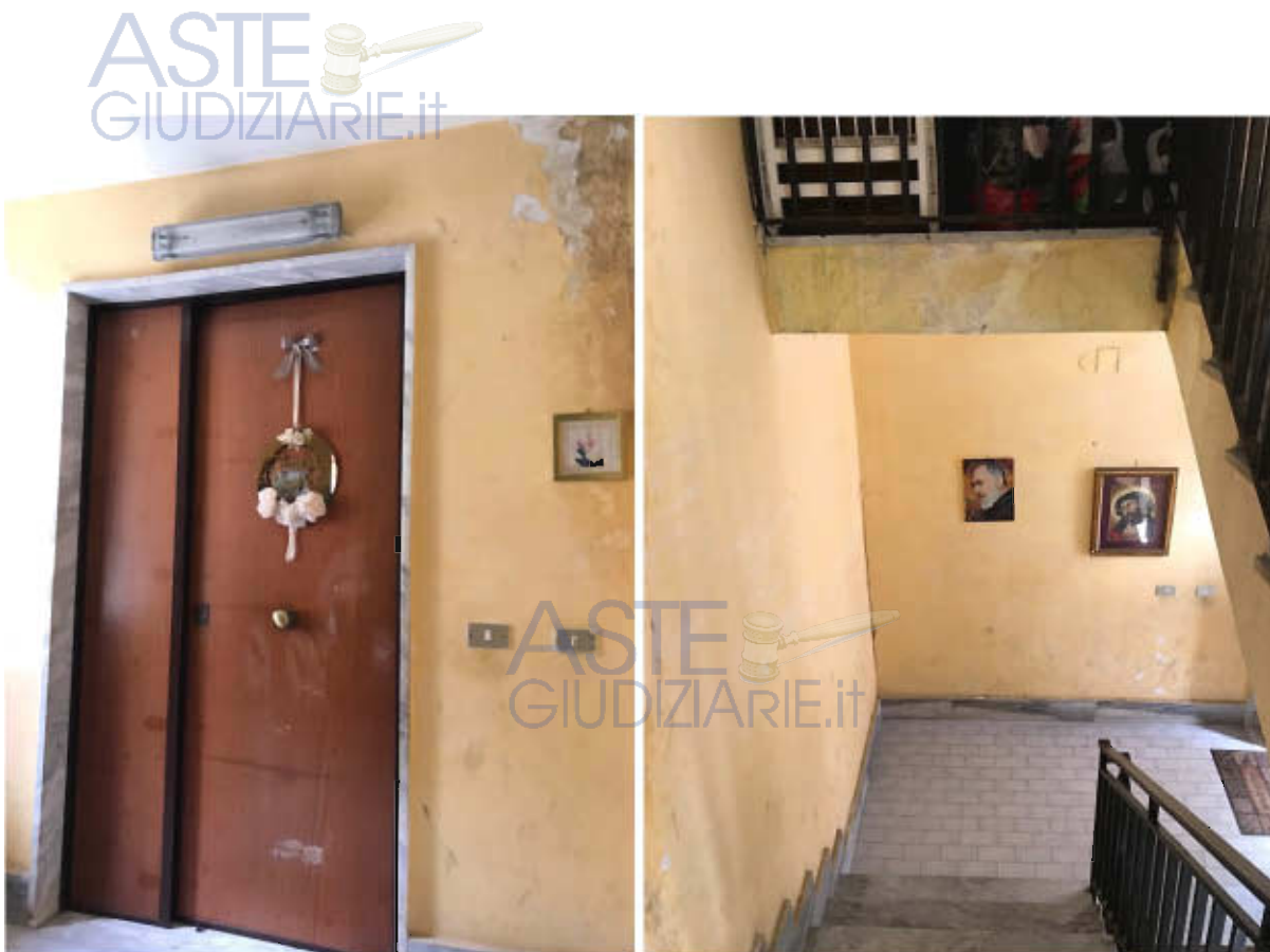
Foto 1. Porta di ingresso Foto 2. Scala condominiale
