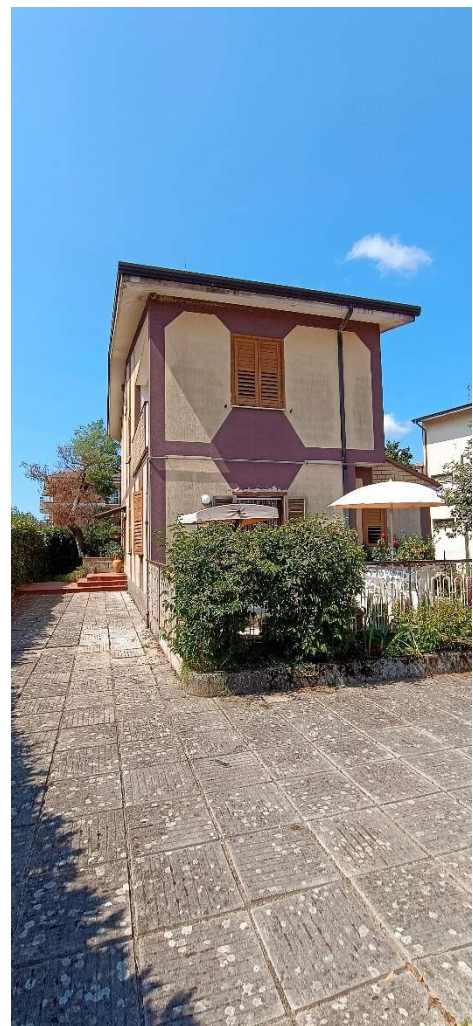
2 | Vista fabbricato lato Nord-Est
