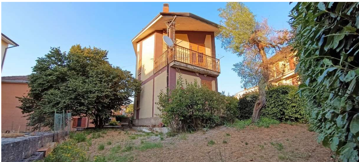
3 | Vista fabbricato lato Sud-Ovest
