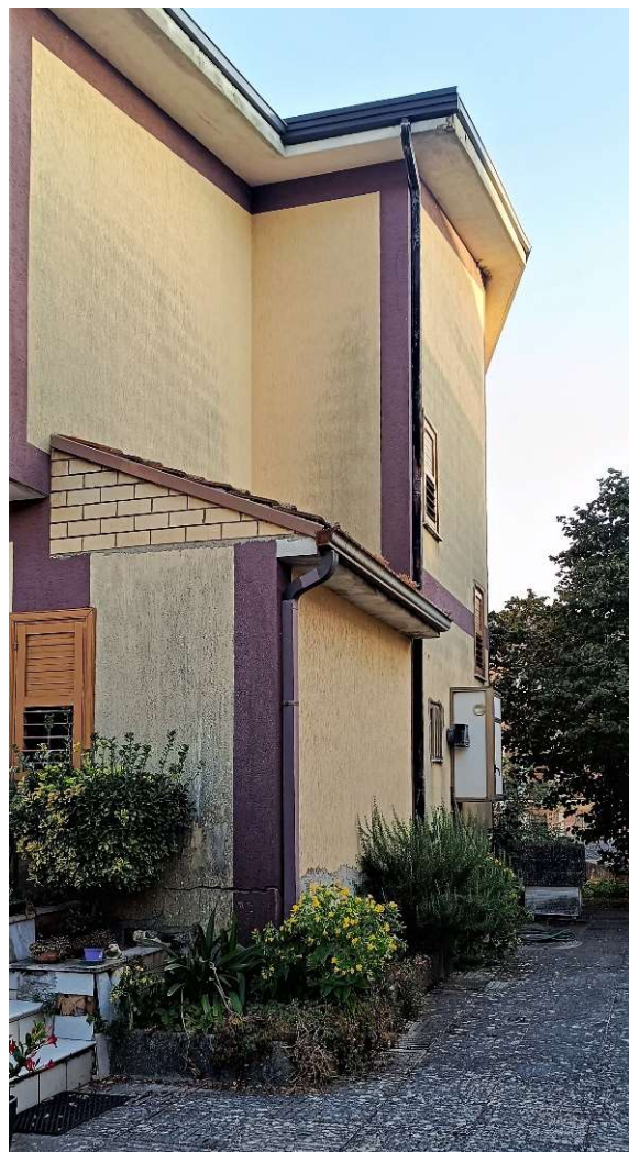
6 | Vista fabbricato lato Nord-Ovest
