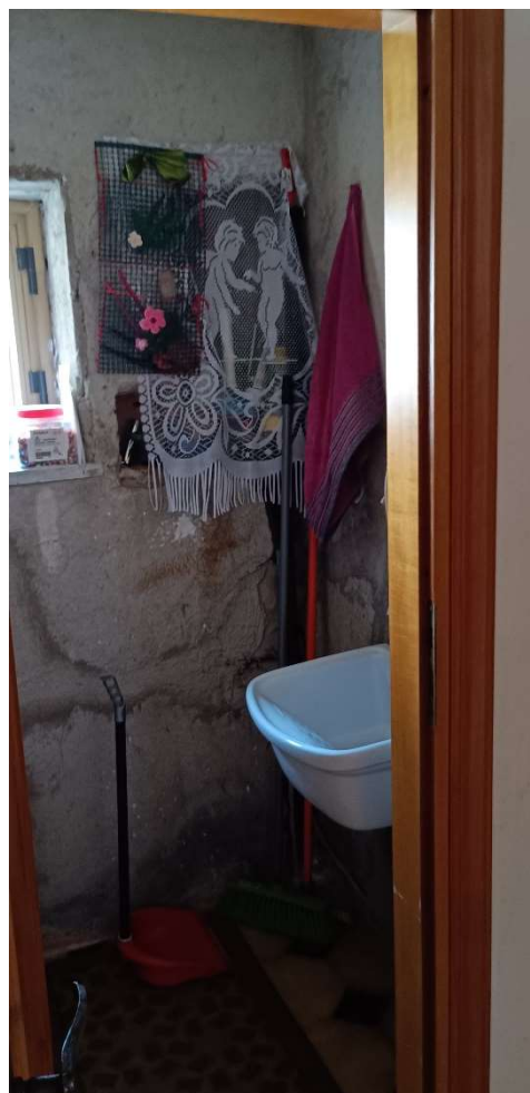
19 | Ripostiglio piano terra
