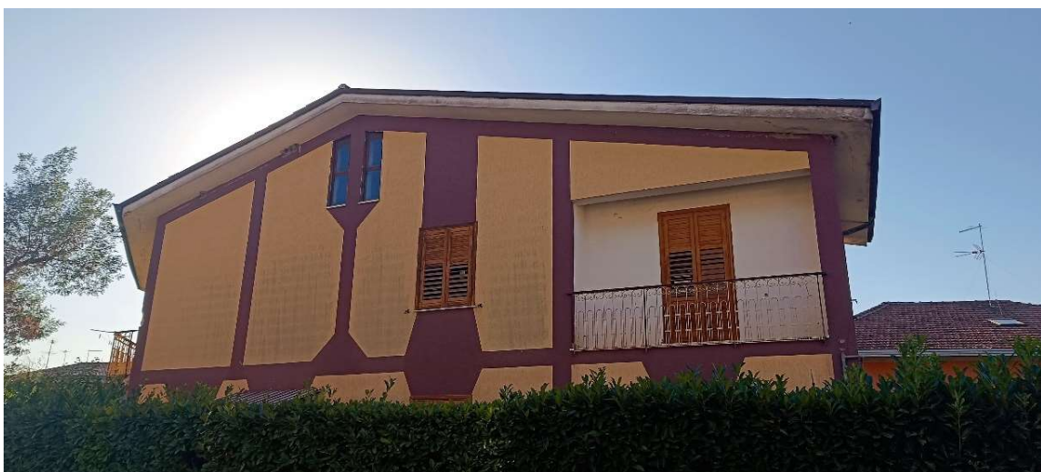
5 | Vista fabbricato (piano 1° lato Sud-Est)
