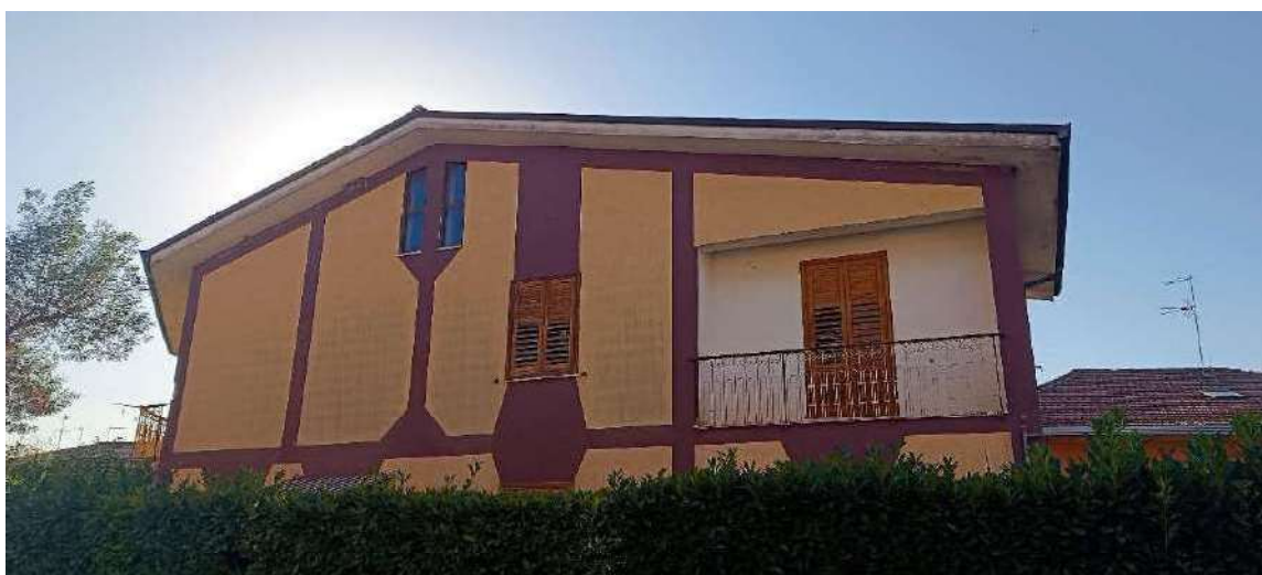
5 | Vista fabbricato (piano 1° lato Sud-Est)
