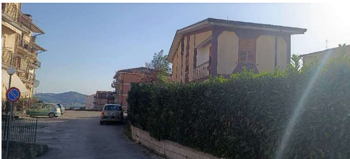
4 | Vista fabbricato angolo Est
