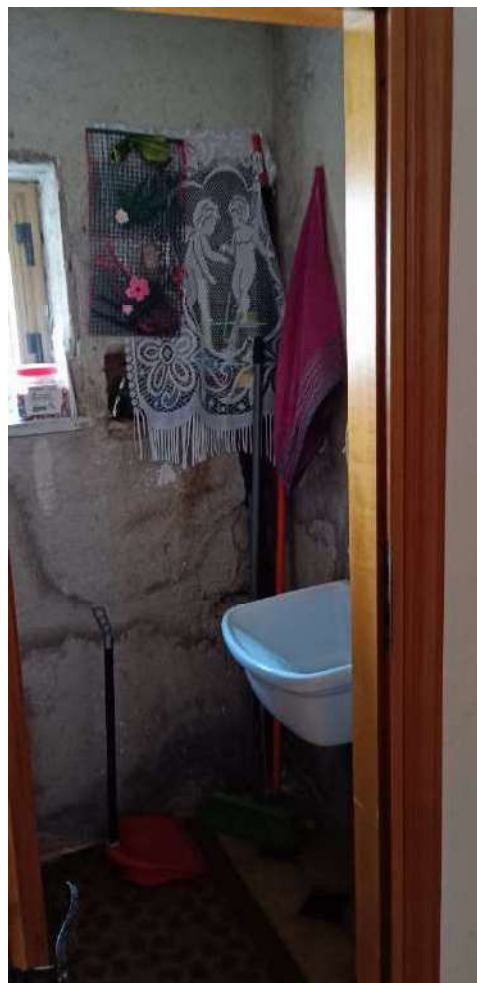
19 | Ripostiglio piano terra
