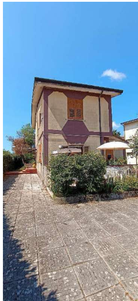
2 | Vista fabbricato lato Nord-Est
