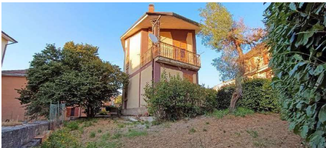
3 | Vista fabbricato lato Sud-Ovest
