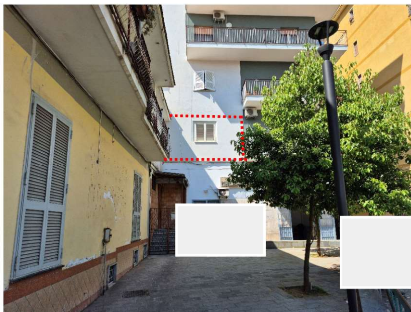
Vista esterna dell'appartamento da Piazza Tammaro Romano
