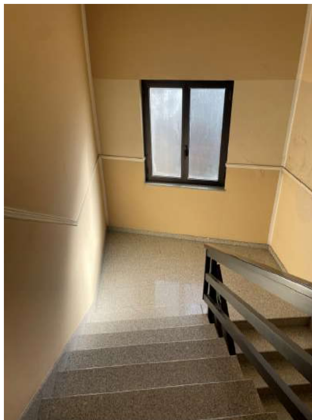
Vista interna del vano scala
