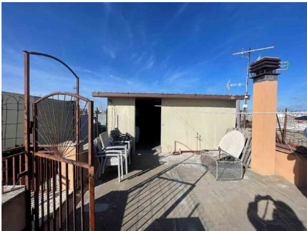
Vista esterna del volume lavatoio
