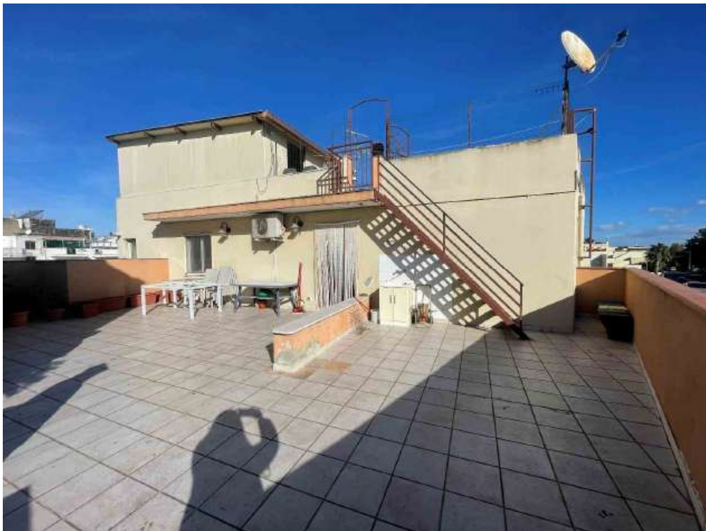
Vista esterna del secondo piano e del lavatoio al terzo piano, su lastrico solare
