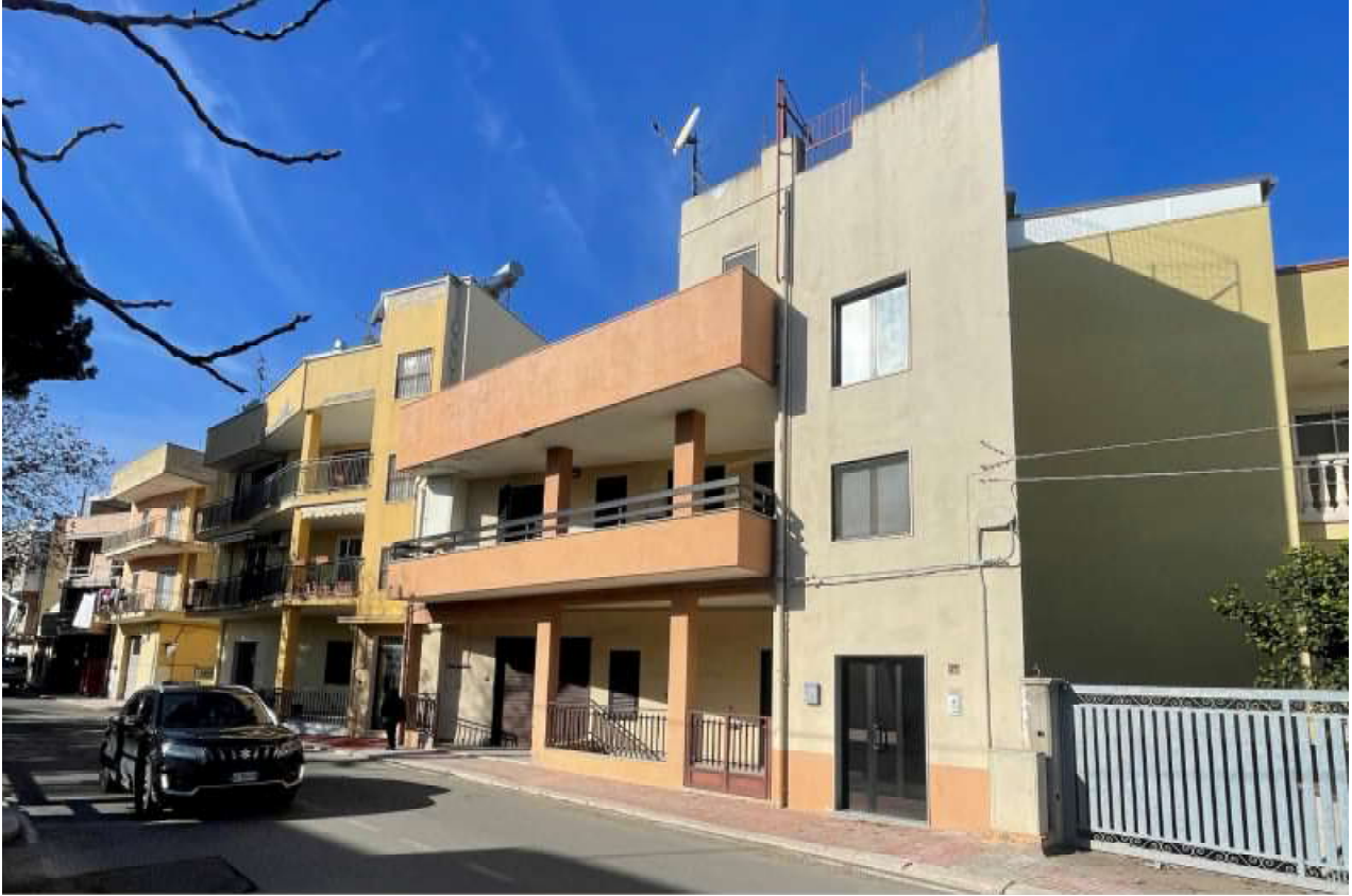
FOTO 1 vista esterna dell'immobile
