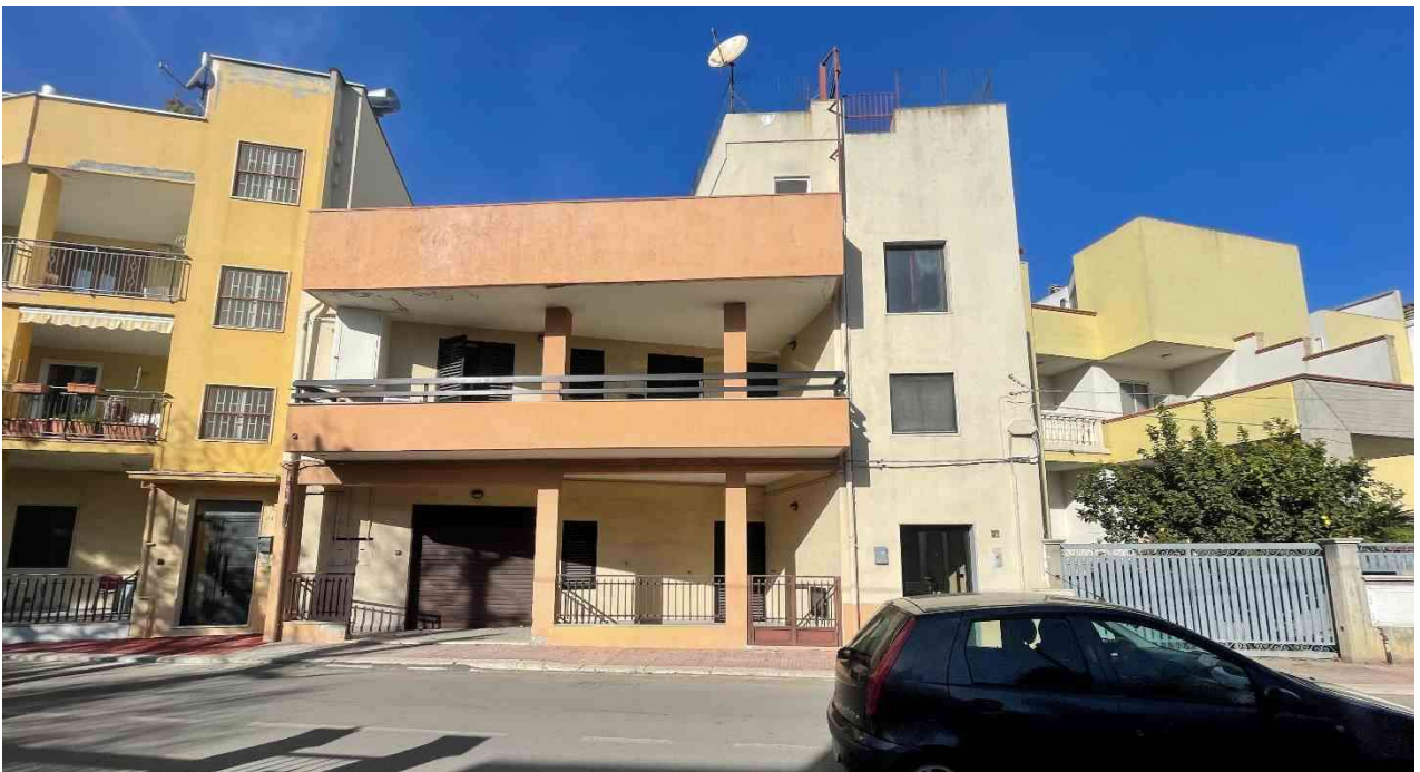
FOTO 2 vista esterna dell'immobile
