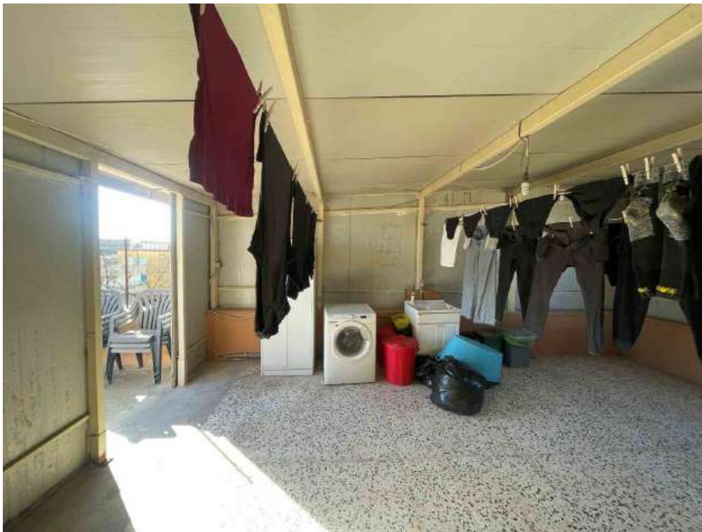
Vista interna del volume lavatoio
