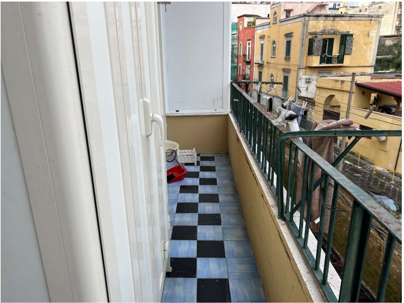
Foto 17 – Vista del balcone sul fronte est
