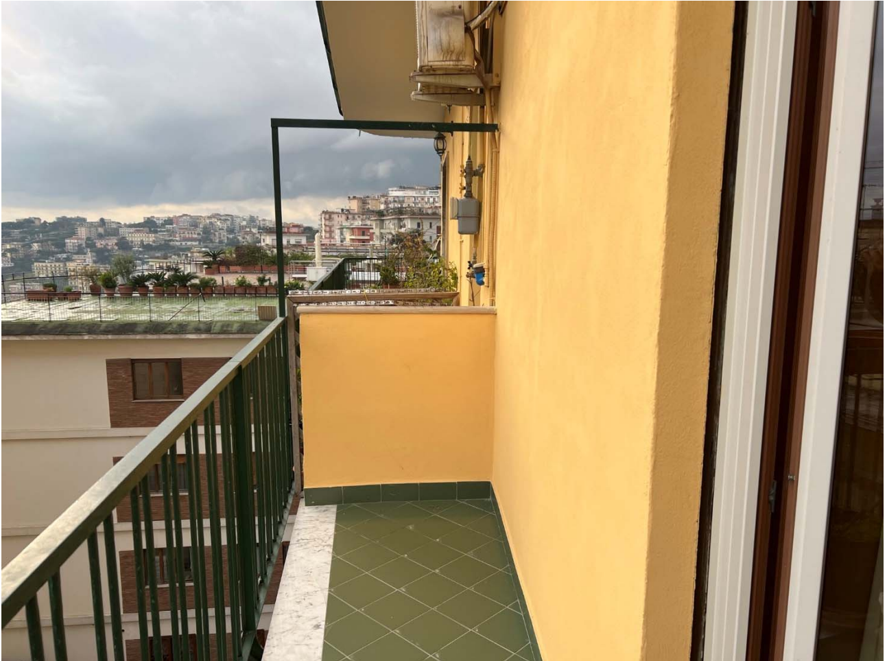
Foto 14 – Vista del balcone sul fronte sud
