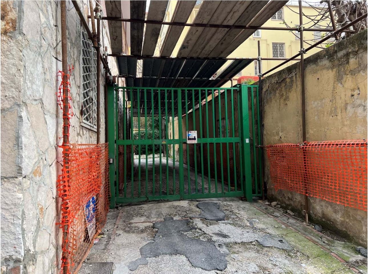
Foto 24 - Vista dell'accesso dalla strada al cortile posteriore
