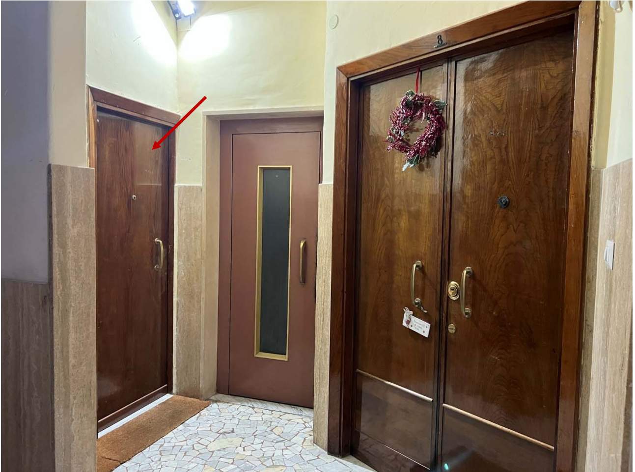
Foto 6 – Vista della porta di caposcala dell'unità abitativa (scala A, piano quarto, int. 8A)
