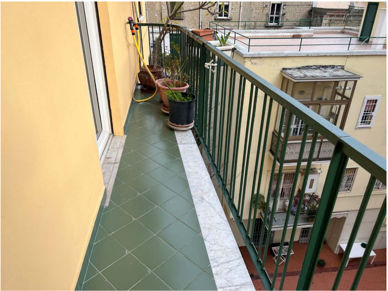
Foto 13 – Vista del balcone sul fronte sud
