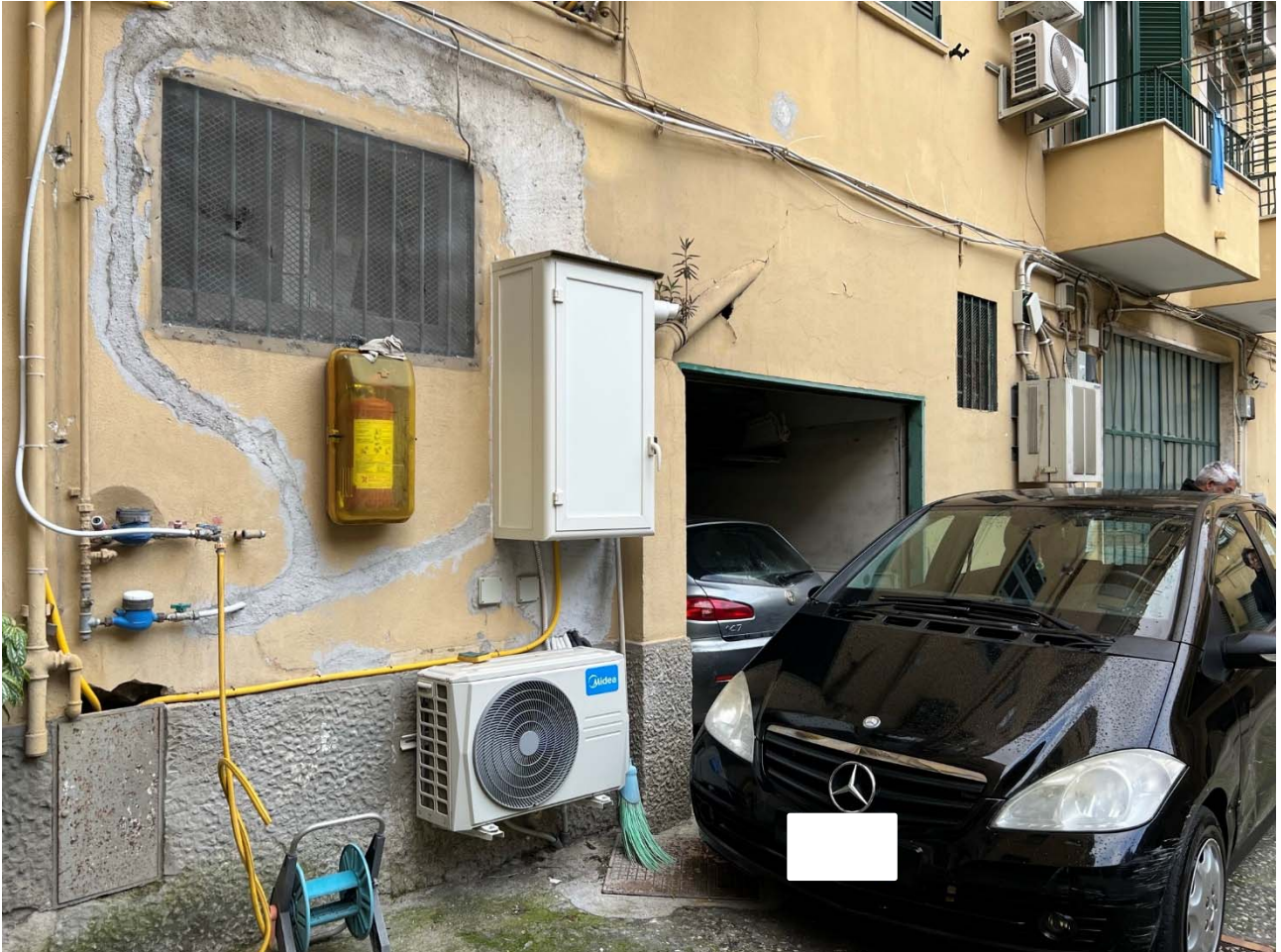
Foto 26 - Vista dell'ingresso al box
