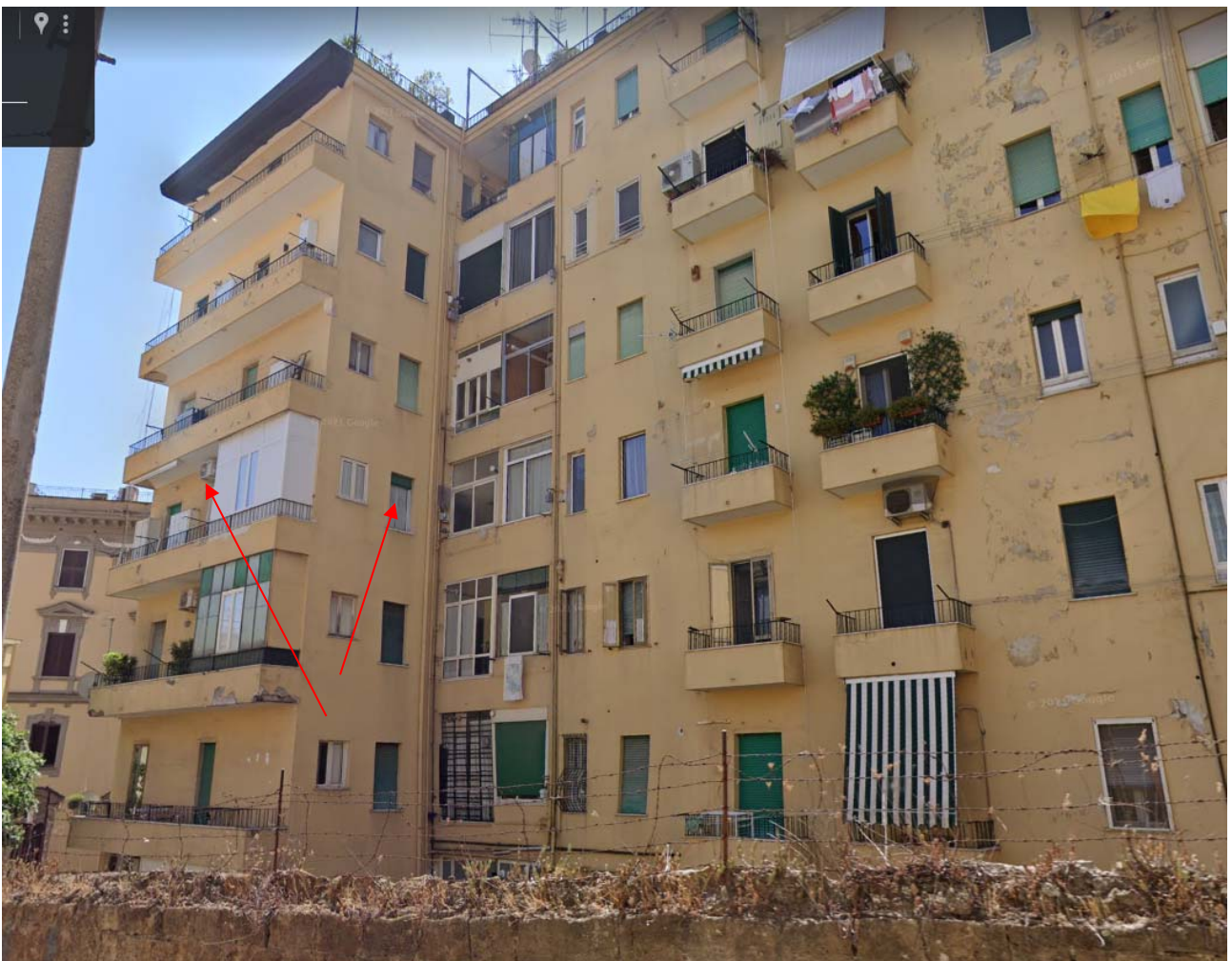
Foto 3 – Particolare del prospetto posteriore del fabbricato di via Aniello Falcone n. 290A, Napoli
