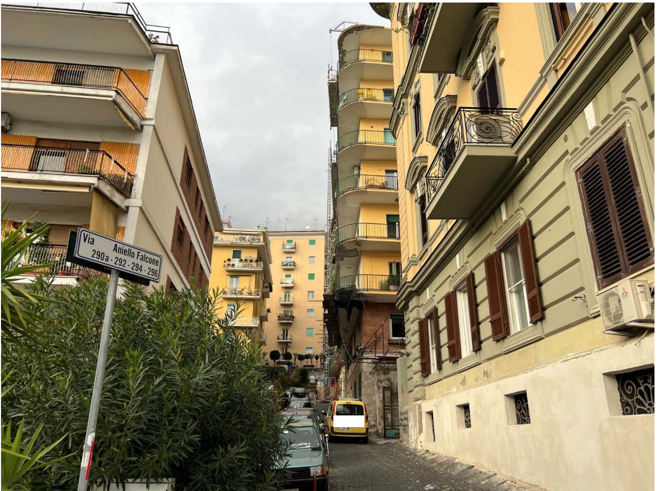
Foto 1 – Vista della strada privata che conduce al fabbricato di via Aniello Falcone n. 290A, Napoli
