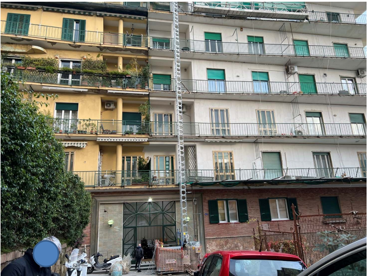
Foto 2 – Particolare del prospetto anteriore del fabbricato di via Aniello Falcone n. 290A, Napoli
