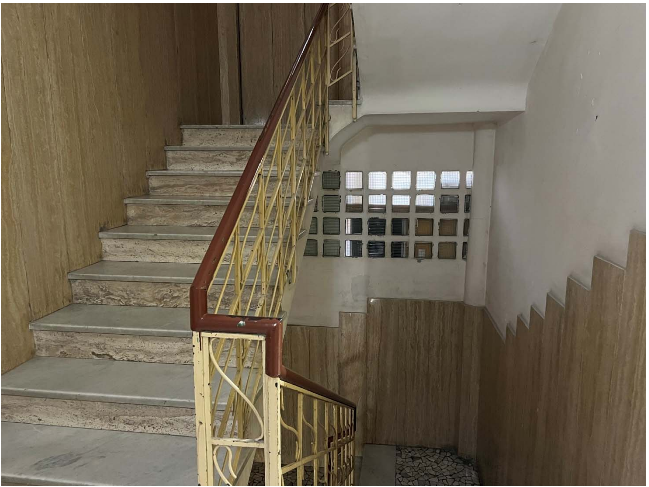
Foto 5 – Vista del corpo scala
