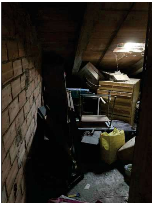
Foto 37 - SOFFITTA NEL SOTTOTETTO
