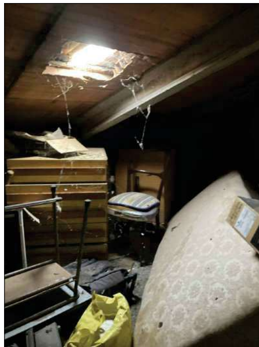
Foto 38 - SOFFITTA NEL SOTTOTETTO
