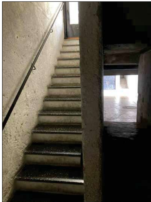
Foto 31 - ENTRATA CANTINE E SCALA
