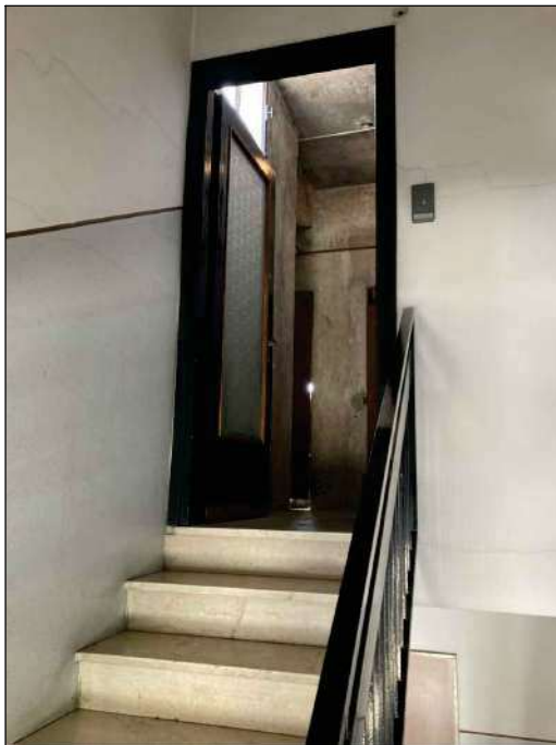
Foto 35 - INGRESSO A SOTTOTETTO
