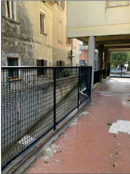
Foto 7 - VISTA PORTICO DA EST
