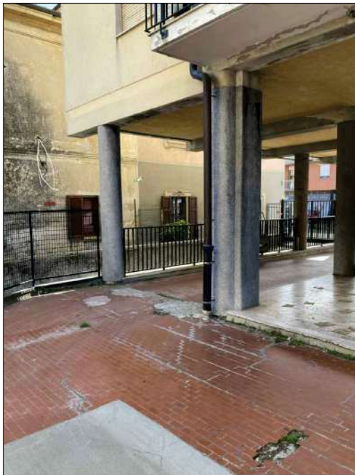
Foto 12 - VISTA PORTICO DA EST
