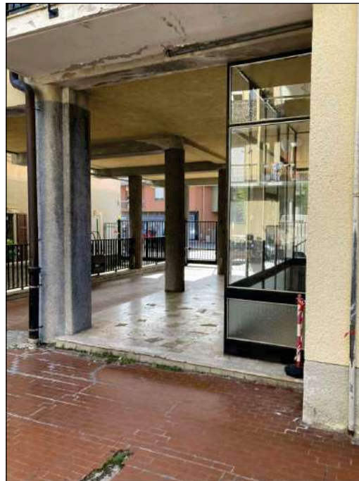
Foto 13 - VISTA PORTICO DA EST
