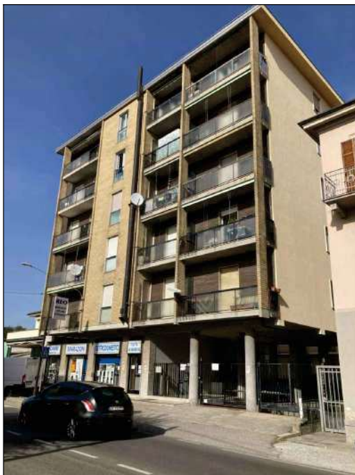
Foto 5 - VISTA IMMOBILE DA SUD DA VIALE MONTE GRAPPA
