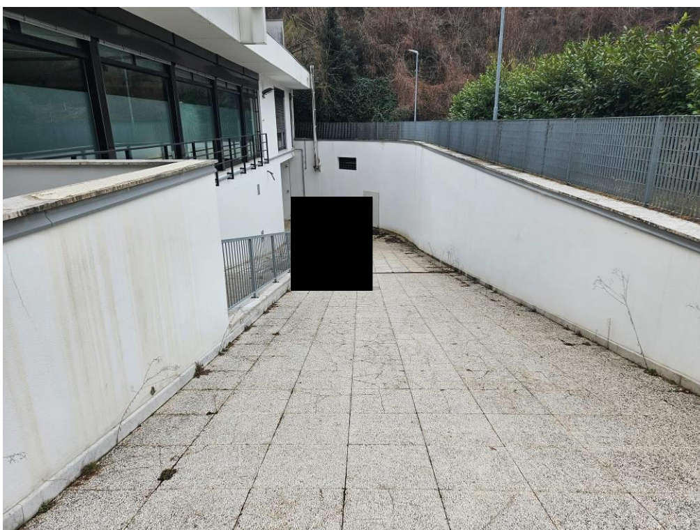
rampa per accesso al piano interrato
