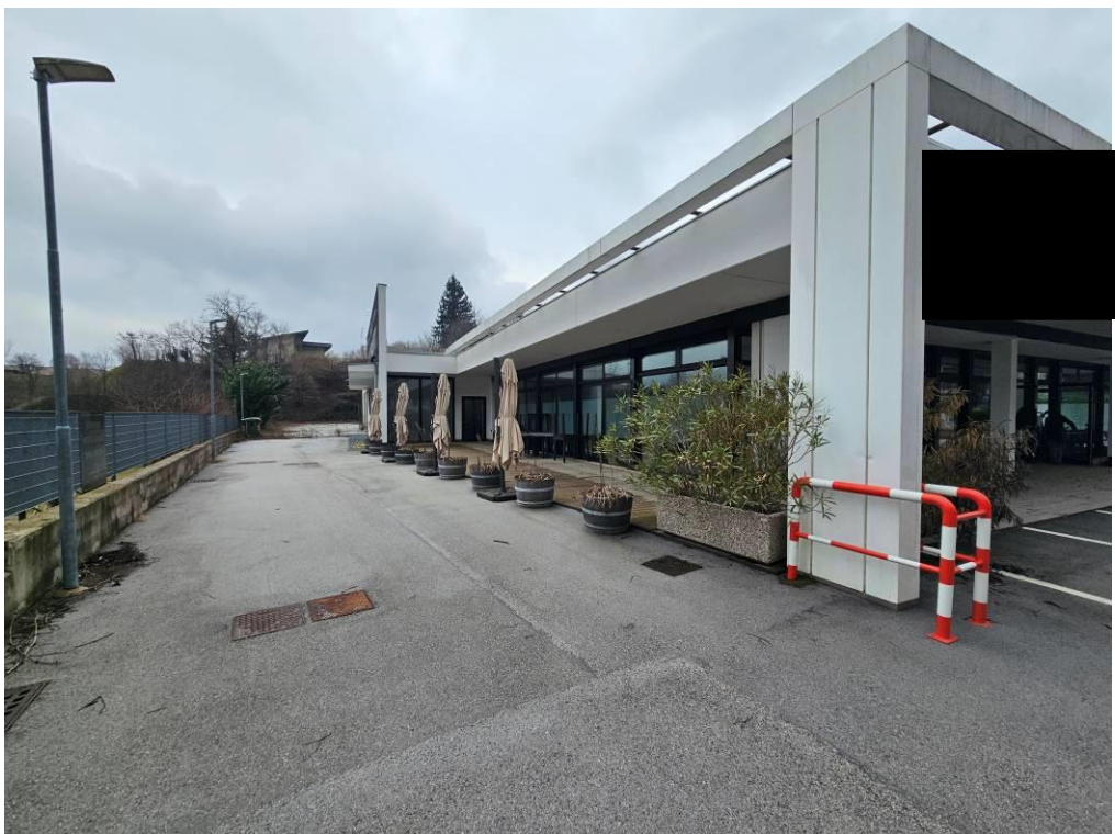
Vista lato Est
