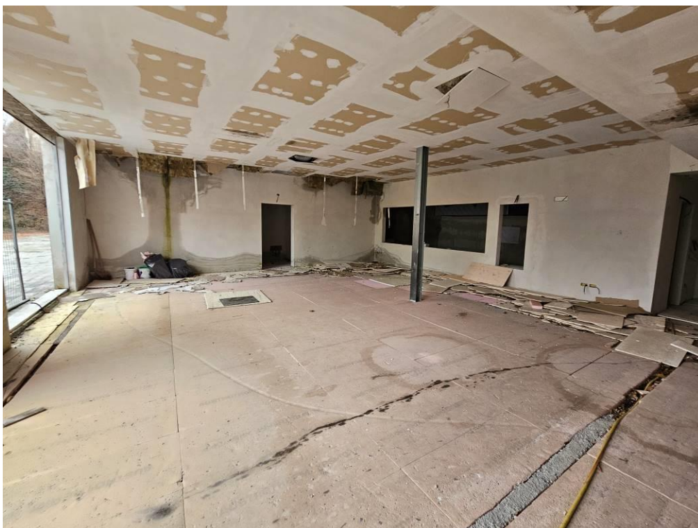
sala degustazioni e blocco nuovi bagni (al grezzo)
