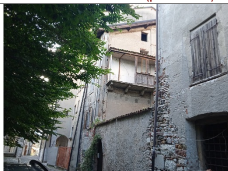
Foto 7. VISTA ESTERNA (panoramica)
