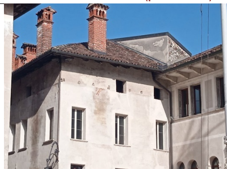
Foto 4. VISTA ESTERNA (particolare)
