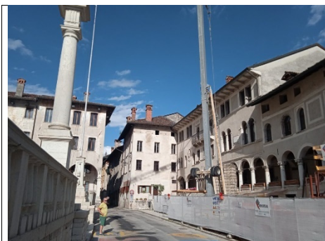
Foto 1. VISTA ESTERNA (panoramica)
