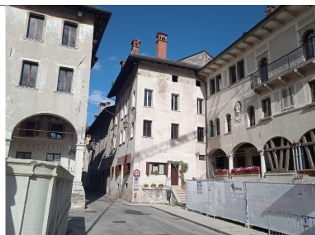
Foto 2. VISTA ESTERNA (panoramica)
