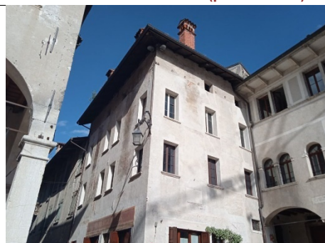
Foto 3. VISTA ESTERNA (panoramica)
