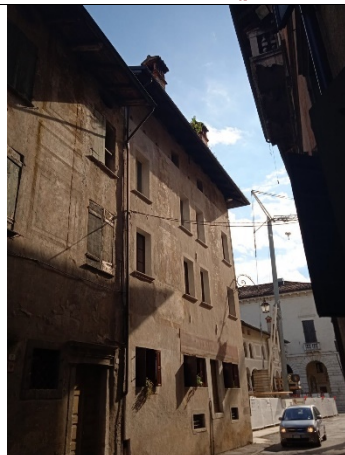
Foto 5. VISTA ESTERNA (panoramica)
