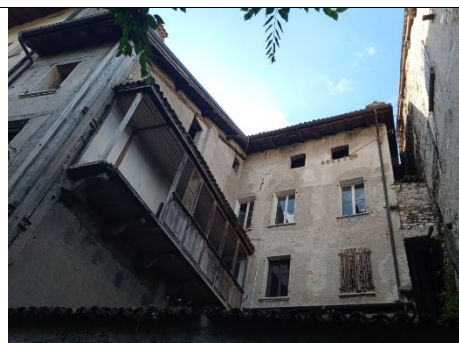
Foto 8. VISTA ESTERNA (panoramica)
