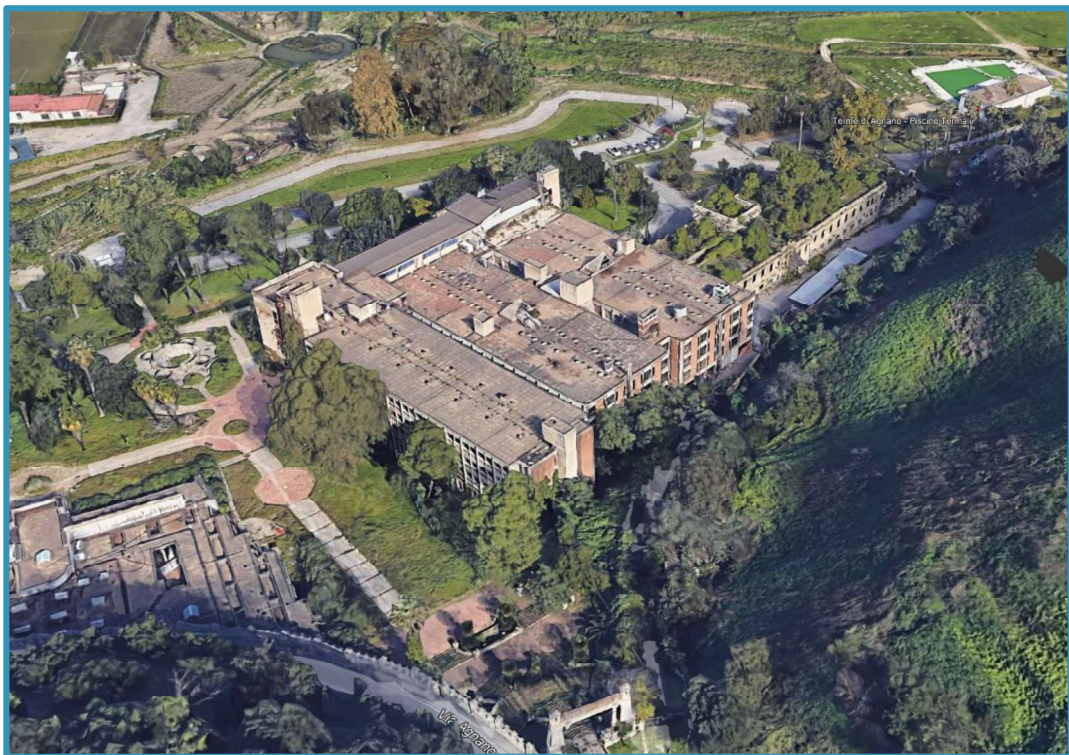
Figura 4 - Vista satellitare con indicazione della struttura adibita ad albergo oggetto della proposta di Concordato Preventivo e della presente relazione di stima
