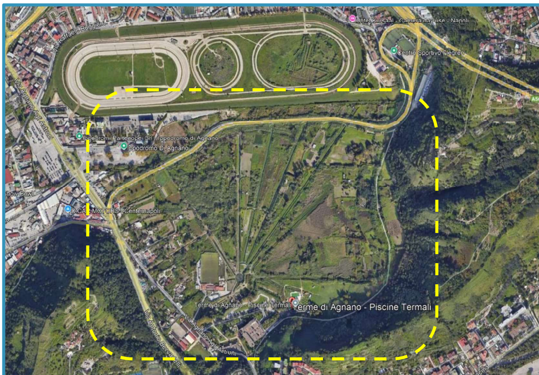
Figura 2 - Vista satellitare con indicazione qualitativa dell'intero complesso immobiliare “Terme di Agnano”
