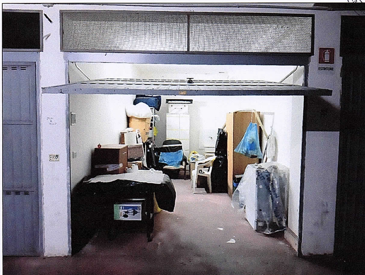
Foto 14_Piano interrato_Il garage
