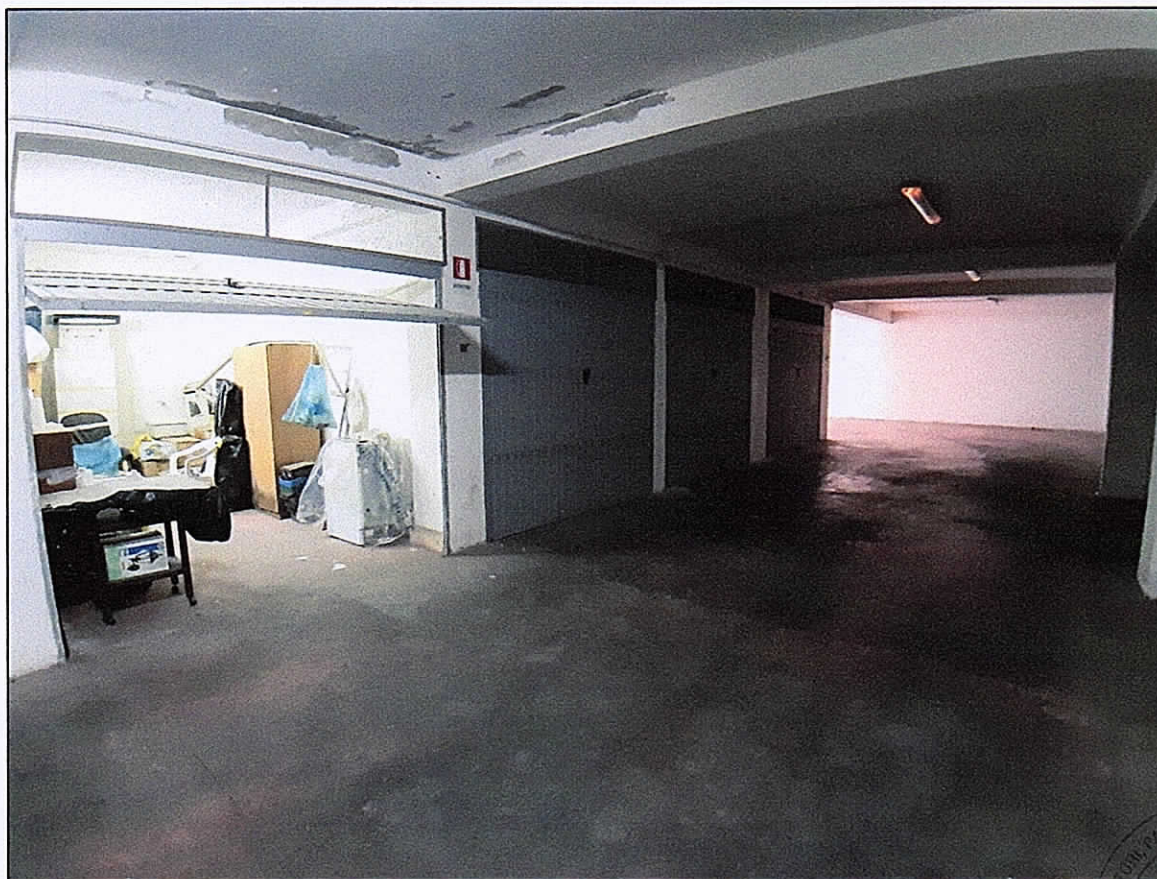
Foto 13_Piano interrato_Vista garage dalla corsia carrabile
