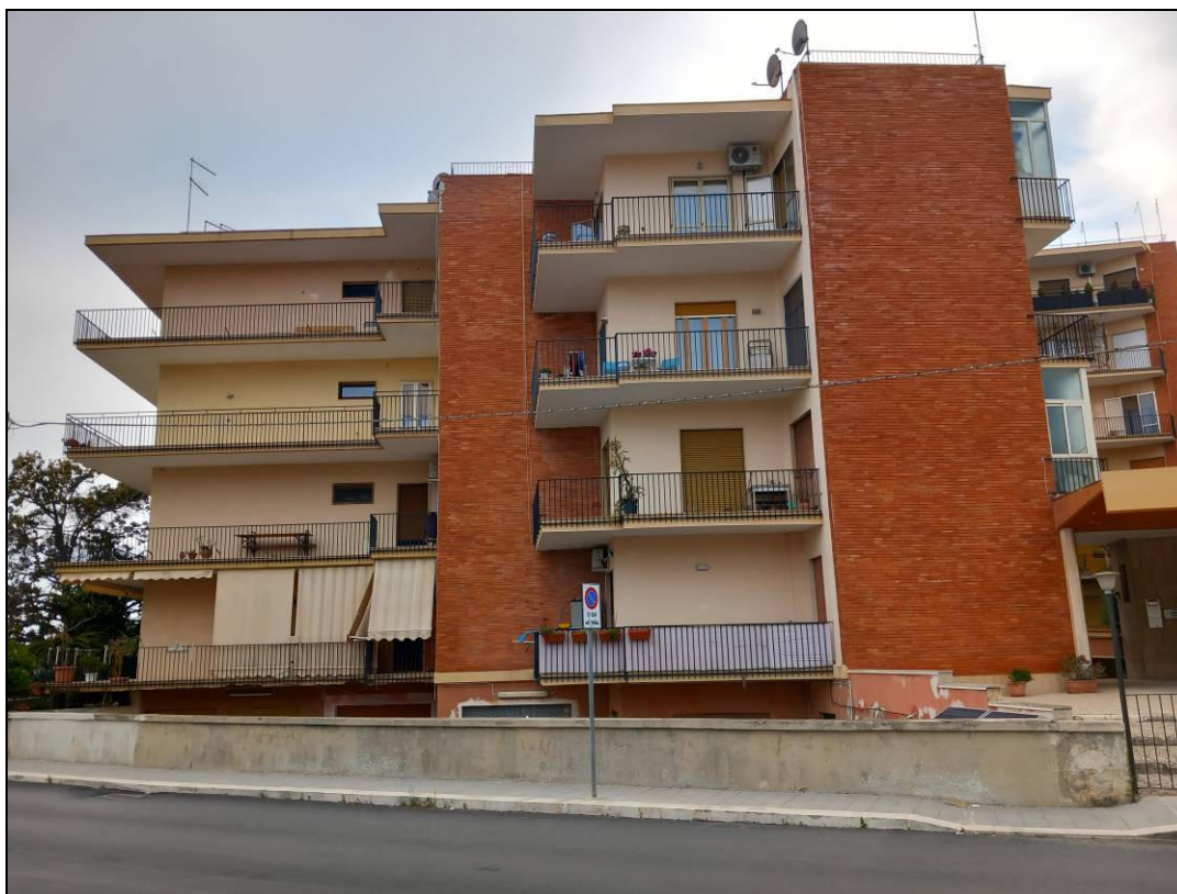
Foto 2: Vista della scala A su Via dell'Olimpiade in cui ricade il bene oggetto della procedura
