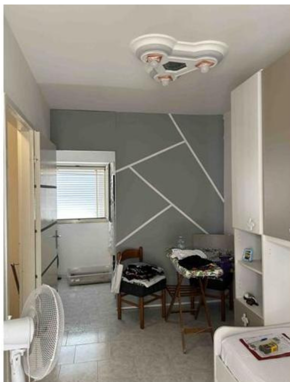
Foto n° 24 – Foto scattata nella camera del primo piano. E' visibile sul soffitto un corpo illuminante con tubazione sottotraccia, mentre sul fondo una parete in cartongesso rifinita non riportata nella planimetria catastale. Tutte le pareti sono intonacate e tinteggiate con idropittura.
