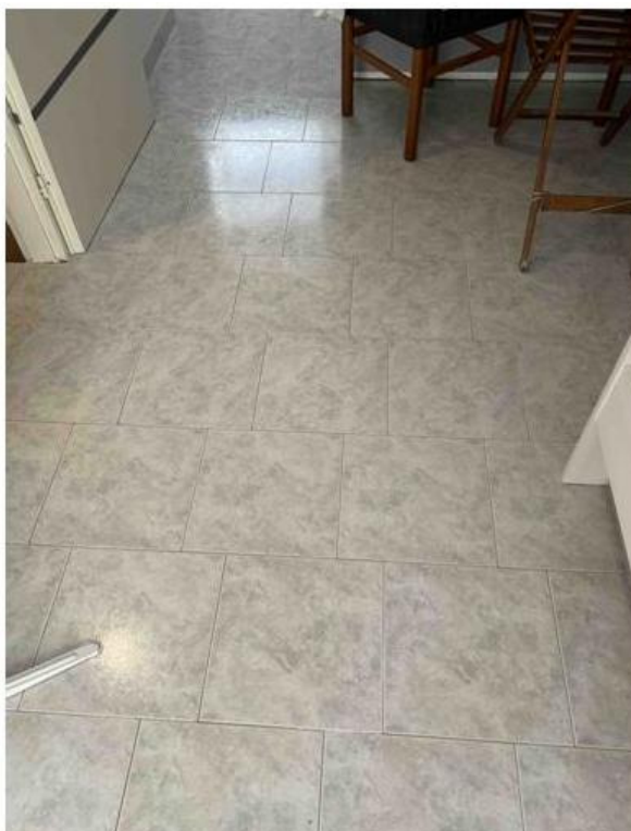
Foto n° 23 – Foto scattata nella camera che si trova al primo piano. La pavimentazione è in gres porcellanato. Ottime le condizioni.
