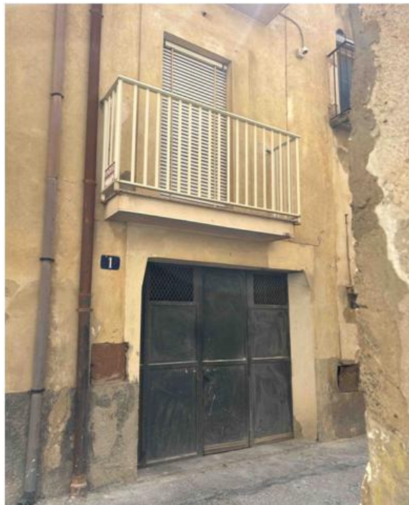
Foto n° 6 – Vista del prospetto del garage/box del piano terra su via Polizzi.
