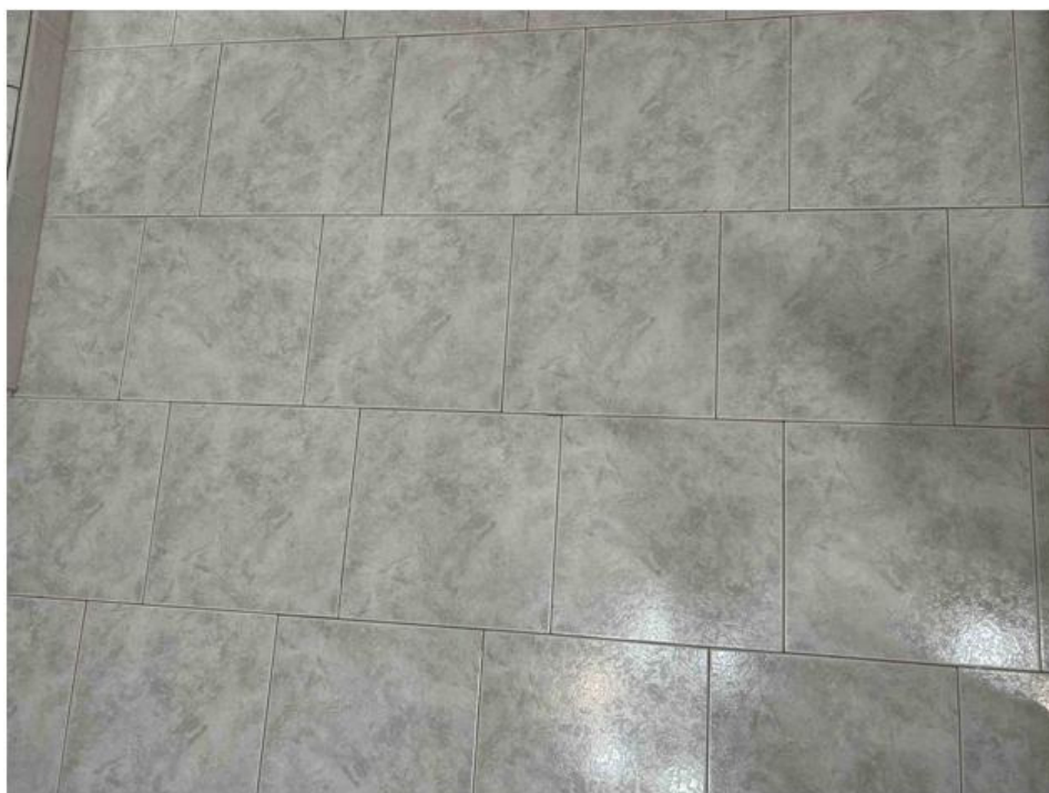
Foto n° 17 – Foto scattata nella prima camera che si trova al piano terra. La pavimentazione è in gres porcellanato. Ottime le condizioni.
