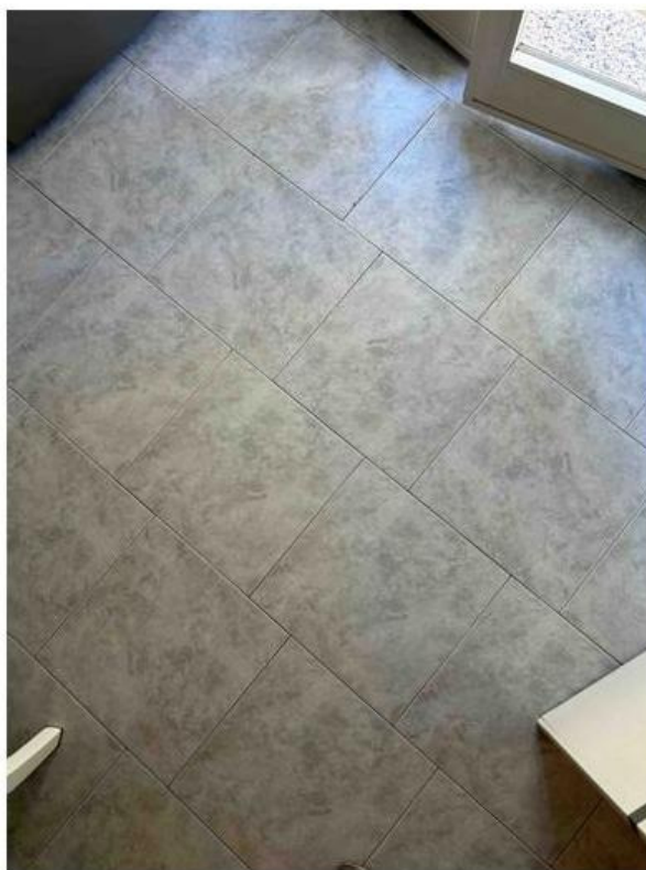
Foto n° 38 – Foto scattata nella camera che si trova al secondo piano. La pavimentazione è in gres porcellanato. Ottime le condizioni.
