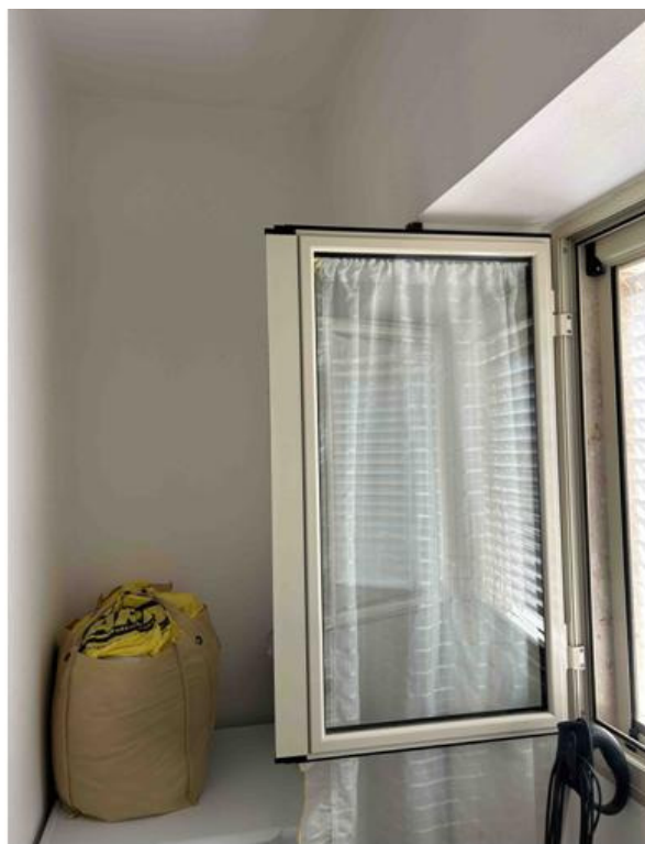
Foto n° 25 – Foto scattata nel vano del primo piano realizzato oltre la parete in cartongesso. Tutte le pareti sono intonacate e tinteggiate con idropittura. E' presente una finestra a due ante invece della porta-balcone che consente l'affaccio su via Leone.
