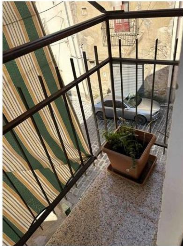
Foto n° 30 – Altra foto scattata al ballatoio esterno che consente l’affaccio su via Polizzi. La ringhiera è in ferro pieno in buone condizioni mentre la pavimentazione è in granito.
