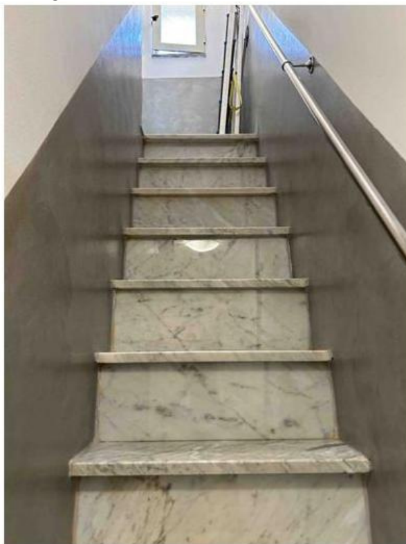
Foto n° 32 – Foto scattata alla seconda rampa della scala interna che consente l'accesso al secondo piano. Le pareti sono intonacate e tinteggiate con due tecniche e colorazioni differenti, spatolato fino all'altezza di 1,00 metro ed idropittura nella parte superiore.
