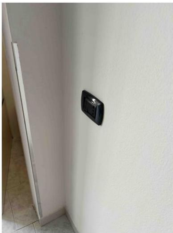
Foto n° 36 – Foto scattata ad uno degli interruttori elettrici del corpo illuminante della cucina realizzato con tubazione sottotraccia. Buone le condizioni.
