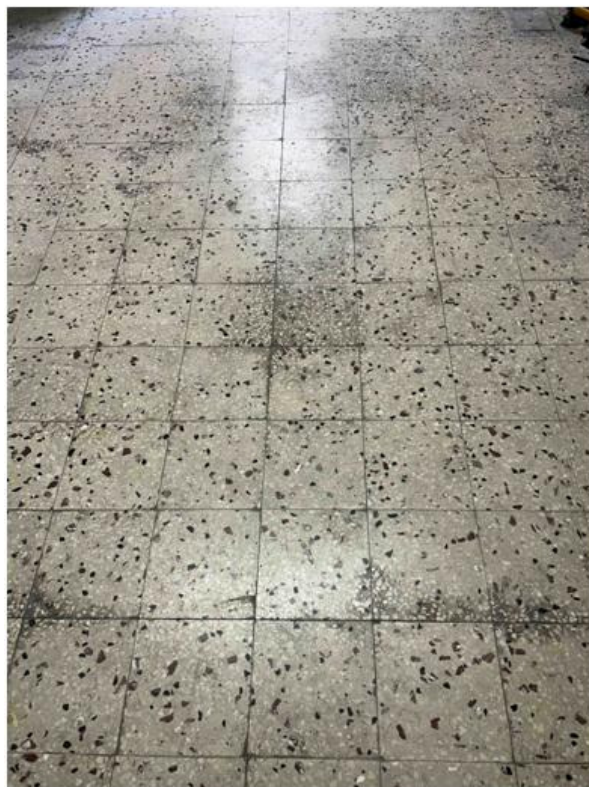
Foto n° 9 – Foto scattata alla pavimentazione in scaglietta di marmo.
