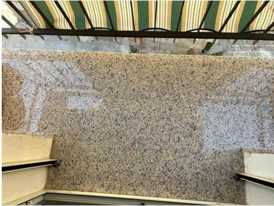
Foto n° 29 – Foto scattata al ballatoio esterno che consente l’affaccio su via Polizzi. La ringhiera è in ferro pieno in buone condizioni mentre la pavimentazione è in granito.
