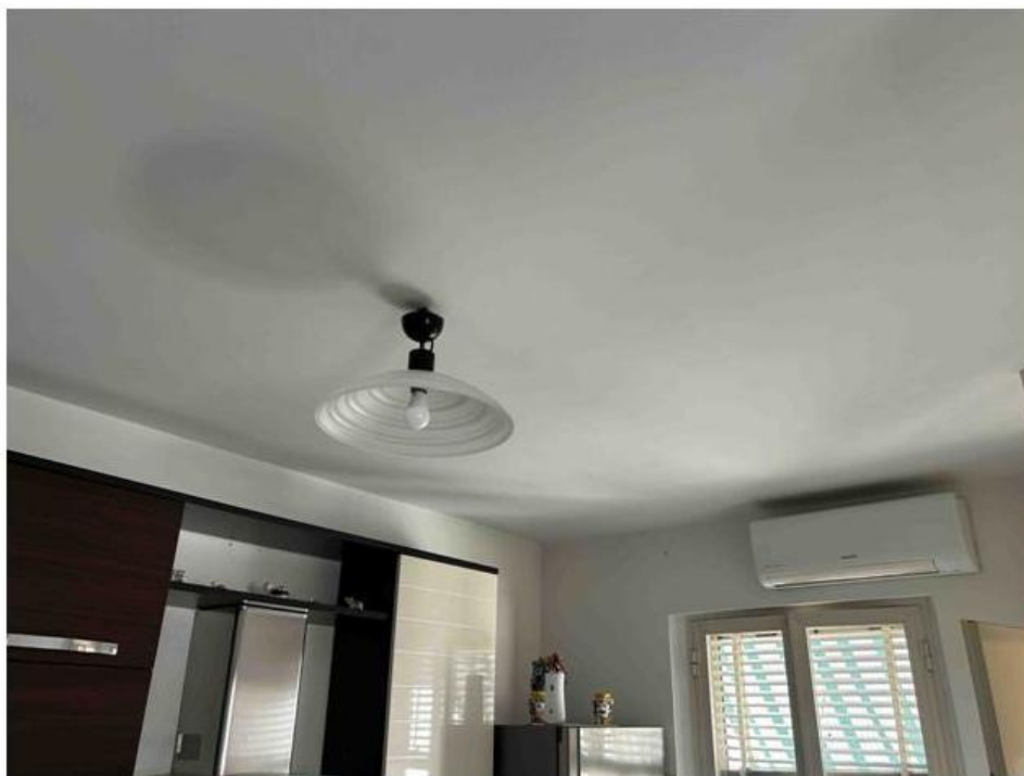
Foto n° 41 – Foto scattata al corpo illuminante posto nel soffitto. La tubazione dell'impianto elettrico è sottotraccia ed a norma. Ottime le condizioni generali.
