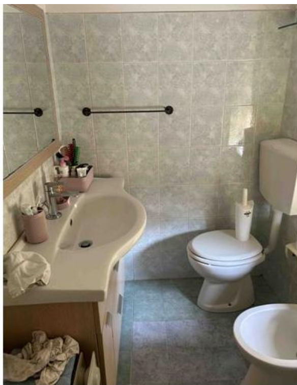
Foto n° 43 – Foto scattata all'interno del bagno. La pavimentazione ed il rivestimento è stato realizzato con piastrelle in maiolica delle dimensioni di cm 20x25 cm fino all'altezza di 1,75 m. Sono collocati un lavabo con mobile, un vaso igienico con cassetta in pvc ed un bidet, tutti di discreto livello e qualità.
