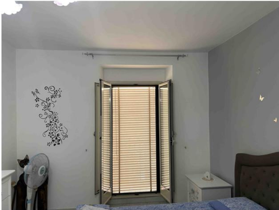
Foto n° 15 – Altra foto scattata nella prima camera che si trova al piano terra. Le pareti sono intonacate e tinteggiate con idropittura e l'infisso a due ante è in alluminio preverniciato.
