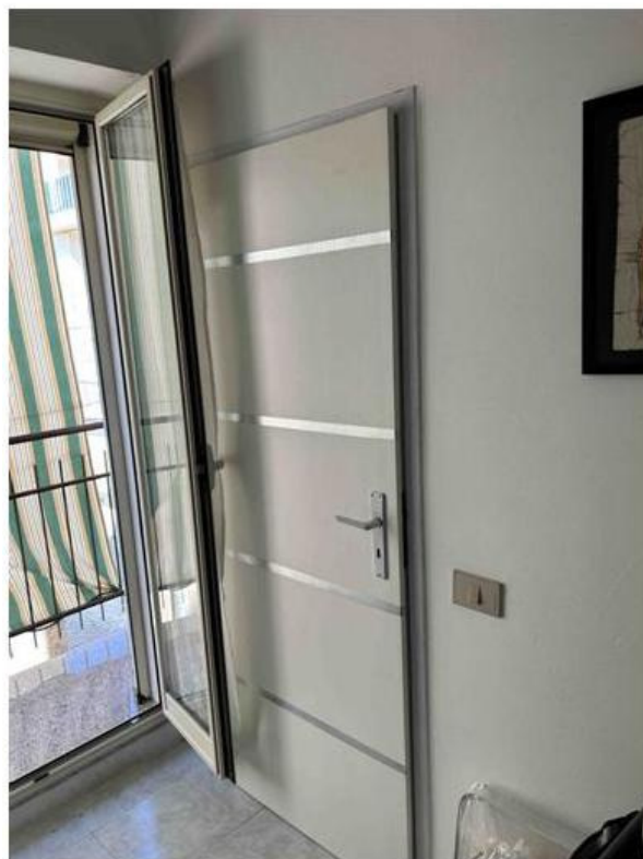
Foto n° 27 – Altra foto scattata nel vano del primo piano adibito a camera. Le pareti sono tutte intonacate e tinteggiate. E' presente un infisso in alluminio pre-verniciato a due ante che consente l'affaccio su via Polizzi mentre dalla porta in legno si può accedere alla lavanderia realizzata nel sottoscala.
