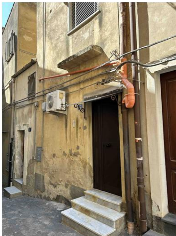
Foto n° 4 – Altra vista del prospetto di via Leone, in particolare del portone di ingresso del piano terra.
