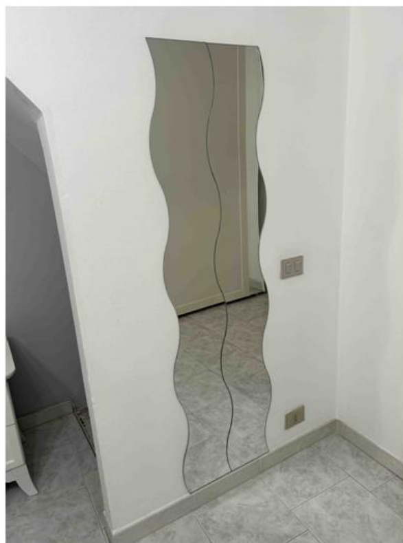
Foto n° 18 – Altra foto scattata nella prima camera che si trova al piano terra. Le pareti sono intonacate e tinteggiate con idropittura; si rilevano gli interruttori dell'impianto elettrico
