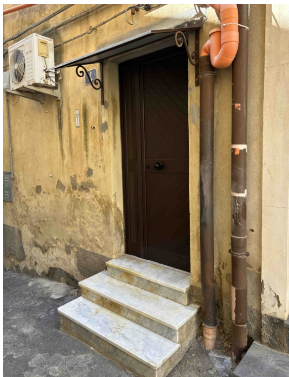
Foto n° 11 – Foto scattata al portone di ingresso su via Leone che consente l'accesso al numero civico 4. L'ingresso è rialzato rispetto alla quota della sede stradale. La porta è in alluminio pre-verniciato a due ante, di cui una semi-fissa.
