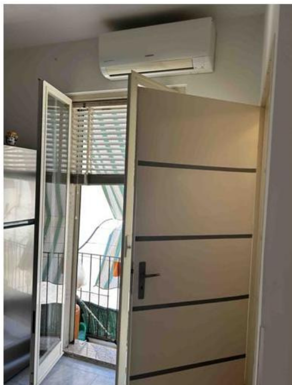
Foto n° 33 – Foto scattata nel vano cucina del secondo piano. La porta di accesso è in legno laccato bianco; sul fondo si rileva un infisso a due ante in alluminio pre-verniciato che consente l'affaccio su via Polizzi oltre al climatizzatore e/o pompa di calore.
