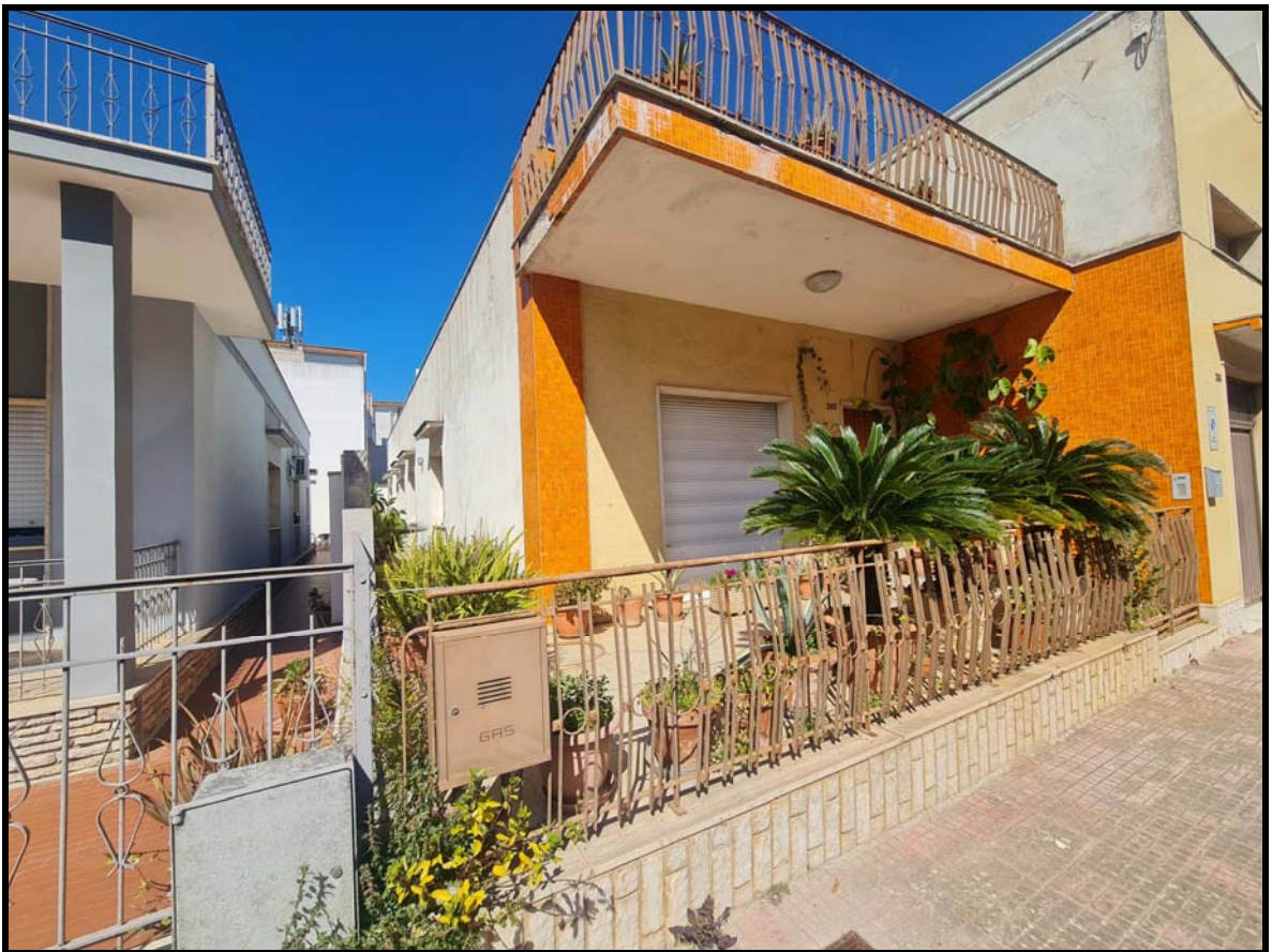
foto n° 1-2 : Rilievo fotografico esterno - prospetto
