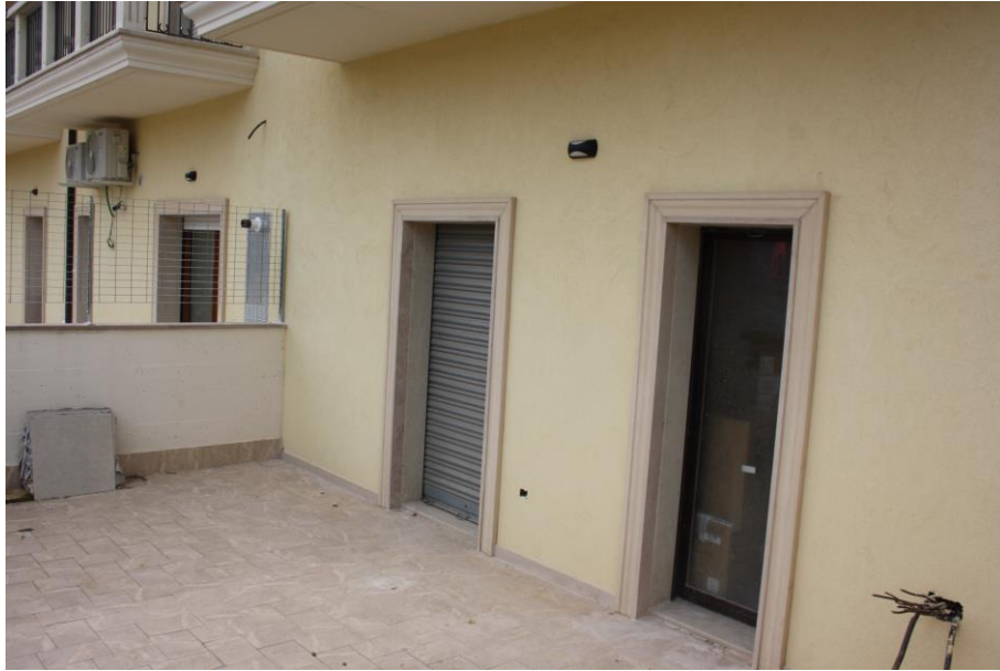
Vista del patio posto sul retro
