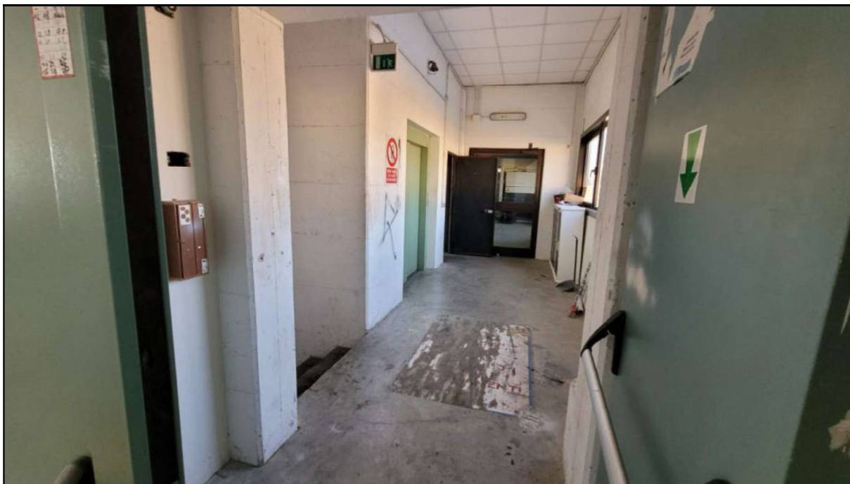
Foto 37: vano scala posteriore
