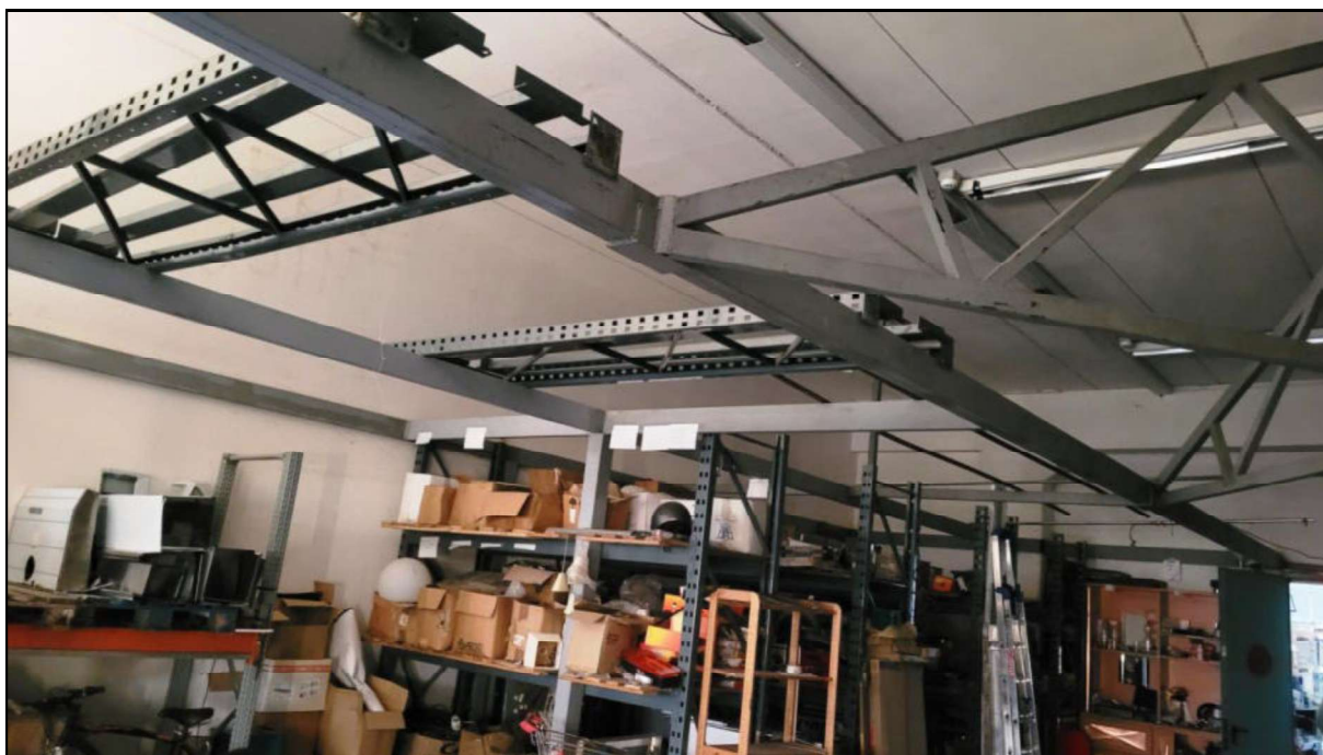
Foto 29: locale magazzino con vista soppalco
