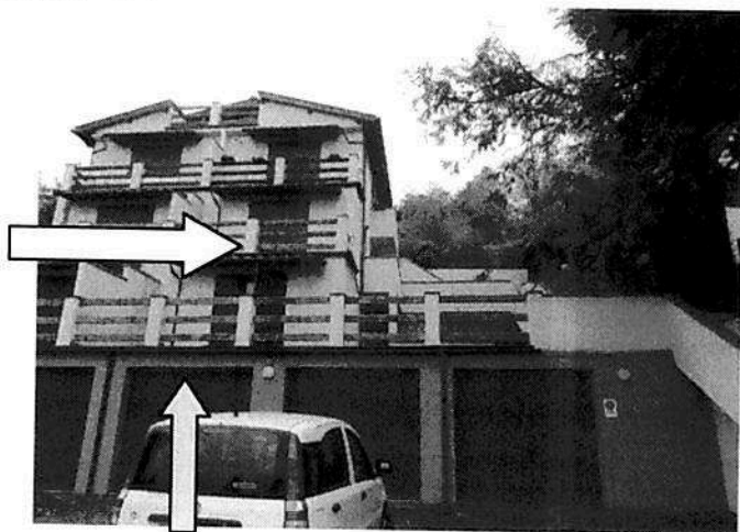
Garage sub4–freccia gialla
