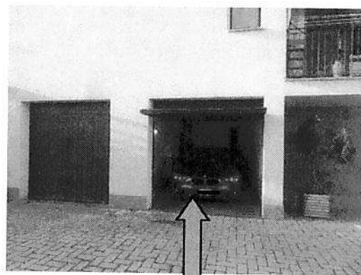
Garage sub 528 –freccia azzurra
