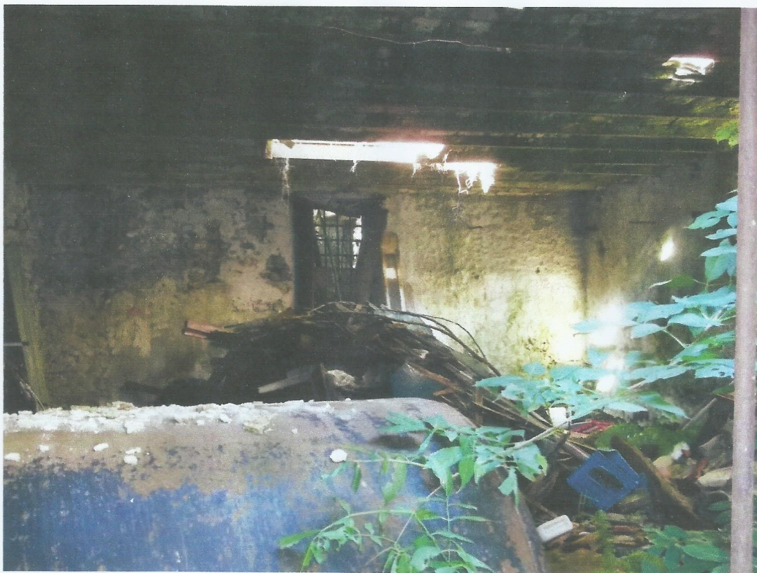
VISTA INTERNA MAGAZZINO
