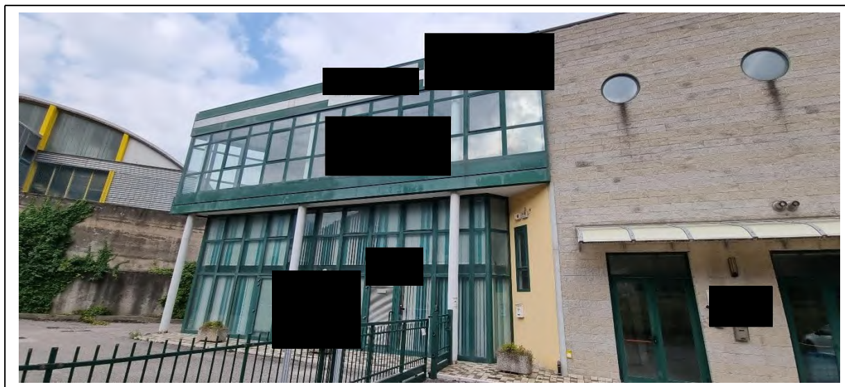
Vista sud-est - facciata sala esposizione PIANO PRIMO
