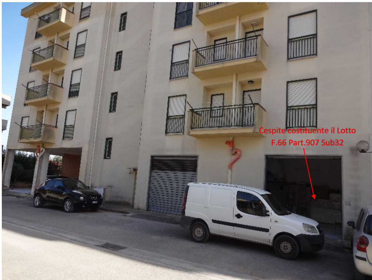
Foto 4-Prospetto posteriore del fabbricato
