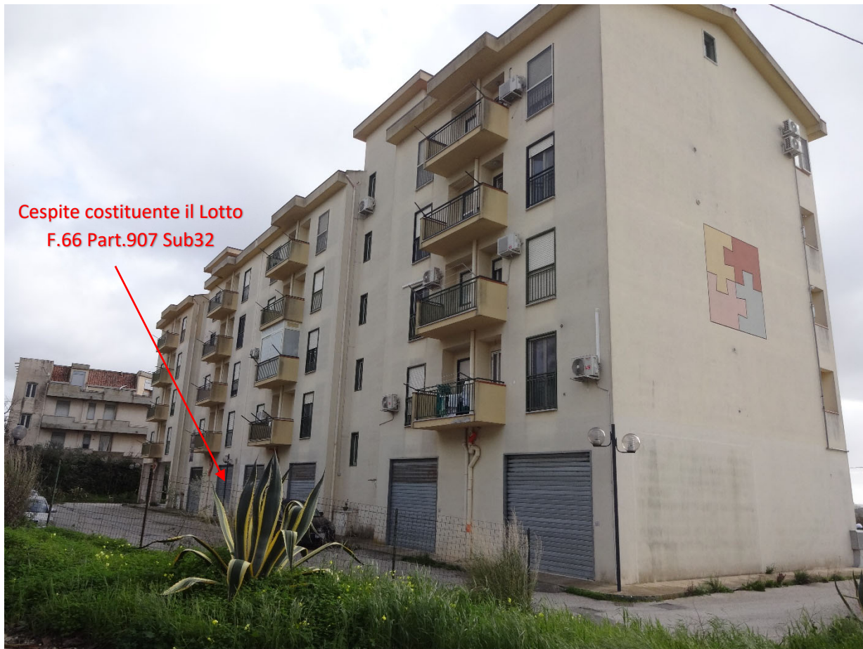
Foto 3-Prospetto posteriore del fabbricato
