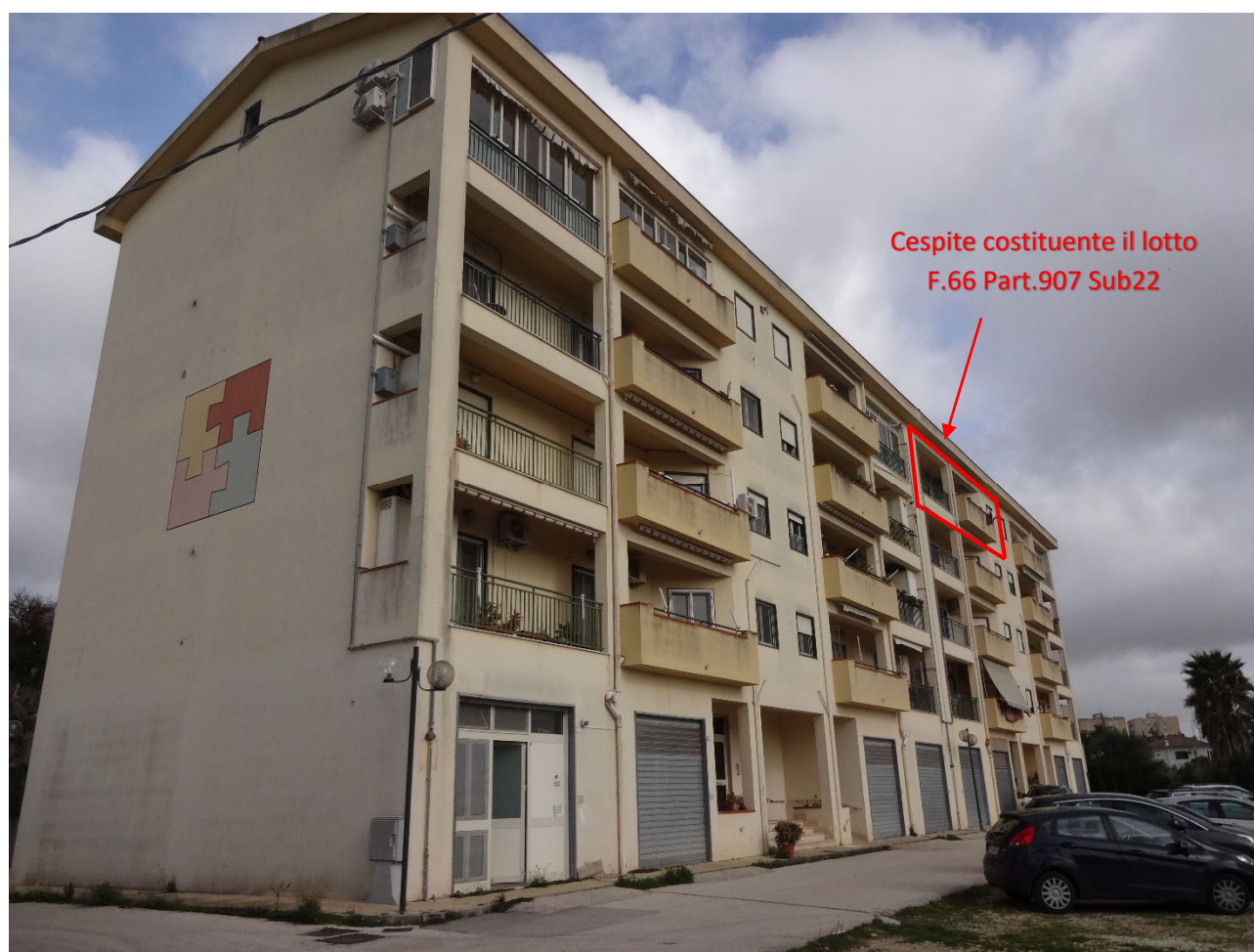
Foto 2-Prospetto principale su via Nilde Iotti
