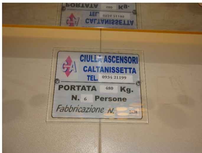
Foto 14-Caratteristiche dell'ascensore
