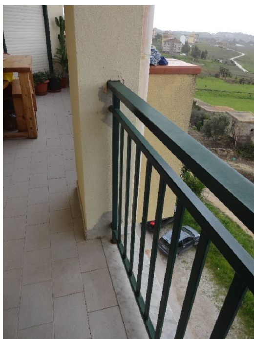
Foto 43-Veranda in corrispondenza del prospetto principale
