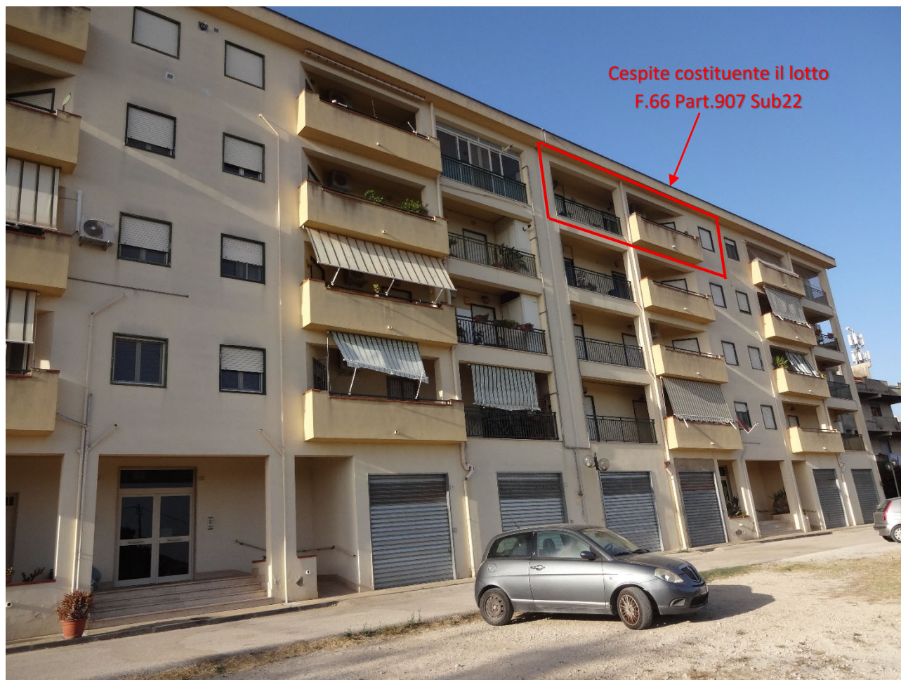
Foto 3-Prospetto principale su via Nilde Iotti
