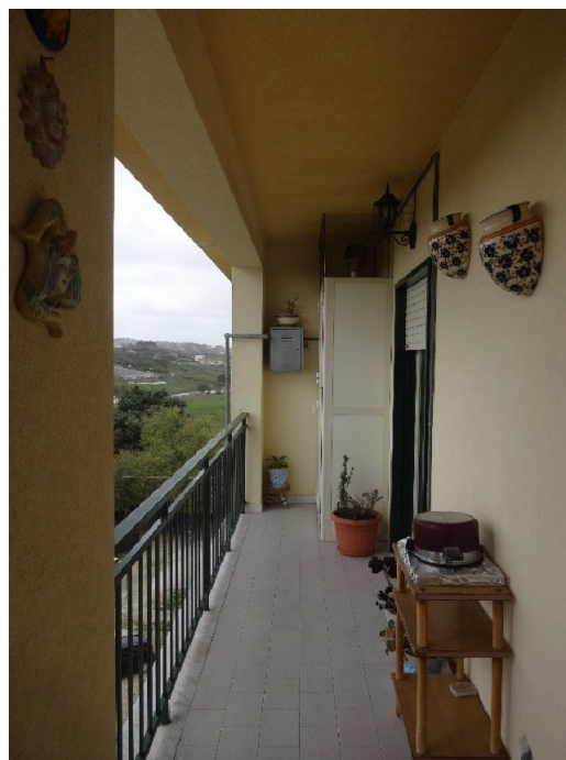
Foto 40-Veranda in corrispondenza del prospetto principale
