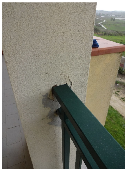
Foto 44-Veranda in corrispondenza del prospetto principale
