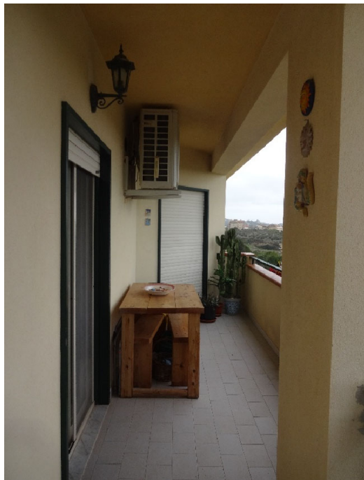
Foto 41-Veranda in corrispondenza del prospetto principale
