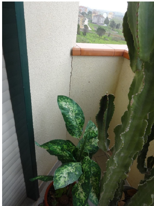
Foto 42-Veranda in corrispondenza del prospetto principale
