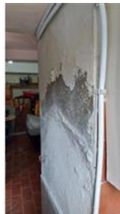
Infisso piano rialzato / Umidità piano terra
