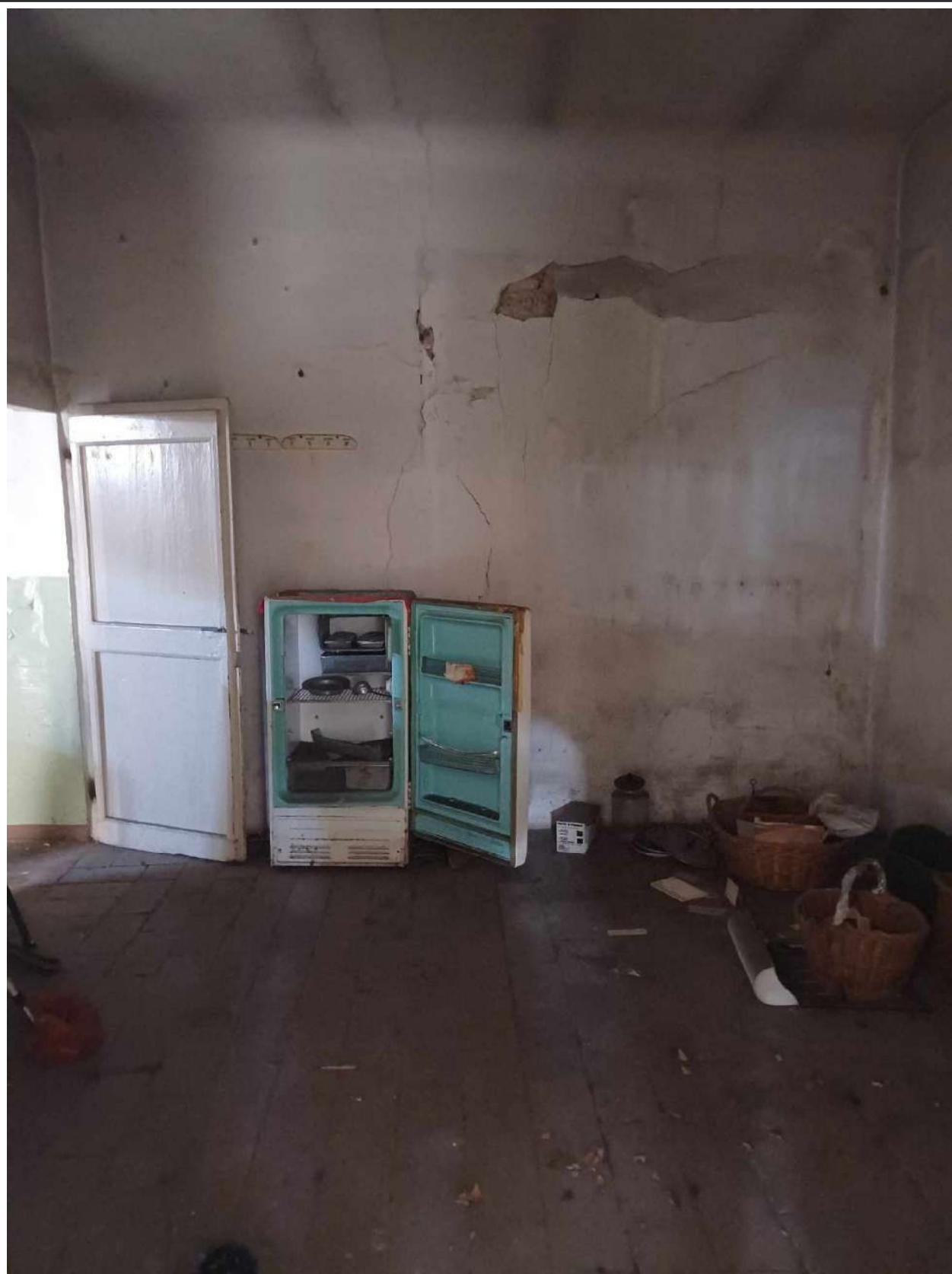
10-Vista interna della zona giorno – ripostiglio -Piano Primo
