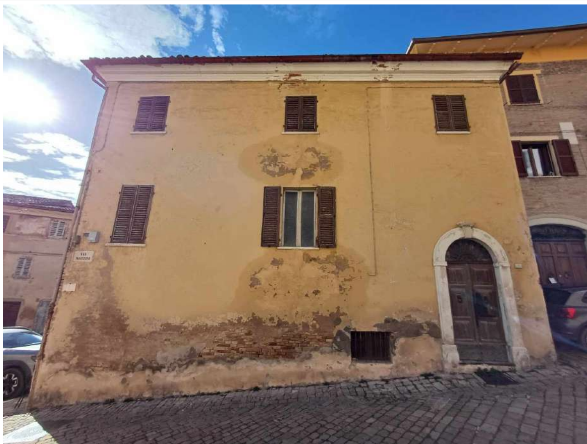
2- Vista da Via Mazzini —
