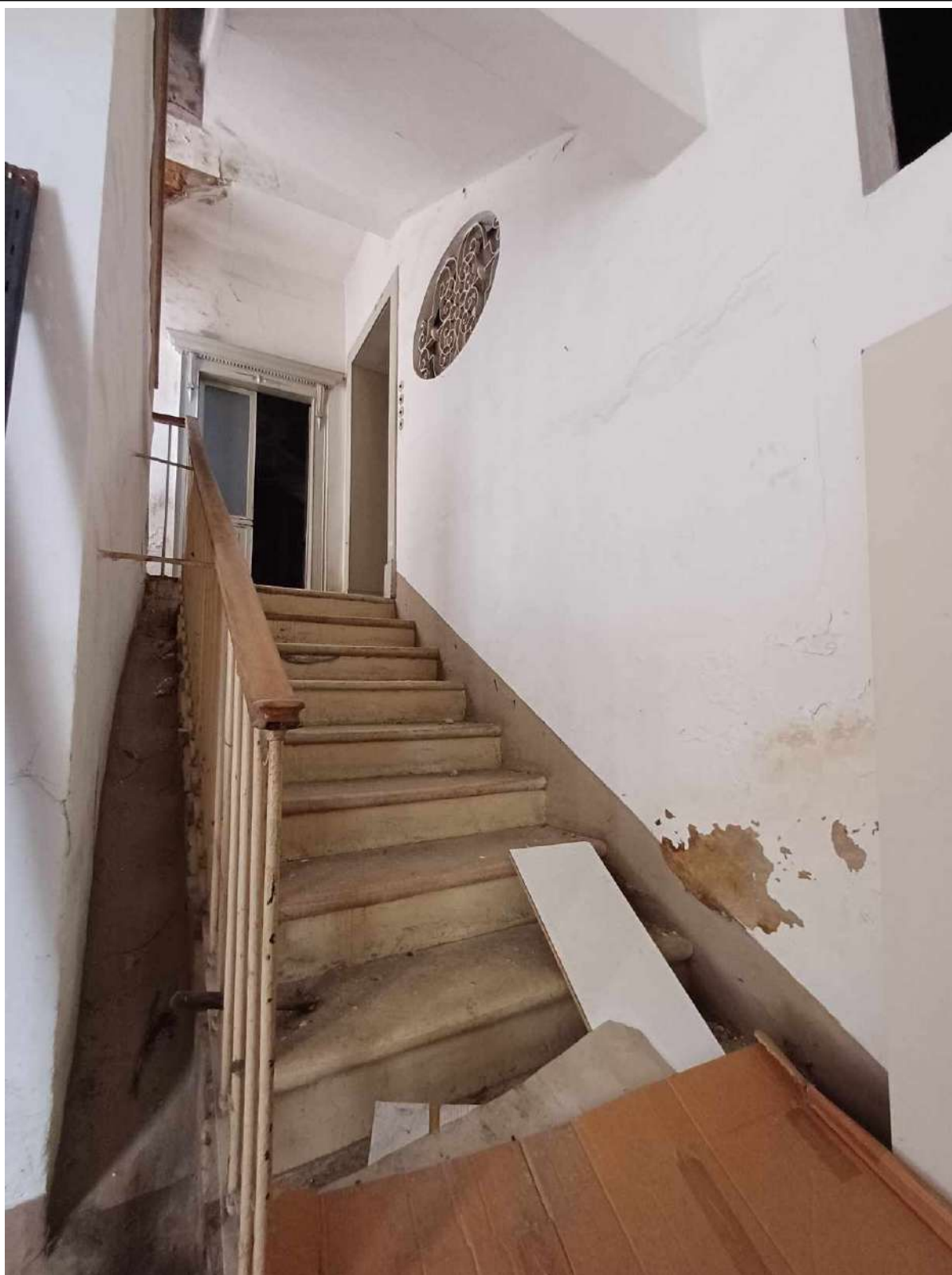
5-Vista interna della scala di accesso all'appartamento al Piano Primo
