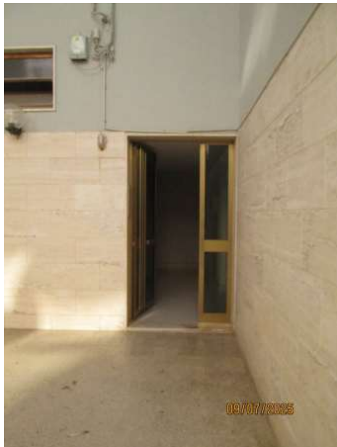
Foto n. 05: Portone condominiale Scala "A"
