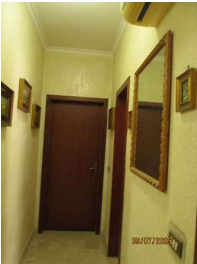
Foto n. 18: Porzione a Nord Ovest del corridoio
