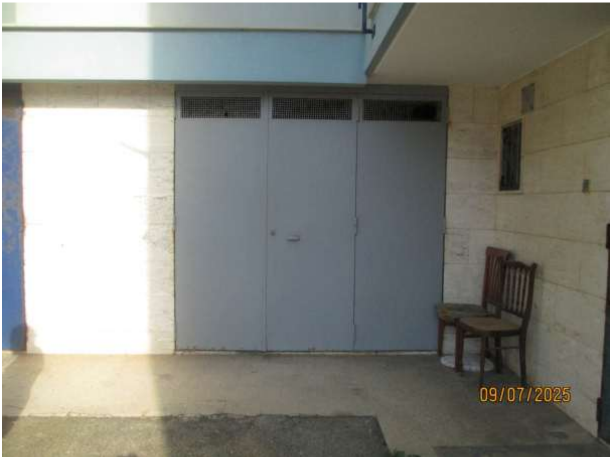
Foto n. 28: Portone carrabile dell'autorimessa al piano terra
